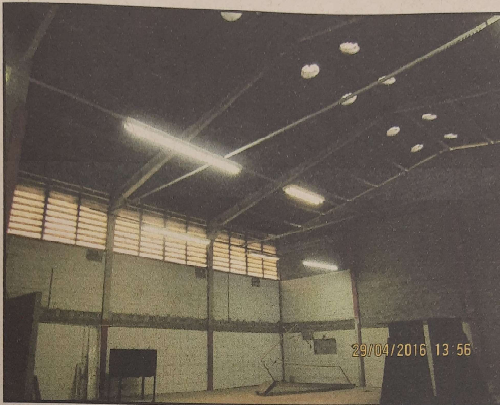
Vista da área principal do galpão
