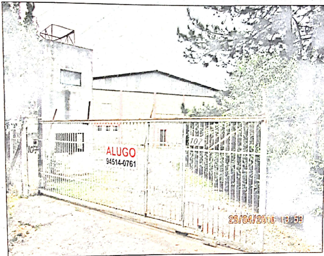
Vista frontal do imóvel
