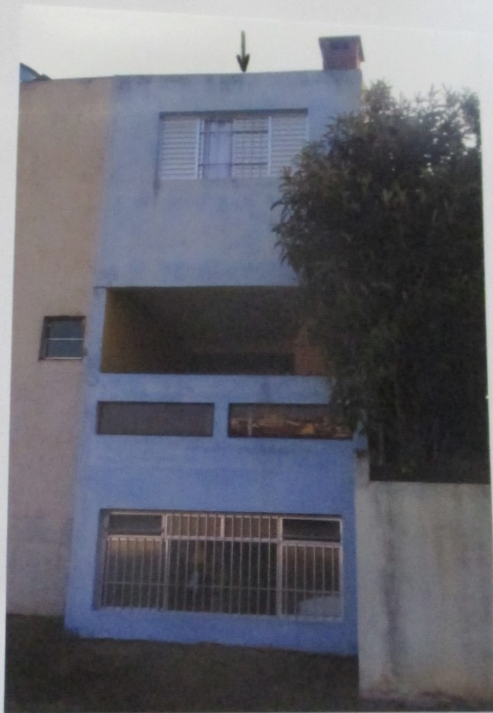
FOTO nº 05: Vista dos fundos da casa avalianda com uma área de serviço no sub solo e janela no nível do gramado; uma área sem janela ao lado da cozinha com churrasqueira; e o pavimento superior com dormitório.
