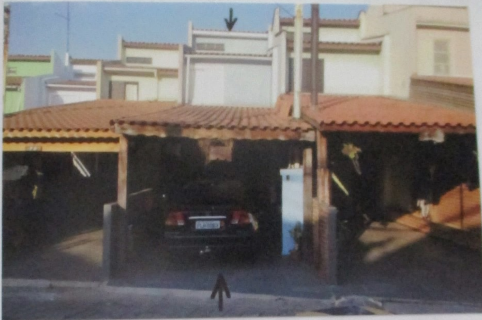
FOTO nº 01: Vista da casa avalianda, nº 04 (indicada por seta), localizada na Rua Dois da quadra "F" do Condomínio Residências Parque do Carmo.
