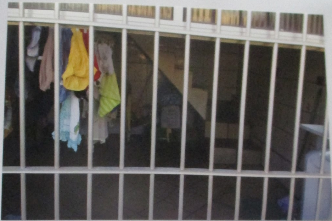
FOTO nº 08: Vista da área de serviço no subsolo, com janela no nível do gramado, que se situa nos fundos da edificação.
