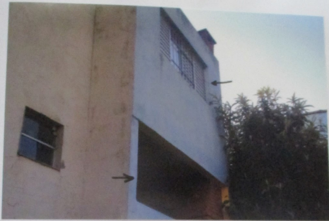
FOTO nº 06: Vista da janela dos fundos da casa avalianda no pavimento superior onde se situam os dormitórios; e da área sem janela com churrasqueira que se situa ao lado da cozinha.
