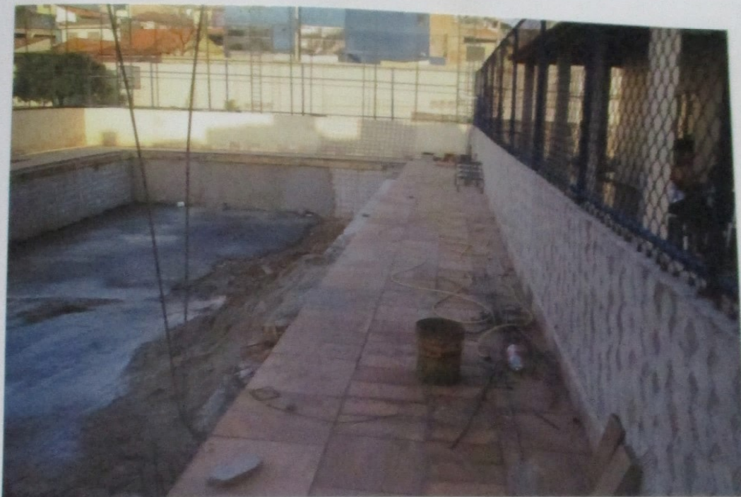
FOTO nº 10: Vista da piscina em reforma do Condomínio Residências Parque do Carmo.
