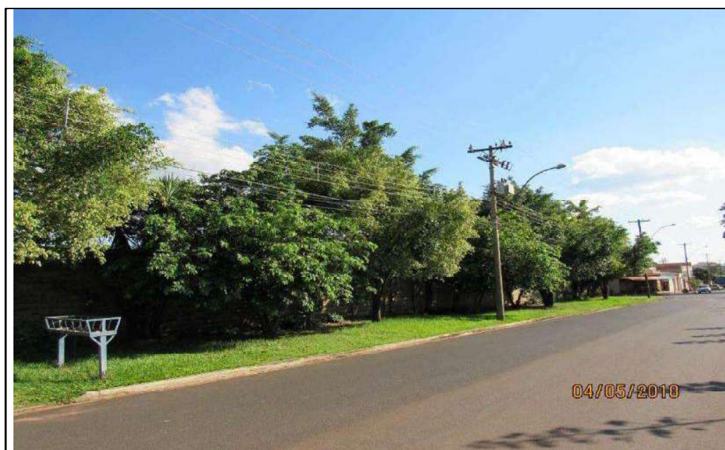
FOTO 54 – Vista geral do muro frontal do imóvel.
