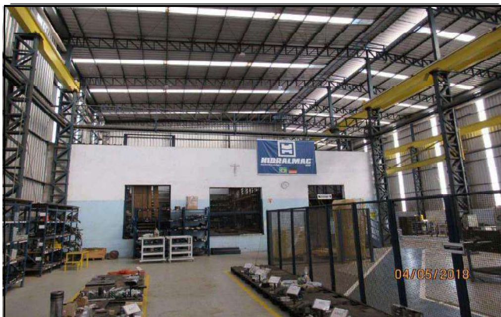
FOTO 19 – Vista geral frontal do almoxarifado com paredes de alvenaria.
