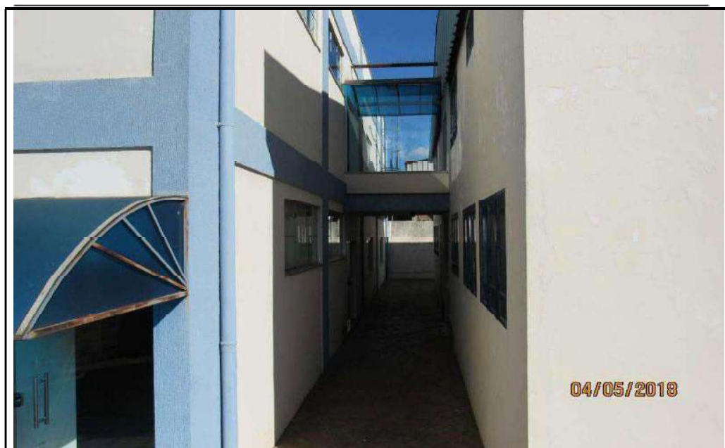
FOTO 28 – Vista entre o prédio e o barracão onde podemos observar o acesso entre eles na parte assobradada.
