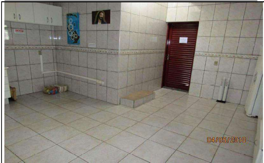
FOTO 42 – Vista geral interna do imóvel.
