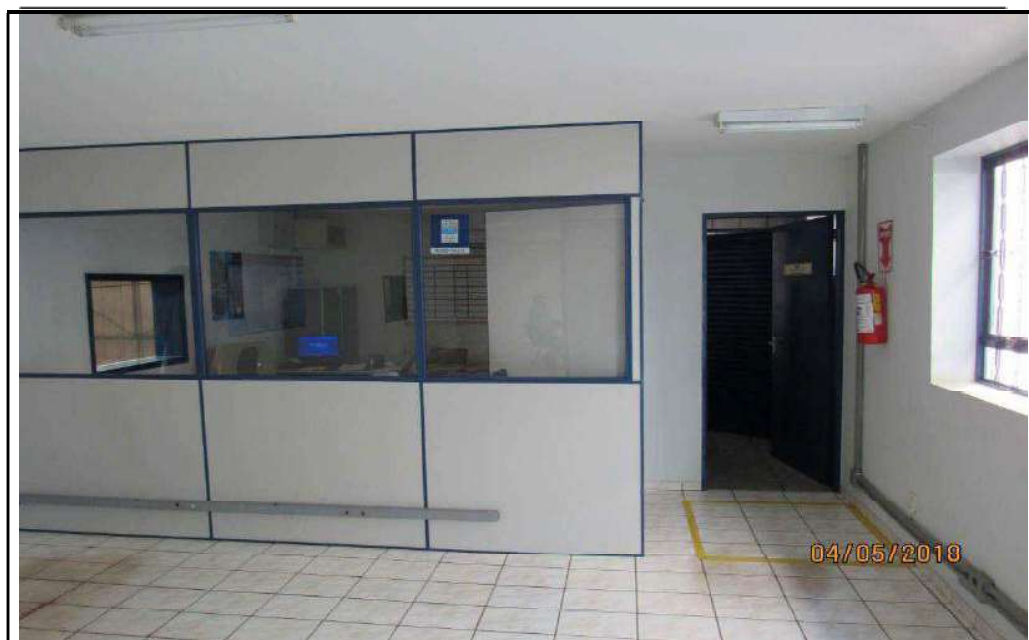
FOTO 32 – Vista geral interna da edificação.
