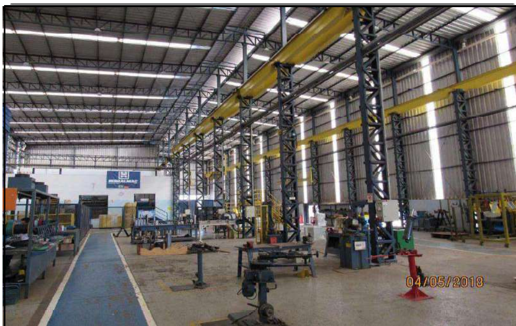
FOTO 15 – Vista geral do barracão de serviços da empresa HIDRAL-MAC.
