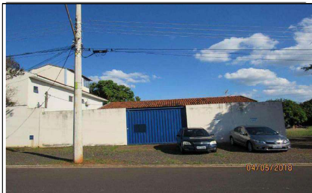
FOTO 38 – Vista geral externa do portão para acesso direto às edificações.
