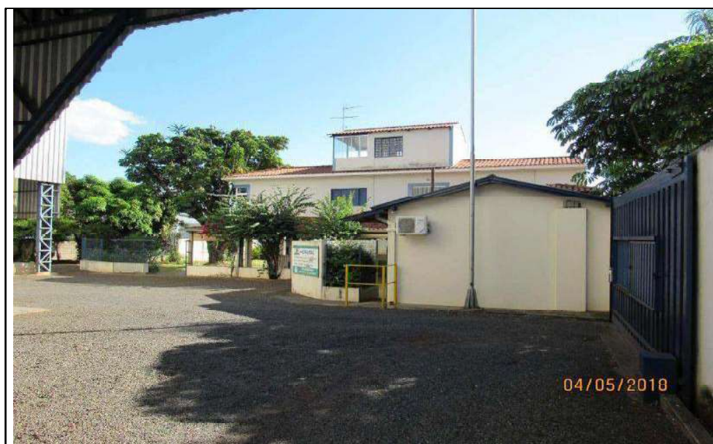
FOTO 39 – Vista geral frontal da edificação.
