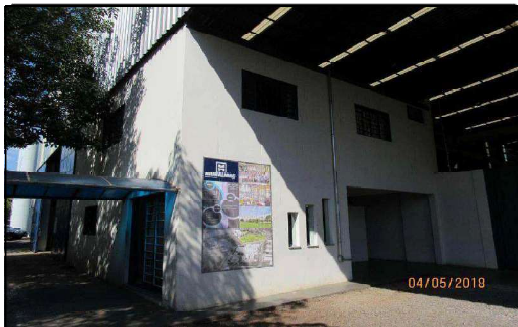
FOTO 09 – Vista geral frontal da parte do imóvel onde se situa a recepção e sala de espera.
