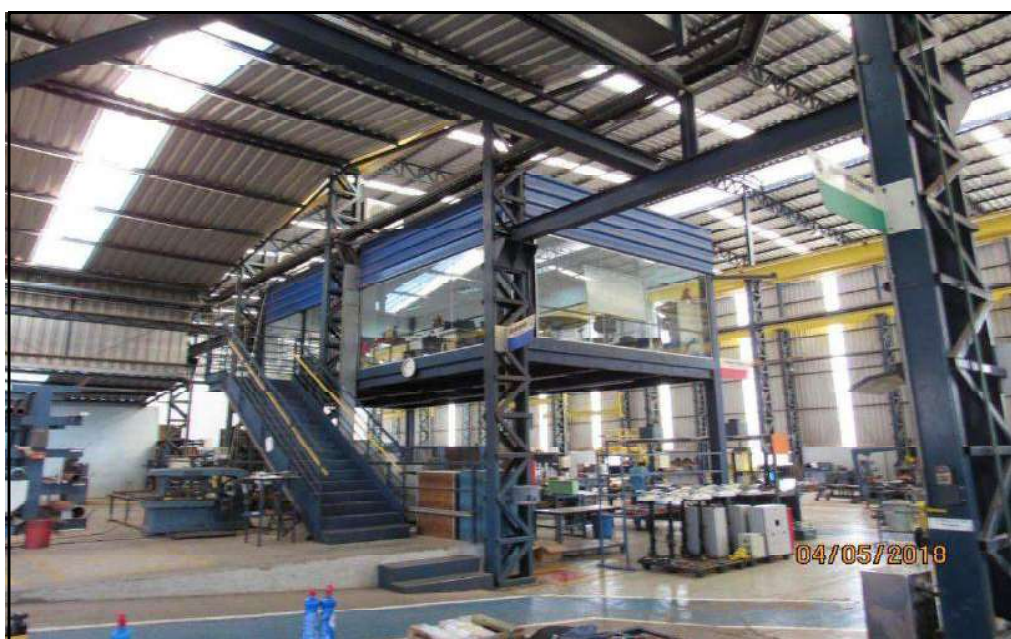
FOTO 14 – Vista geral do barracão de serviços e do mezanino metálico onde se localiza um escritório.
