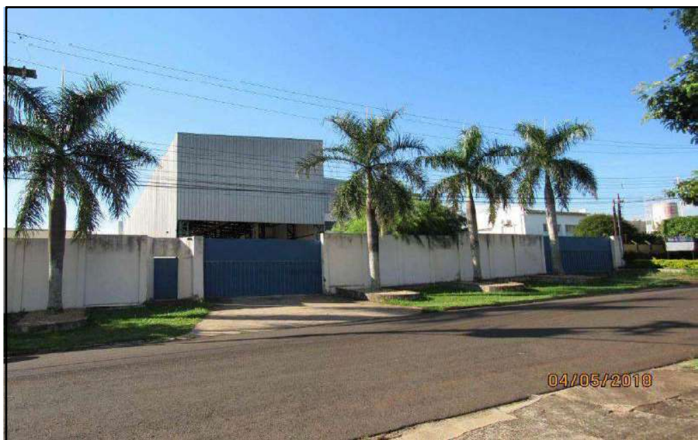
FOTO 08 – Vista geral da fachada de fundos do imóvel.
