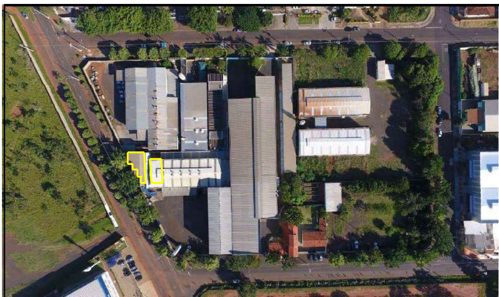
FOTO 25 – Vista aérea com contorno amarelo delimitando a área descrita acima.
