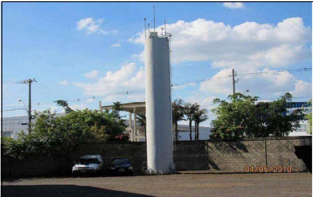
FOTO 22 – Vista de castelo d'água situado na área externa do imóvel.
