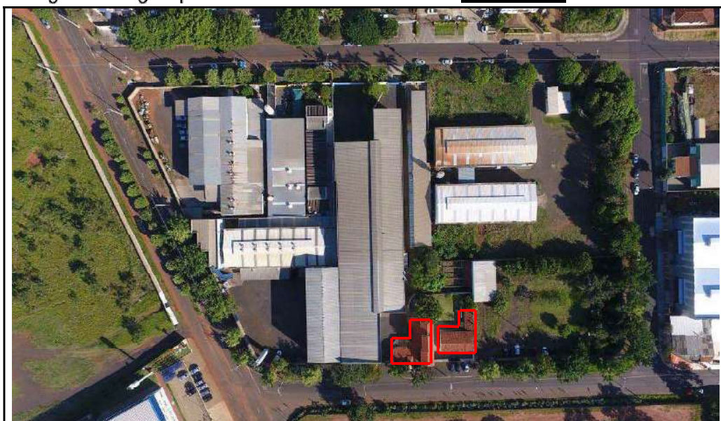
FOTO 37 – Vista geral aérea das edificações descritas acima e delimitadas no contorno vermelho.
