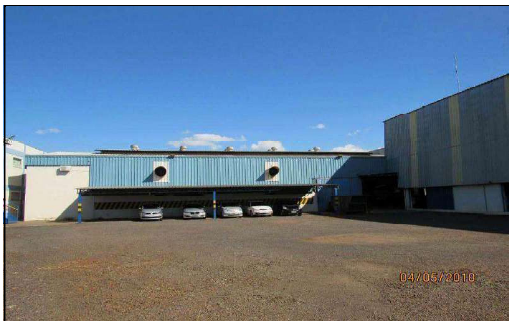
FOTO 24 – Vista frontal do estacionamento coberto.
