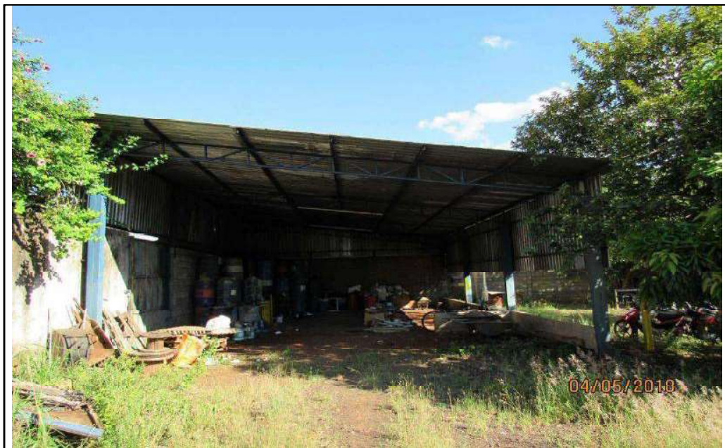
FOTO 56 – Vista geral da edificação de estrutura metálica situada no lote 06.
