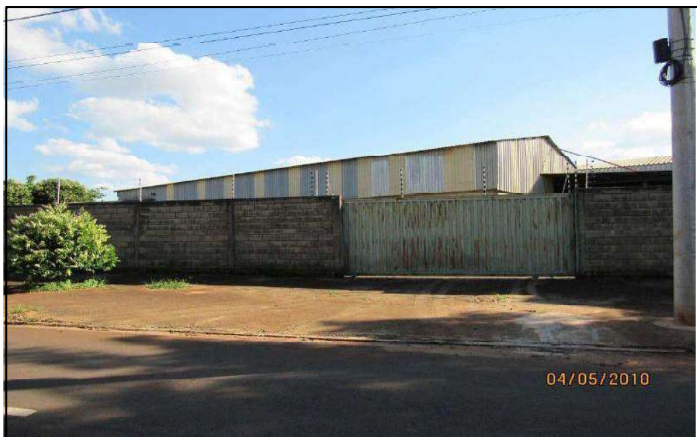
FOTO 06 – Vista geral da fachada lateral do imóvel.
