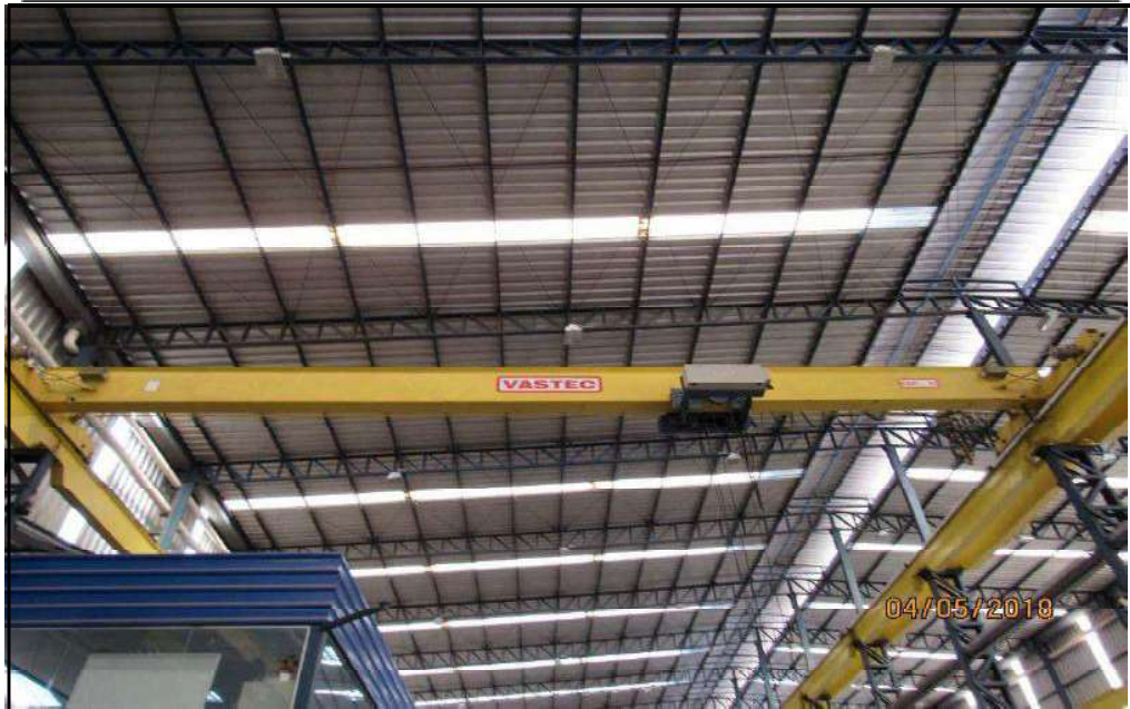
FOTO 17 – Vista geral da cobertura de telhas galvanizadas sobre estrutura metálica do barracão.
