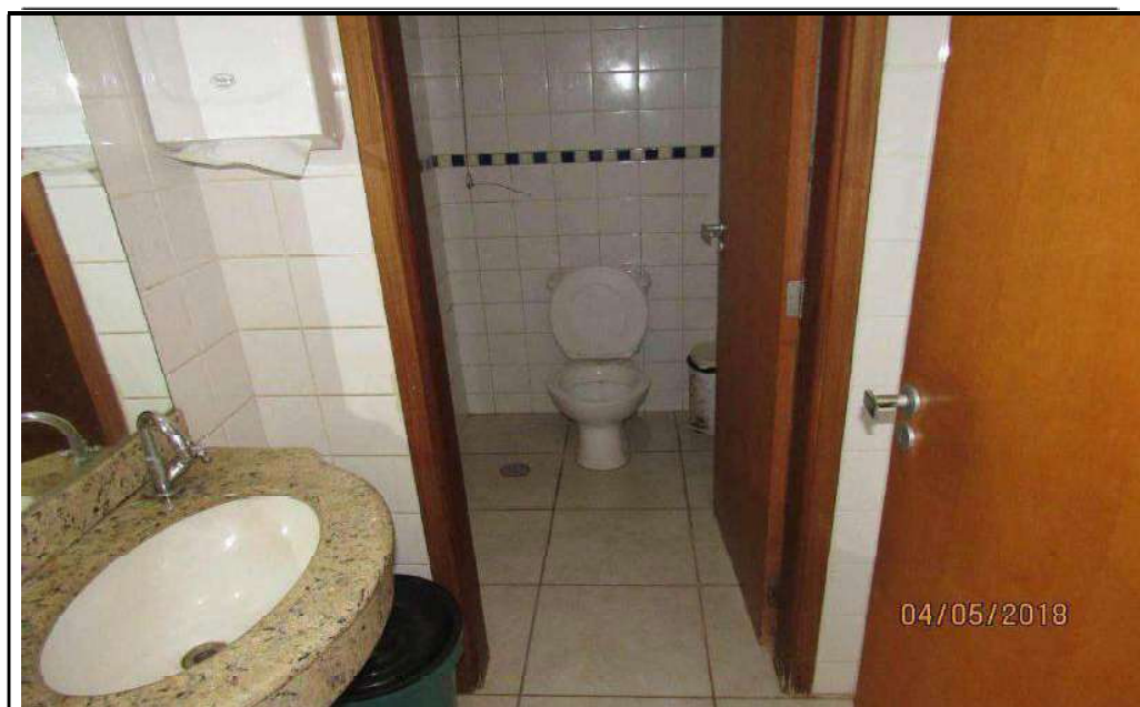
FOTO 34 – Vista geral de um dos banheiros na edificação.
