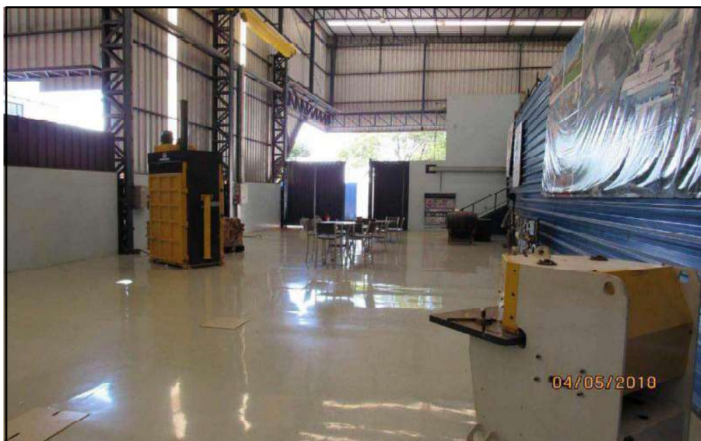
FOTO 16 – Vista geral de parte do barracão.
