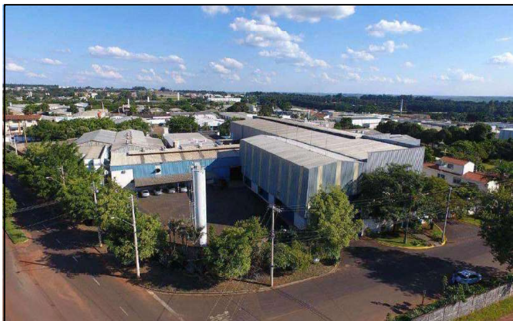
FOTO 02 – vista geral externa do barracão.
