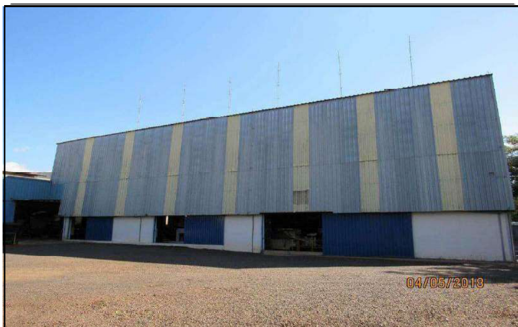
FOTO 23 – Vista geral lateral externa do barracão de serviços.
