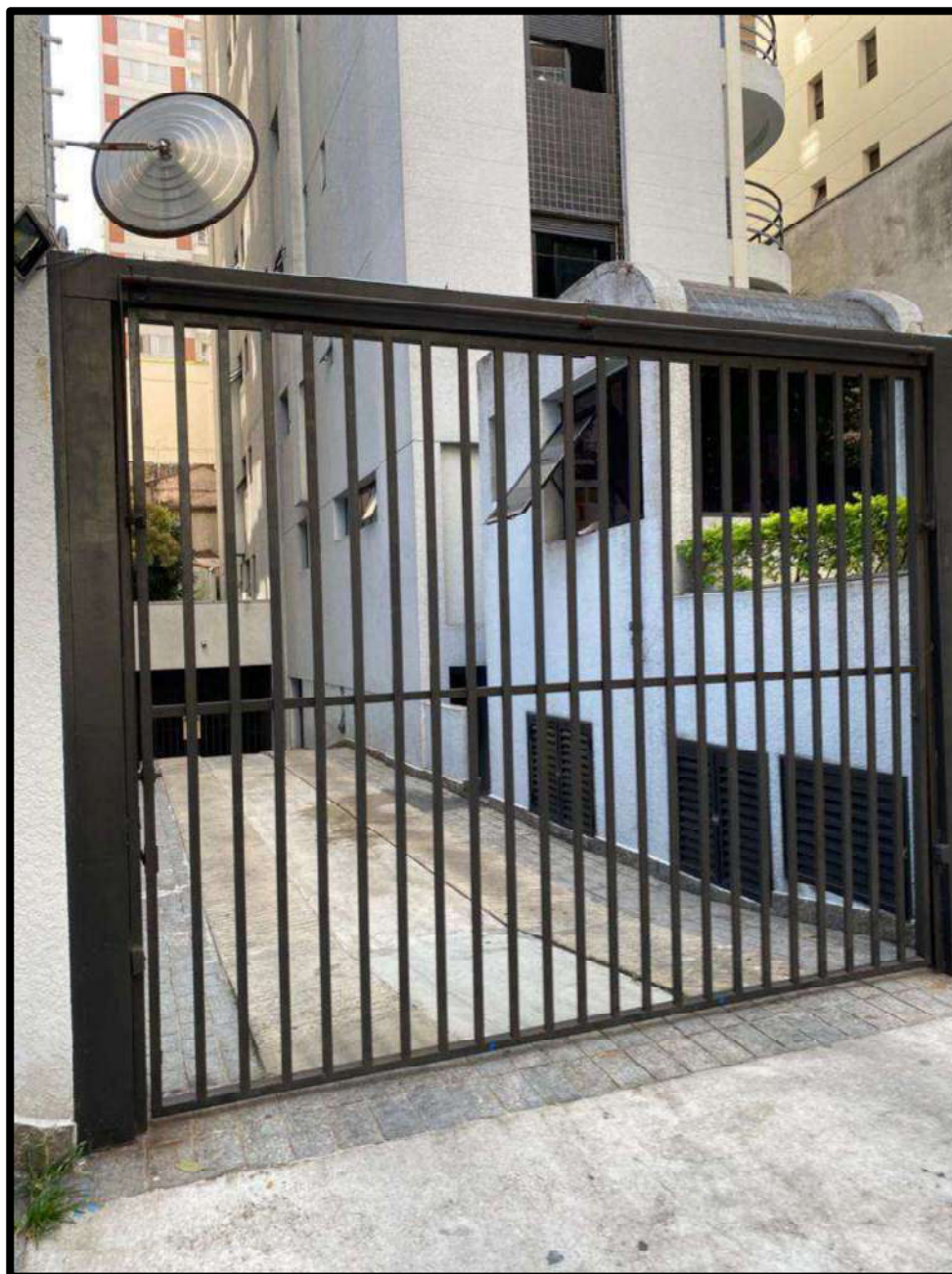
Foto nº 05 – Ilustra portão de entrada/saída de veículos.
