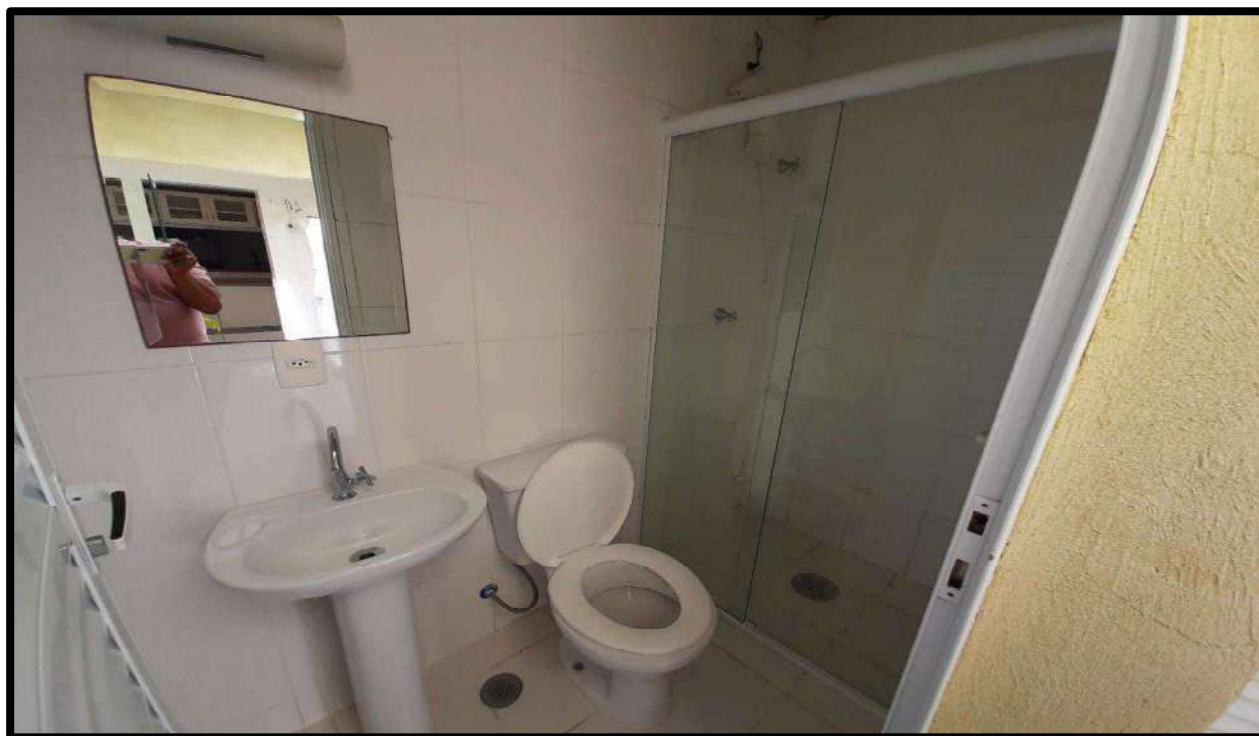
Foto nº 16 – Vista para o banheiro de serviço.
