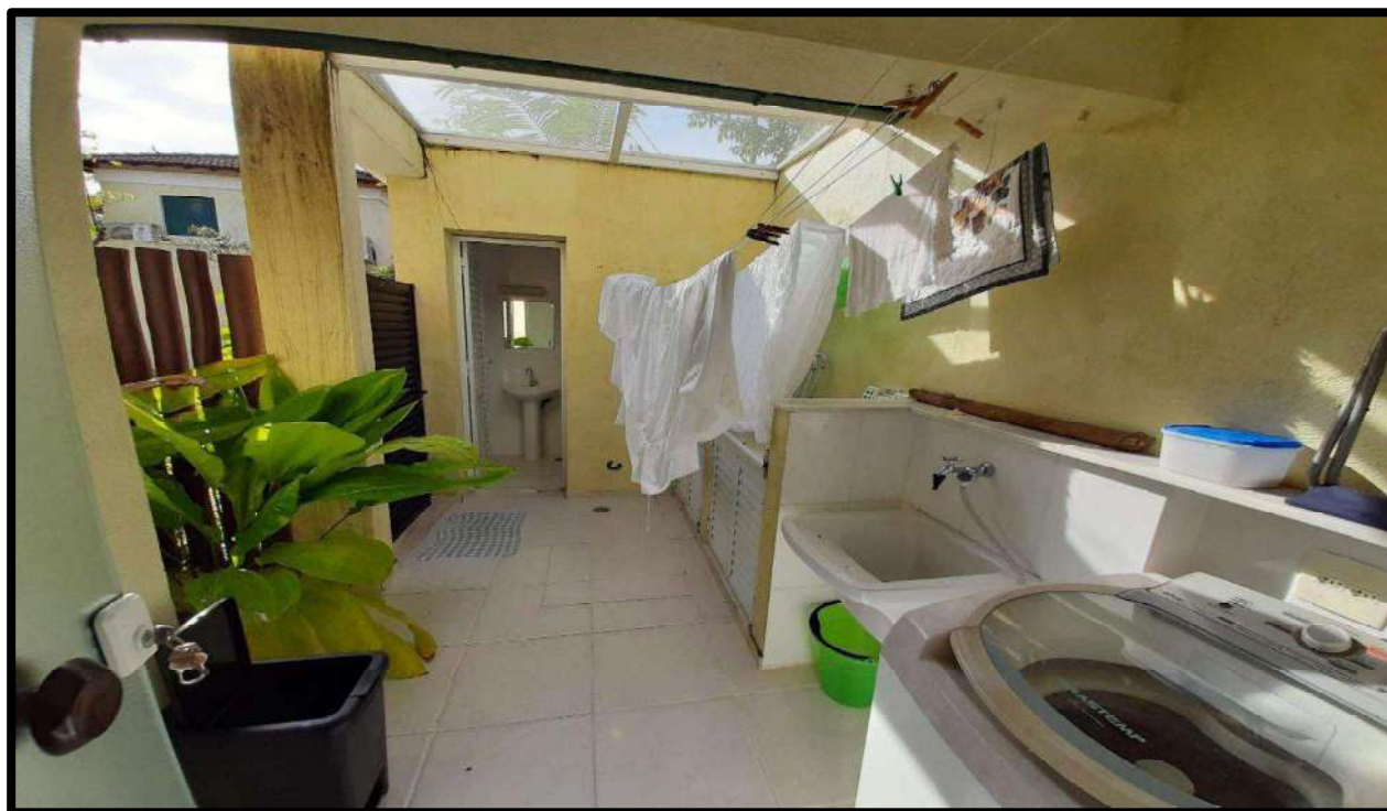
Foto nº 15 – Vista geral para a área de serviço coberta e descoberta.
