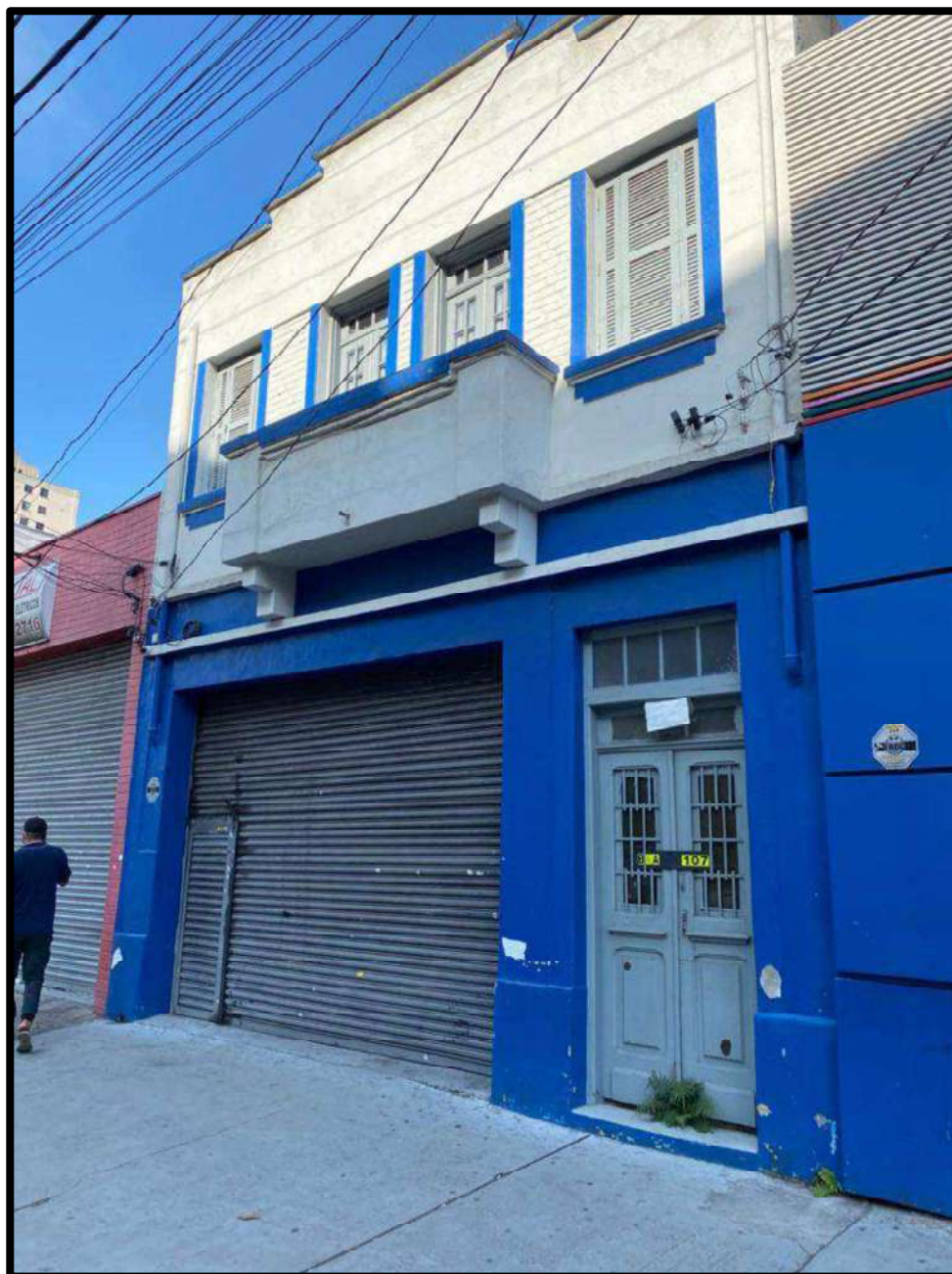
Foto nº 01 – Vista aproximada do imóvel nº 166.
