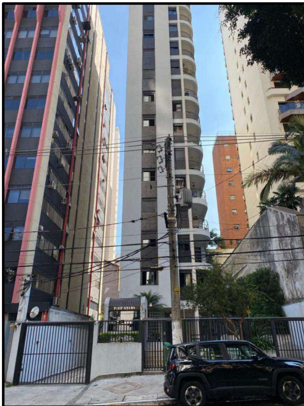
Foto nº 03 – Vista frontal do edifício.
