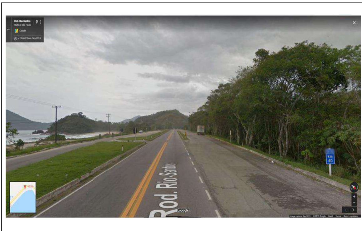
FOTO 01 – Vista geral do imóvel
