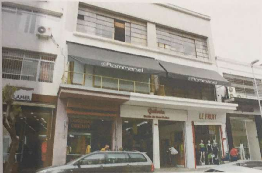
FOTO 1: Vista da fachada da Galeria Barão do Bom Retiro.
