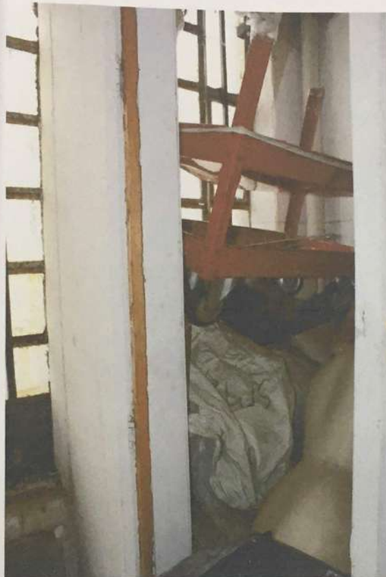
FOTO 5: Vista parcial do banheiro do imóvel avaliando.
