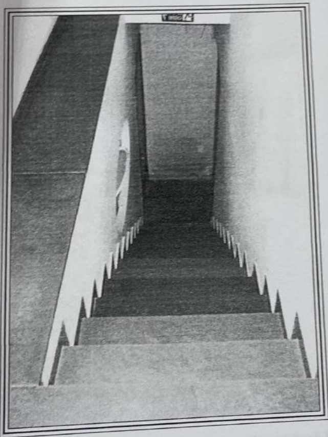
FOTO 46: Detalhe da escada de acesso ao pavimento inferior, no qual existe uma residência adaptada para zeladoria.
