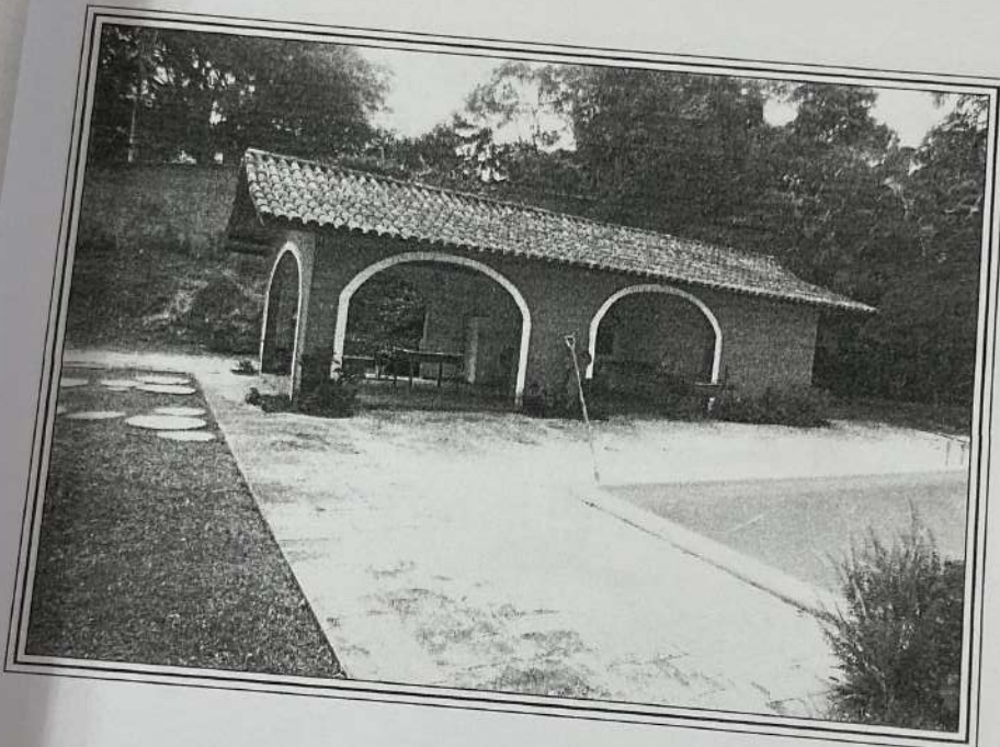
FOTO 57: Vista da edificação em que está a área de churrasqueira e a sauna existentes no imóvel avaliando.
