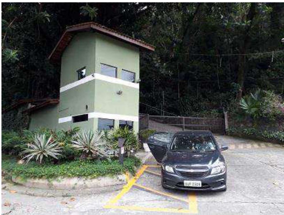
Portaria de acesso ao interior do loteamento Três Marias, com destaque para a portaria, identificada pelo nº. 1001 da Av. Gerson Maturani.
