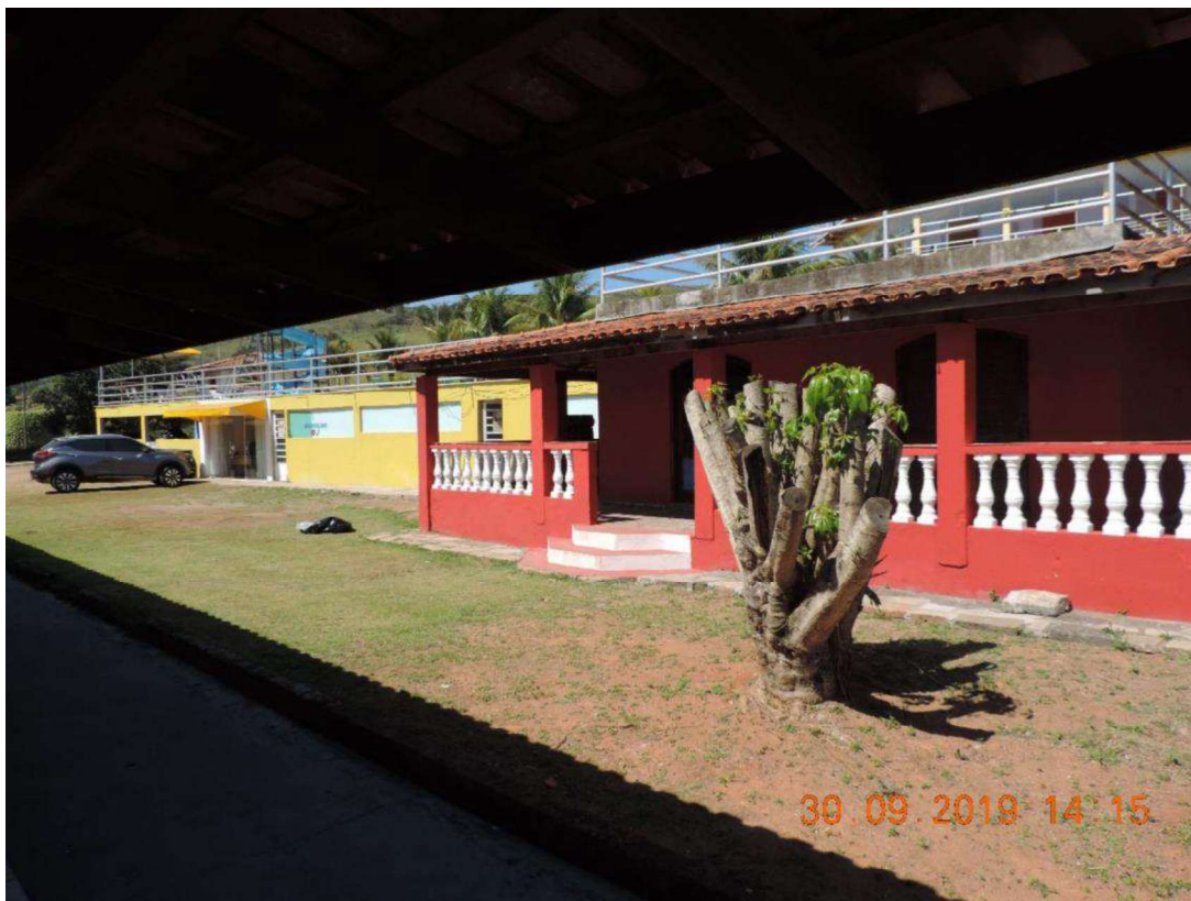
FOTO N° 37 – VISTA INTERNA DA PROPRIEDADE
