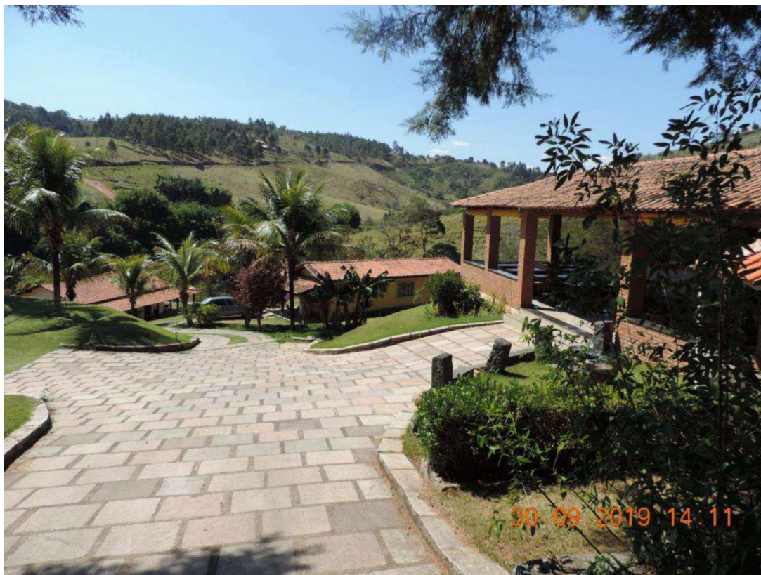
FOTO N° 29 – VISTA INTERNA DA PROPRIEDADE
