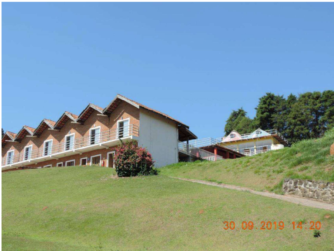
FOTO N° 46 – VISTA INTERNA DA PROPRIEDADE
