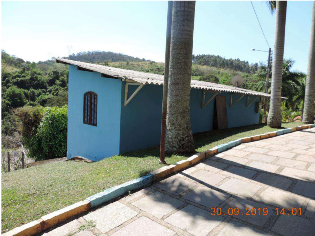
FOTO N° 13 – VISTA INTERNA DA PROPRIEDADE
