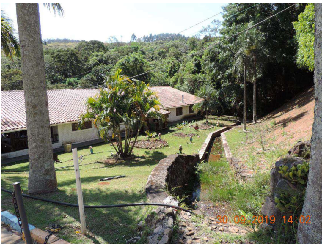
FOTO N° 16 – VISTA INTERNA DA PROPRIEDADE
