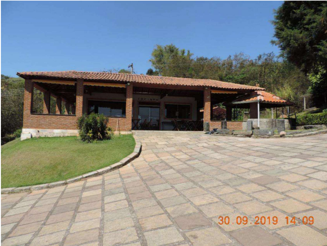
FOTO N° 27 – VISTA INTERNA DA PROPRIEDADE
