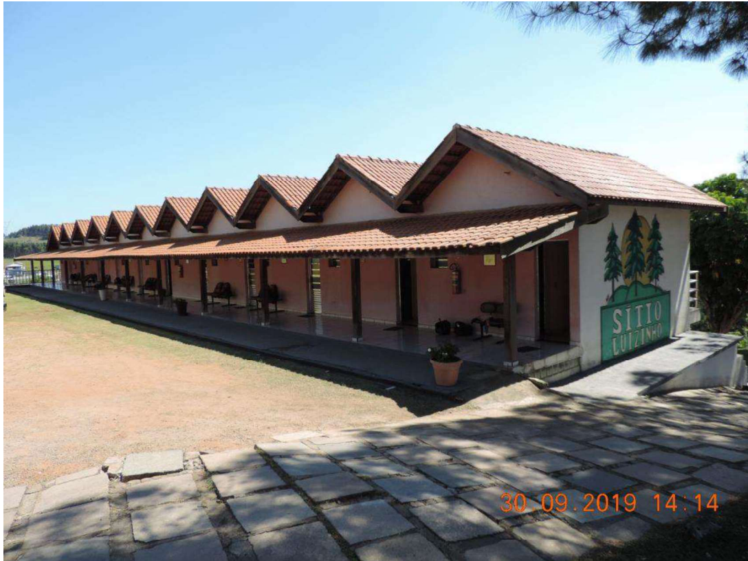
FOTO N° 33 – VISTA INTERNA DA PROPRIEDADE
