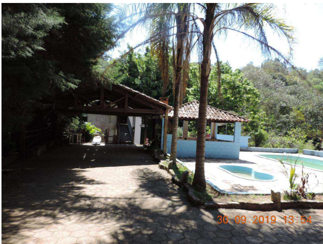
FOTO N° 06 – VISTA INTERNA DA PROPRIEDADE
