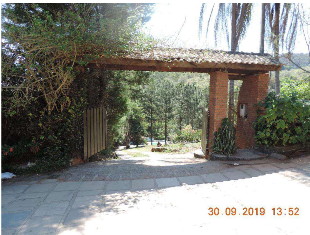
FOTO N° 04 – VISTA INTERNA DA PROPRIEDADE
