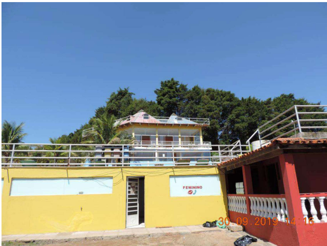
FOTO N° 40 – VISTA INTERNA DA PROPRIEDADE
