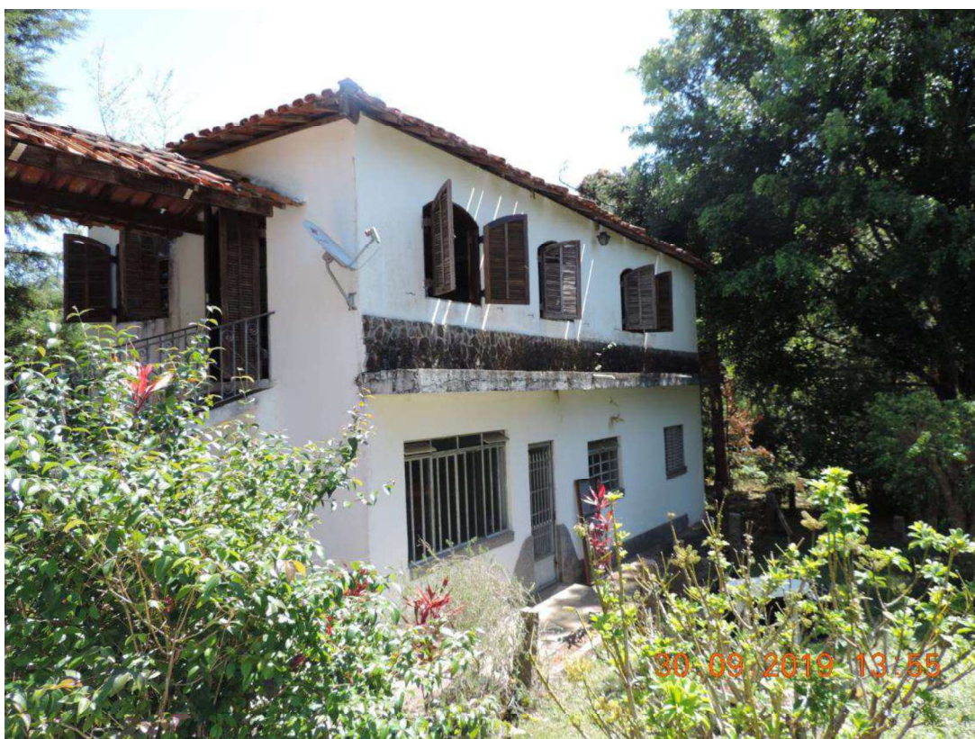
FOTO N° 08 – VISTA INTERNA DA PROPRIEDADE
