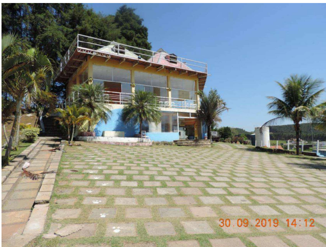
FOTO N° 30 – VISTA INTERNA DA PROPRIEDADE
