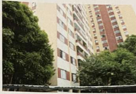
Figure 7 - Vista lateral da fachada do apartamento nº 24 do Bloco A.
