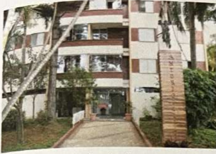
Figure 6 - Fachada da entrada do edifício Solar dos Antúrios.
