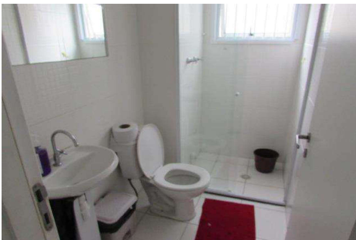
Foto 06 – Vista do banheiro. Suas principais características construtivas são: piso cerâmico, paredes azulejadas até o teto, forro em laje e esquadrias de alumínio.
