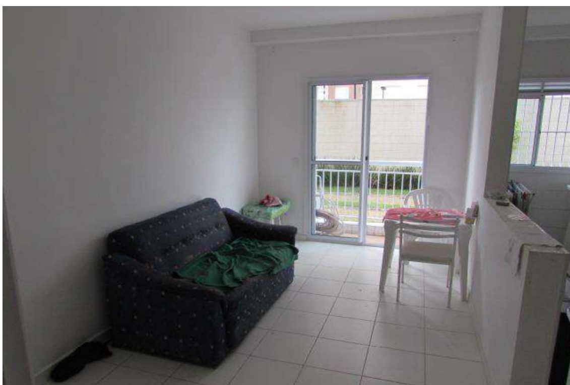
Foto 03 – Vista da sala da unidade 03. Suas principais características construtivas são: piso cerâmico, paredes revestidas em massa corrida, forro em laje e esquadrias de alumínio.
