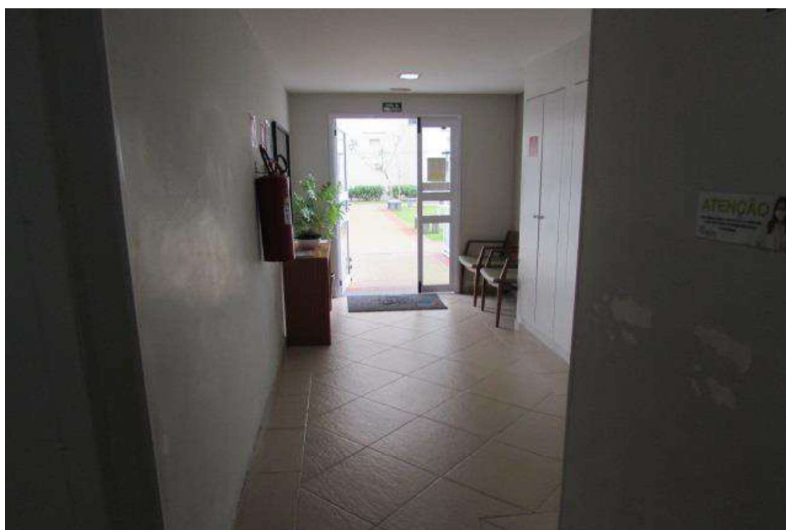
Foto 02 – Vista do hall de acesso à Torre 02 do Condomínio Residencial Oceanic Praia Grande onde se situa a unidade avalianda nº 148.
