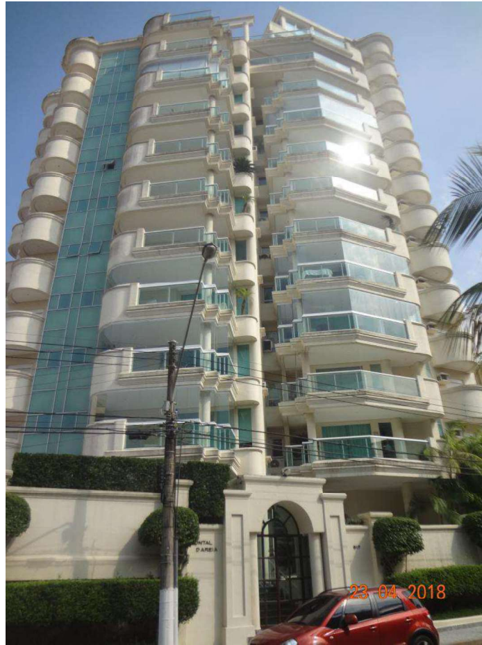
FOTO 05: Outra vista parcial da fachada frontal do Edifício Pontal D'Areia, localizado à Av. Atlântica nº 517.
