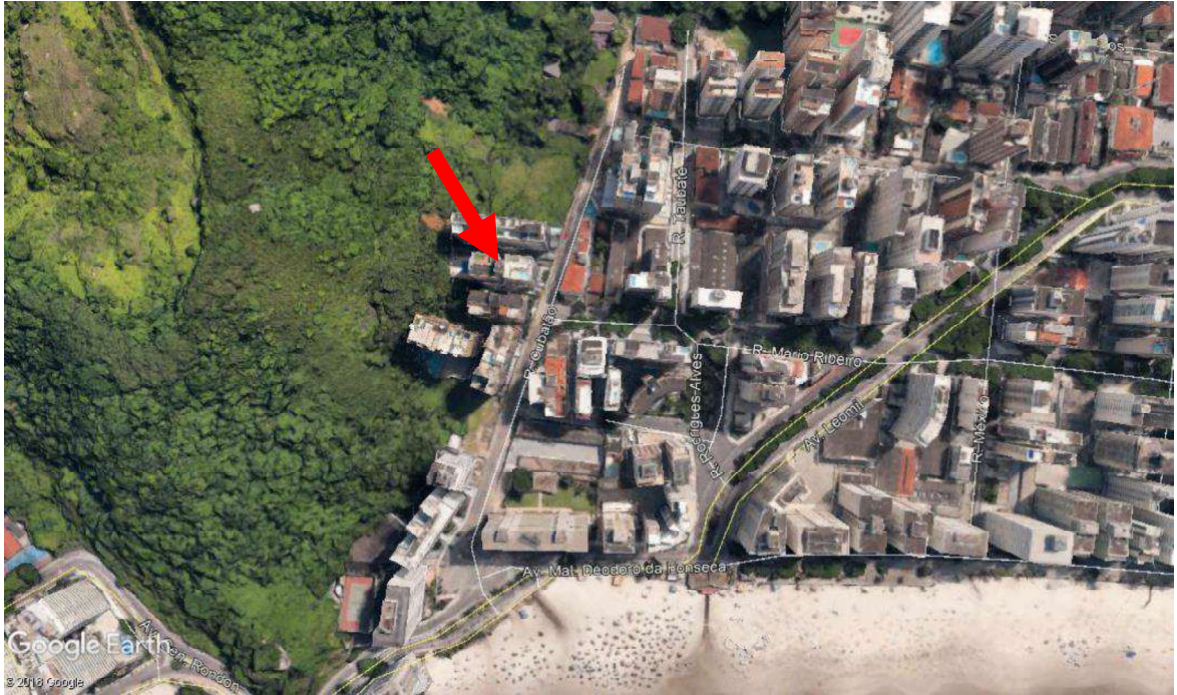
FOTO 30 (Google Earth): Detalhe da localização do Edifício Atlantic City, localizado à Rua Cubatão nº 155 – Praia das Pitangueiras, município de Guarujá-SP.
