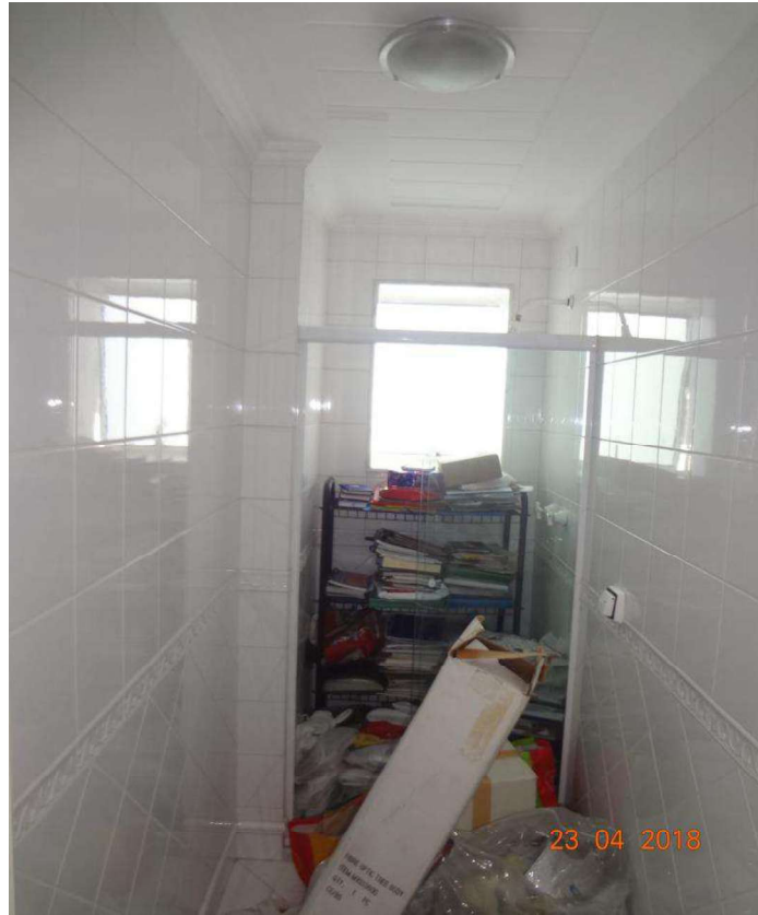
FOTO 19: Vista parcial do banheiro da suíte 1.
