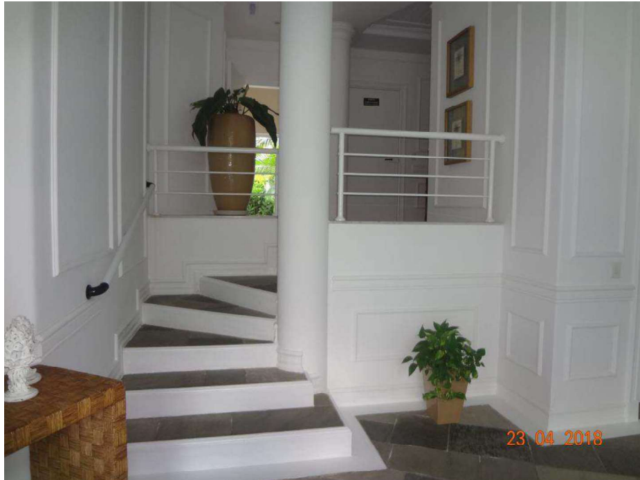
FOTO 09: Detalhe da escada de acesso ao hall de serviço no pavimento térreo do edifício.
