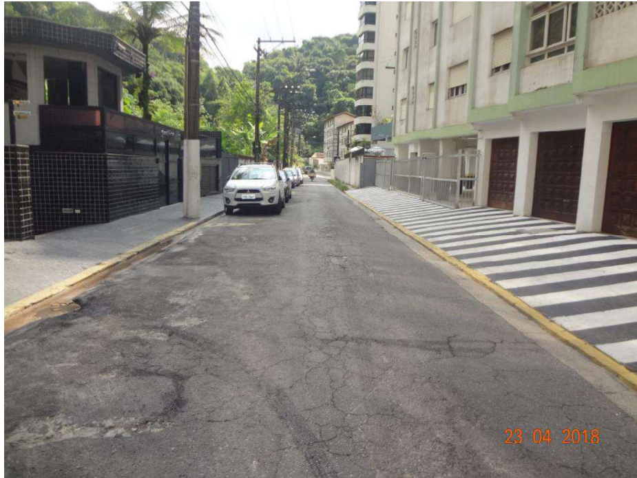
FOTO 32: Vista de trecho da Rua Cubatão; o observador encontra-se posicionado em frente ao Edifício Atlantic City olhando em direção ao lado contrário à praia.
