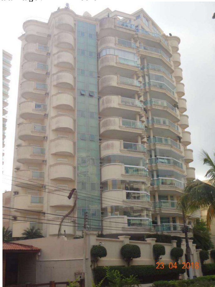
FOTO 04: Vista da fachada do Edifício "Pontal D'Areia.
