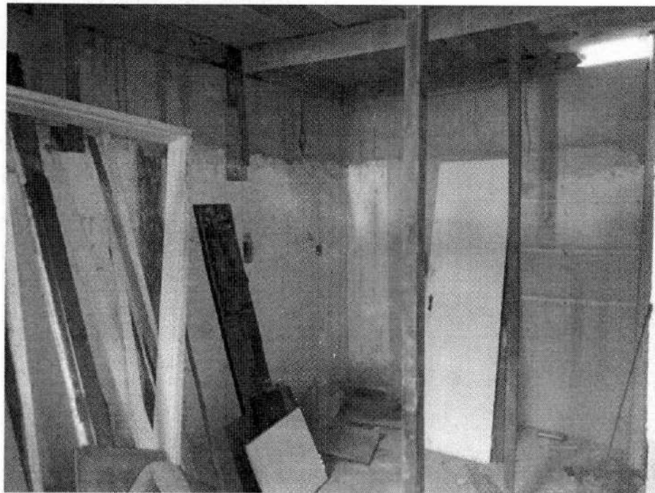
Foto 11 – obras no 3º pavimento
