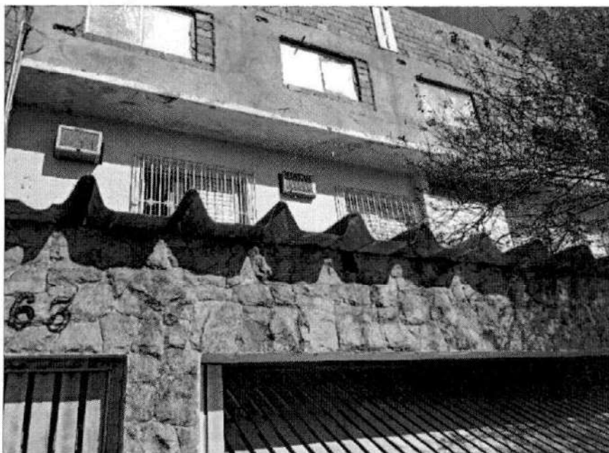
Foto 2 – vista externa do 3º pavimento
