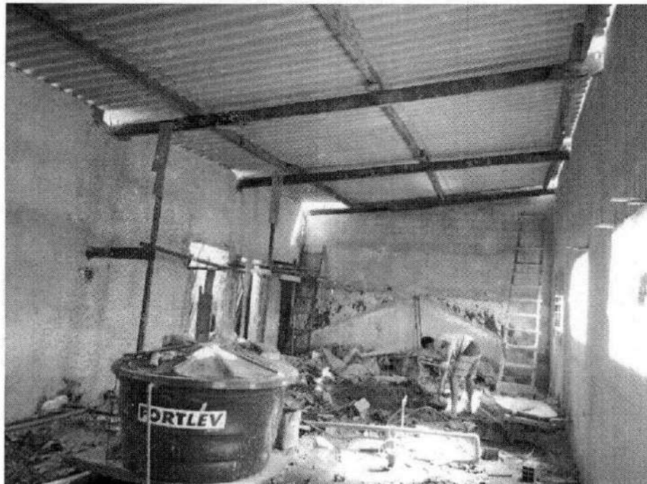
Foto 13- vista interna do 3º pavimento em construção
