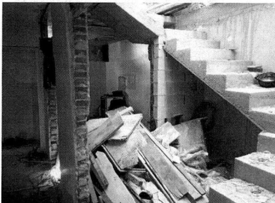
Foto 8 – sala e escada para o segundo pavimento
