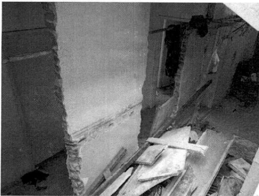
Foto 17 – paredes derrubadas na obra
