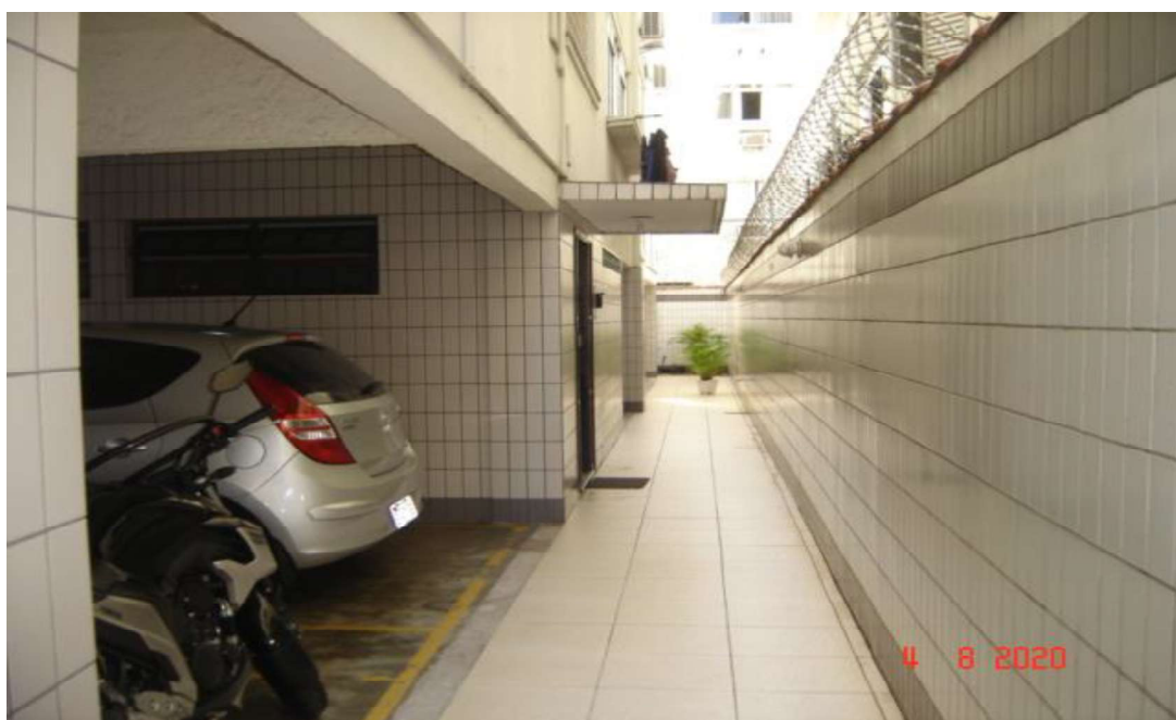
2 – Acesso à Portaria 2
