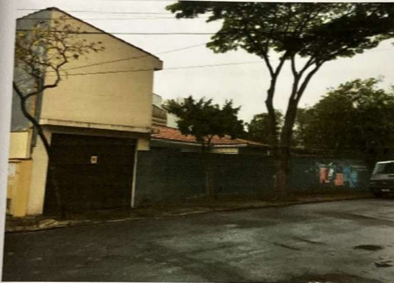
Aspectos da fachada do imóvel avaliando, vista da Rua Dom José Maurício.
