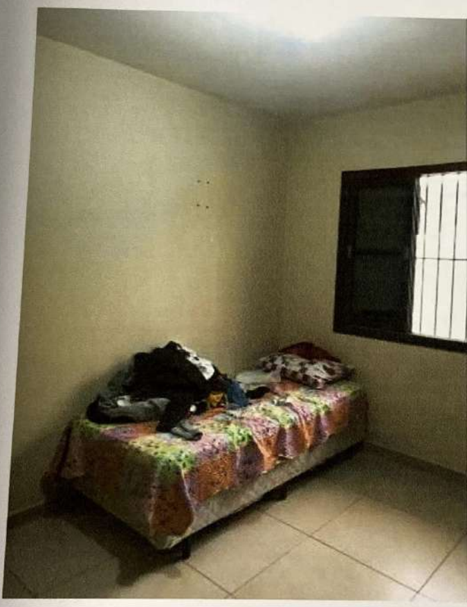
Detalhes de acabamento e conservação do dormitório 2.
