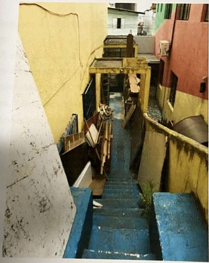
Vista do corredor lateral.
