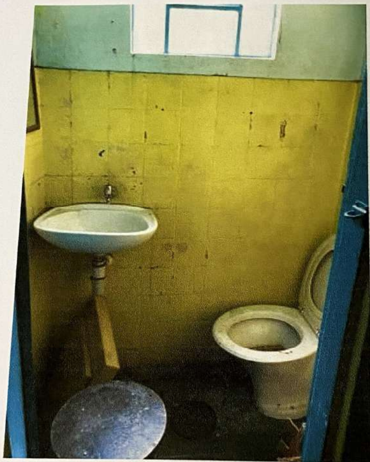
Detalhes de acabamento e conservação do banheiro.
