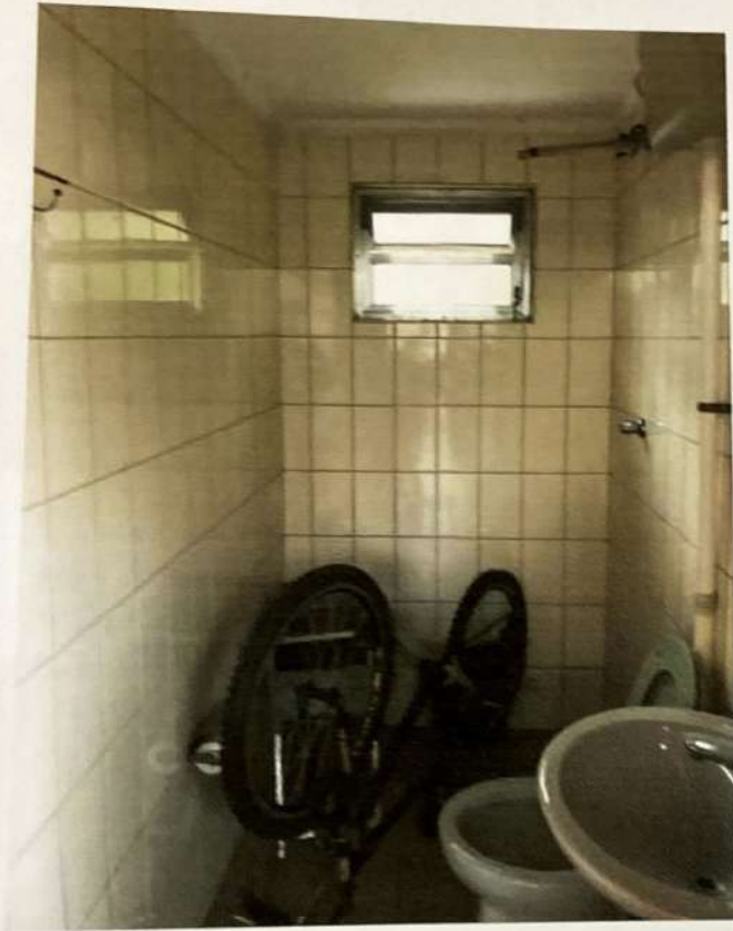
Detalhes de acabamento e conservação do banheiro de empregada.
