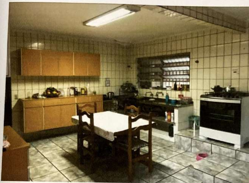
Detalhes de acabamento e conservação da cozinha.
