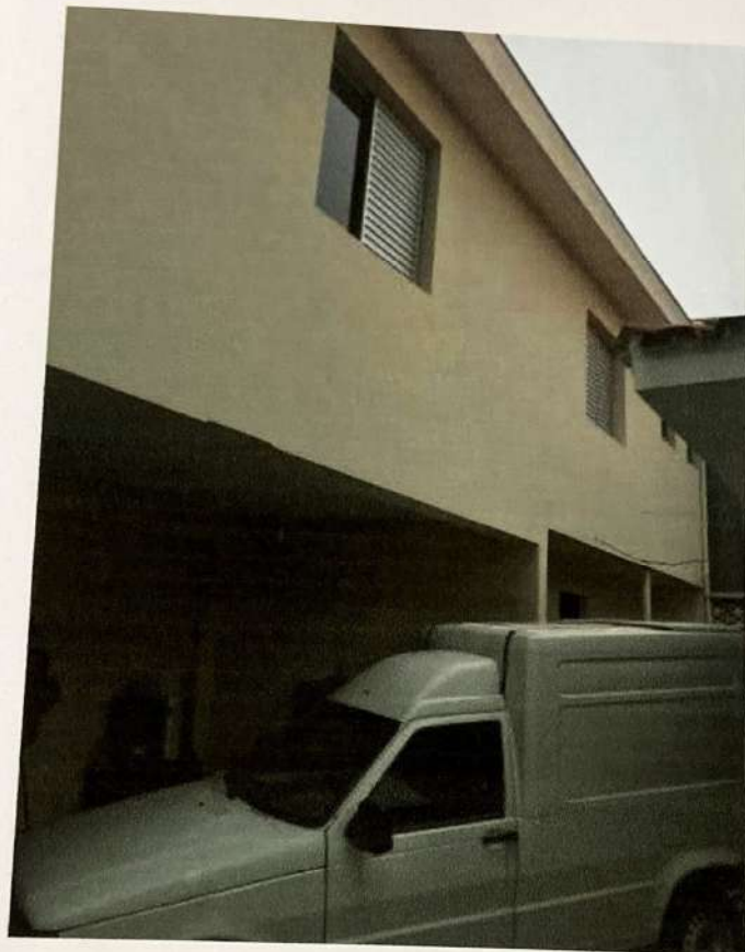
Aspectos parciais da fachada da edícula, vista do interior do terreno.
