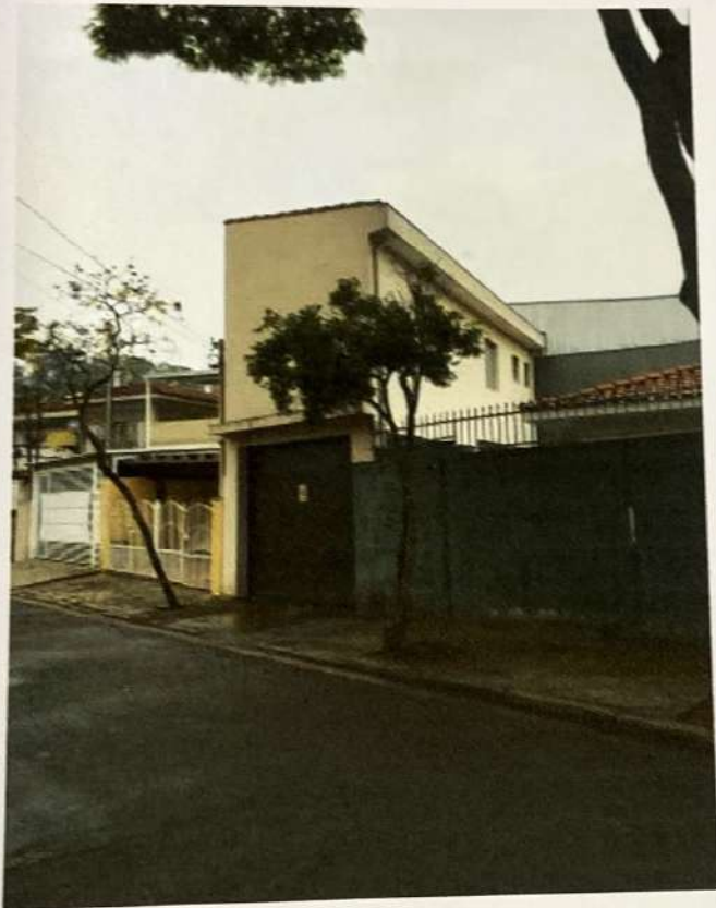
Aspectos parciais da fachada da edícula, vista da Rua Dom José Maurício.
