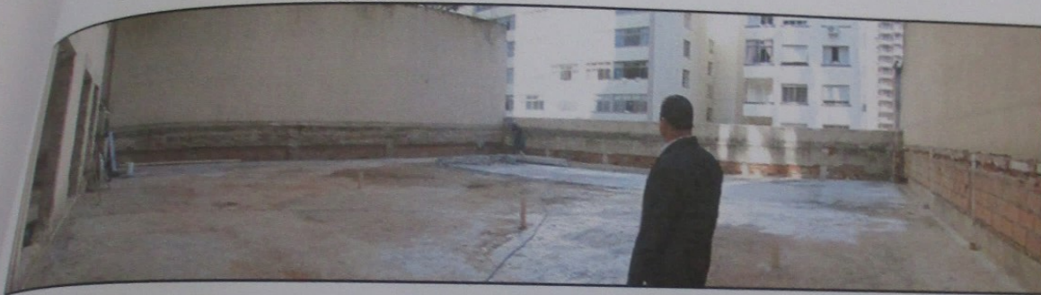
Reprodução fotográfica da área comum ao fundo do condomínio e que se encontra em obras.
