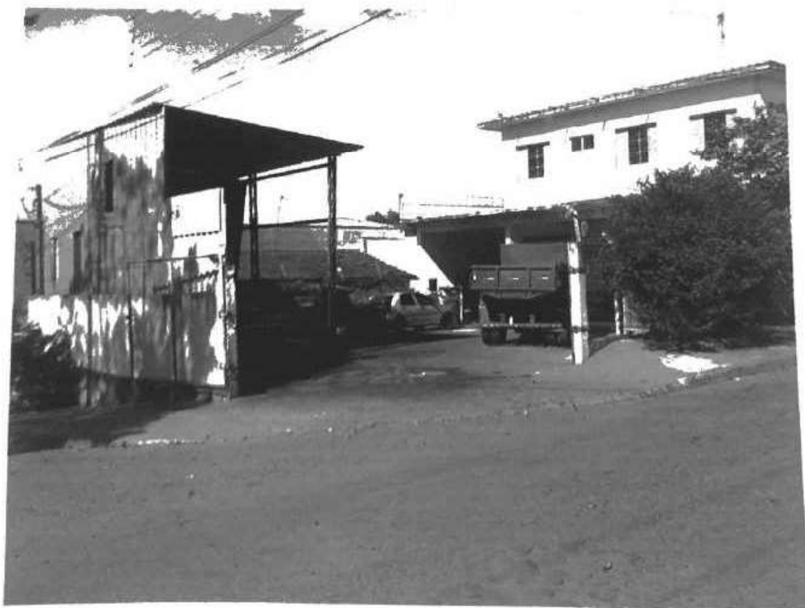
▷ ILUSTRAÇÃO Nº 04 - Imóvel examinado: Vista a partir do logradouro.
