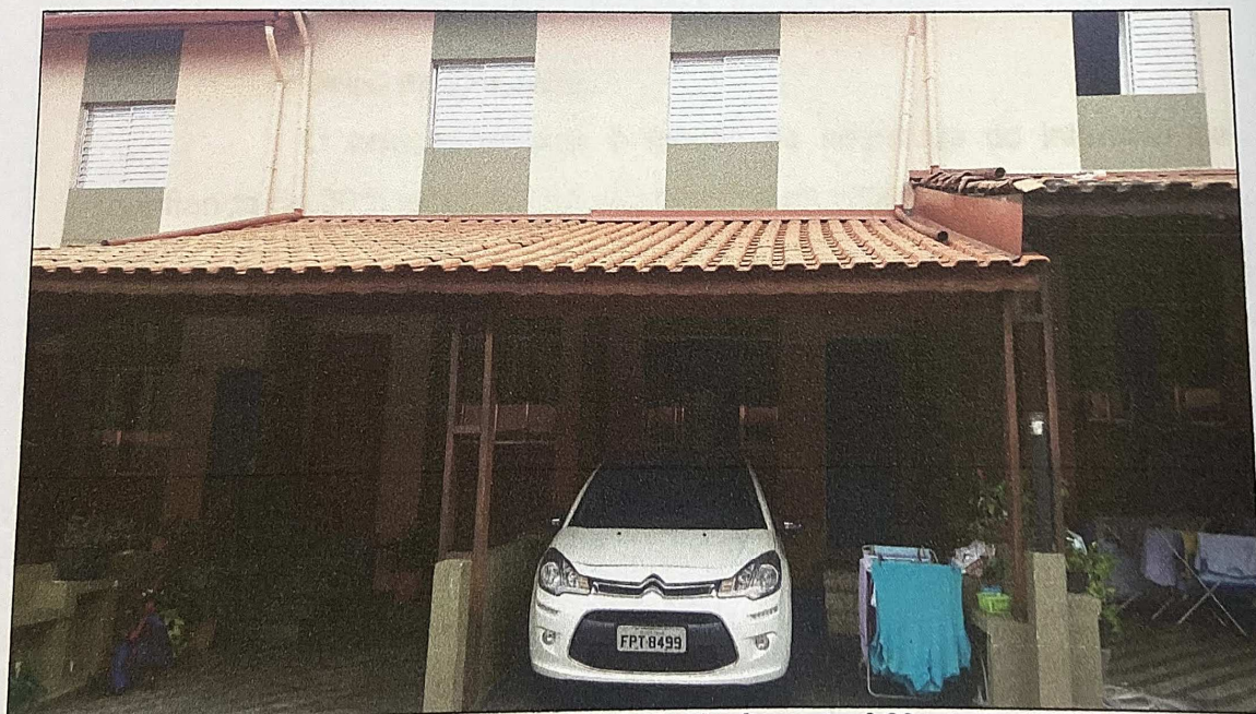
Figura 5 – Vista da fachada da casa nº 20
