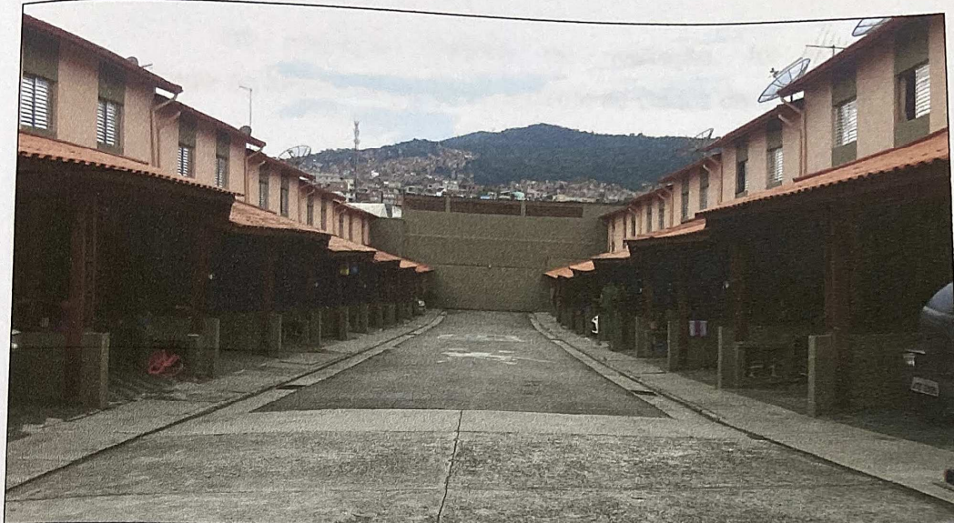
Figura 4 – Vista interna do Conjunto Residencial Taipas
