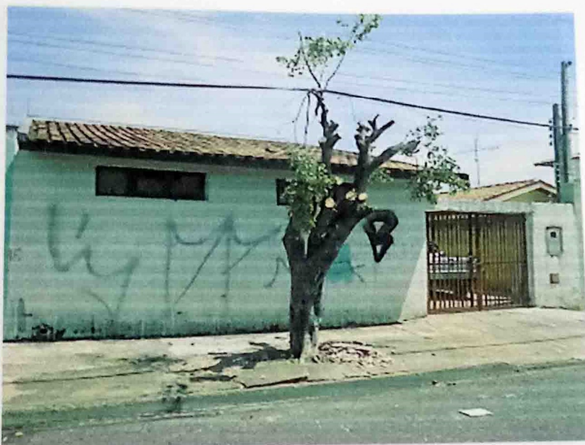
Fotos 3 – Vista de fachada frontal do imóvel.
