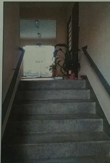
VISTA PARCIAL DAS ESCADAS INTERNAS DO EDIFÍCIO DO IMÓVEL AVALIANDO
