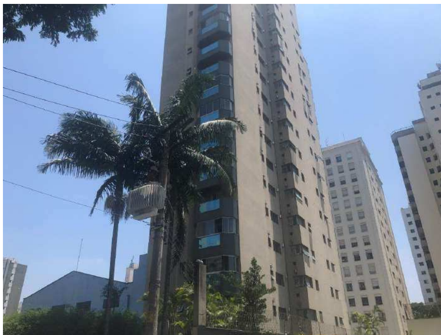
Foto 1. Vista parcial do edifício.
