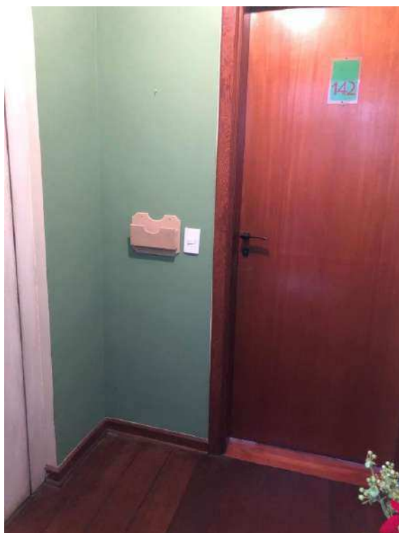
Foto 15. Vista parcial do hall do elevador social no 14º andar.
