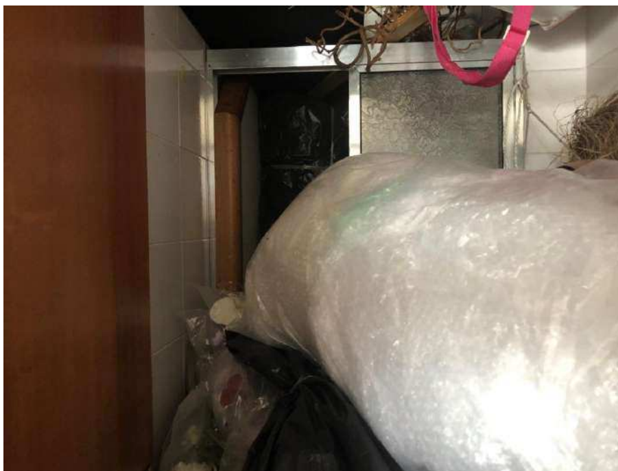
Foto 22. Vista parcial do banheiro de empregada.
