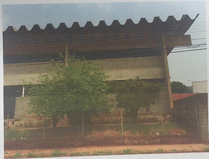
Foto 02 – Parte da frente do Galpão – Área "B"
