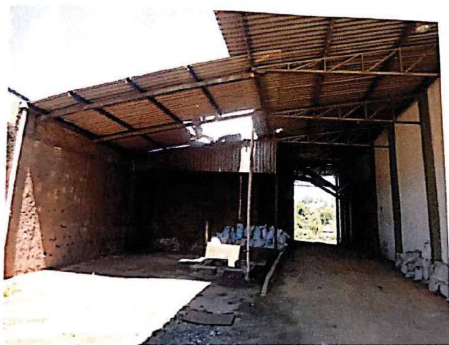
Fotos N. 16, 17, 18 e 19 – Áreas Cobertas de Carga e Descarga – Data aprox. da Construção-1988. Cobertura em Estrutura Metálica com Telhas de Alumínio – AT = 736,45m 2 .
