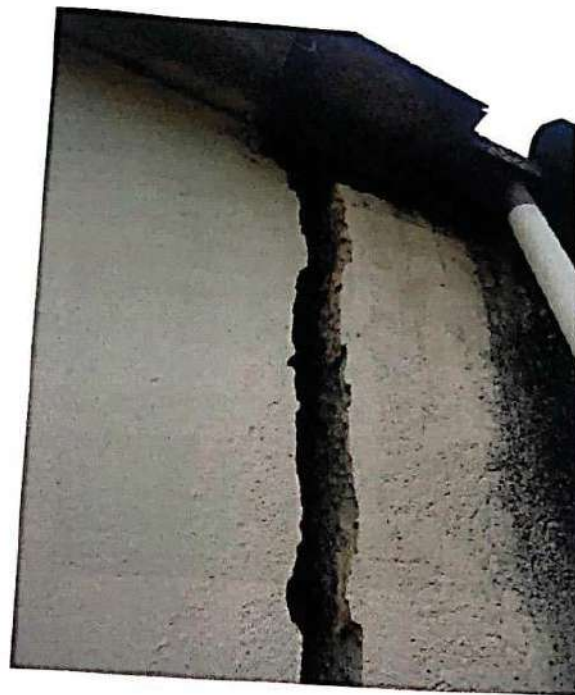
Foto N. 67 – Grande rachadura entre as paredes do vestiário e dormitório isolado do Refeitório/Vestiários.
