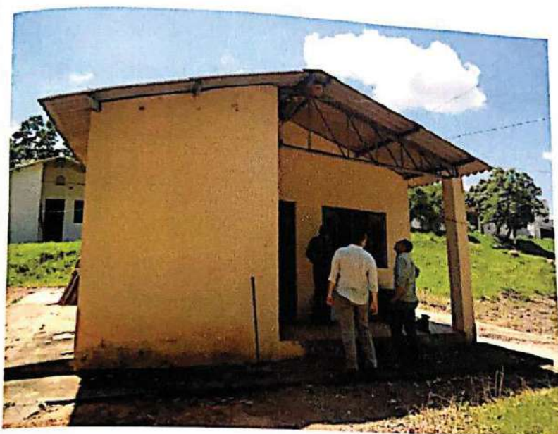
Edifícios N. 58 e 59 – 04ª Residência – Data aprox.. da Construção-1988. Alvenaria em Blocos de Concreto, Laje, Cobertura em Estrutura de Madeira com Telhas de Fibrocimento e Piso em Cimento Queimado – AT = 50,00m 2 .
