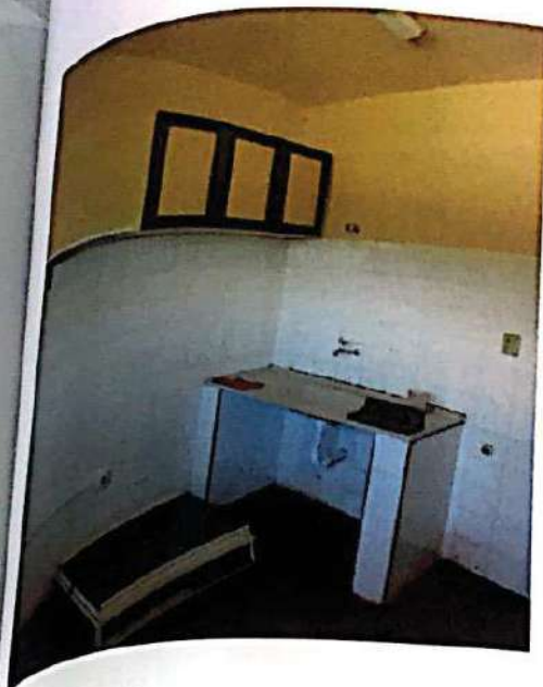
Fotos N.41 e 42 – Refeitório/Vestiários – Refeitório/Copa – Piso em Lajota, Azulejos até 2,00m e Laje.
