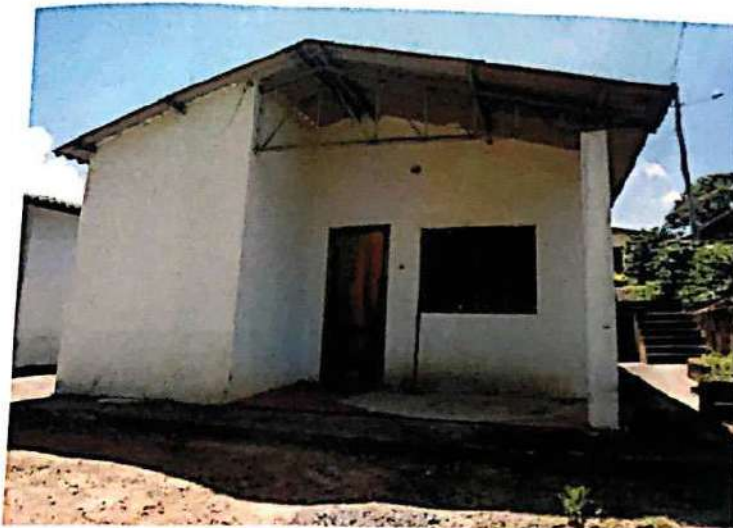
Foto N. 52 – 03ª Residência – Data aprox.. da Construção-1988. Alvenaria em Blocos de Concreto, Laje, Cobertura em Estrutura de Madeira com Telhas de Fibrocimento e Piso em Cimento Queimado – AT = 52,00m 2 .
