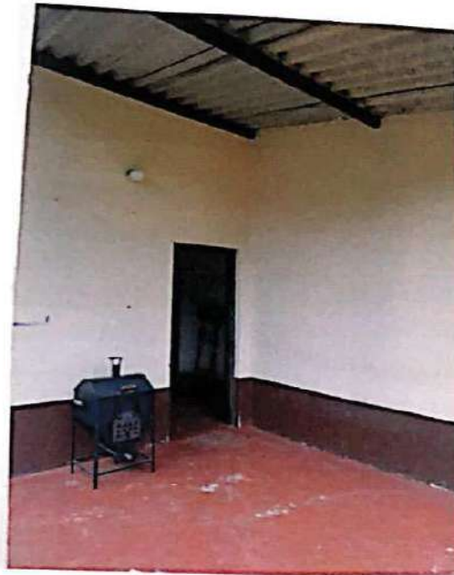
Foto N. 44 – 01ª Residência – Área Externo. Cobertura em Estrutura de Madeira com Telhas de Fibrocimento e Piso em Cimento Queimado.
