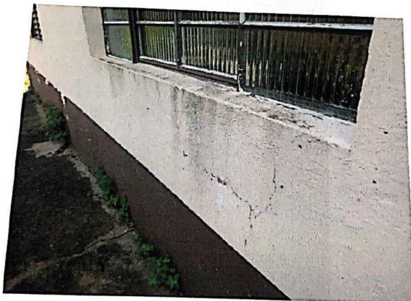
Foto N. 67 – Grande rachadura entre as paredes do vestiário e dormitório isolado do Refeitório/Vestiários.
