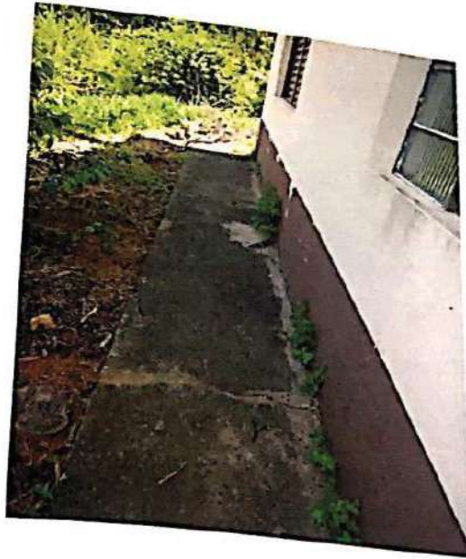
Foto N. 69 – Vegetação entre o piso das calçadas externas e as residências. Sinal de infiltração e umidade.
