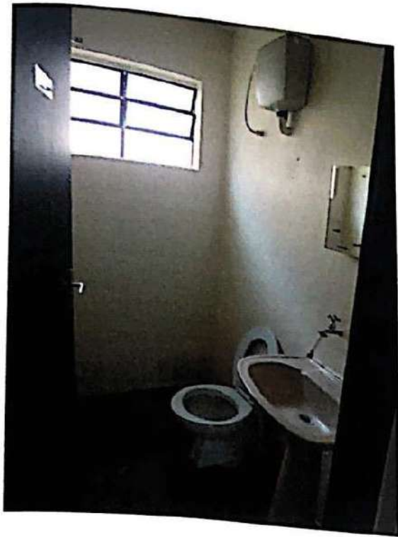
Sob. N. 47 – 01ª Residência – WC Interno. Sem Azulejos, Com Laje e Piso Cerâmico.
