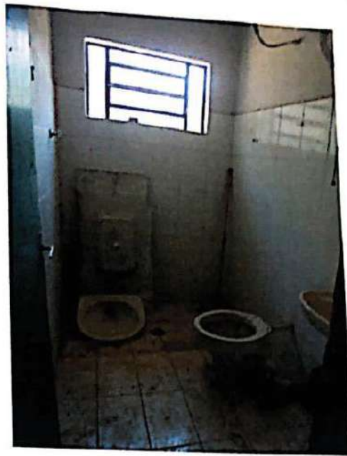
Foto N. 62 – 04ª Residência – WC Interno. Laje, Azulejos até 2,00m e Piso Cerâmico.
