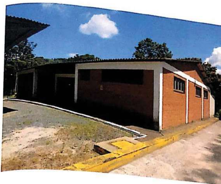
Foto 23 – Escritório/Administração – Data aprox. da Construção-1988. Alvenaria em Tijolos de Barro, Laje, Cobertura em Estrutura Metálica com Telhas de Fibrocimento – AT = 286,32m 2 .
