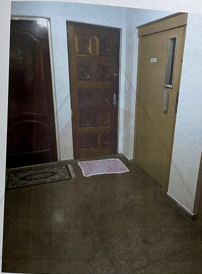
FOTO 9: HALL DO ANDAR.
