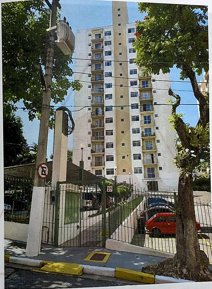
FOTO 5: FACHADA DO EDIFÍCIO.
