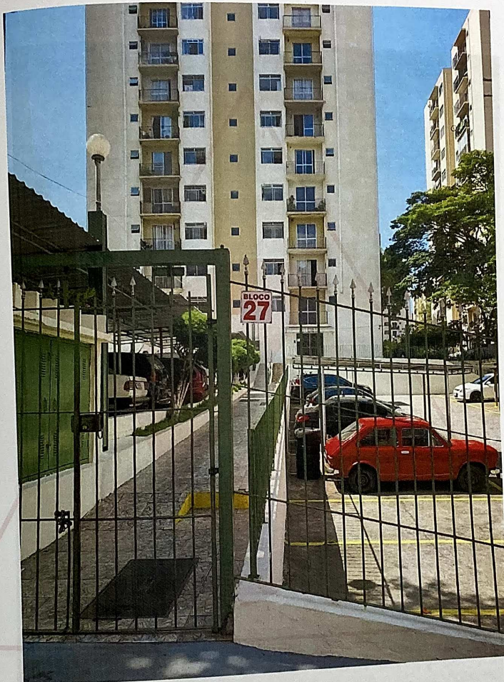
FOTO 3: ENTRADA DO EDIFÍCIO.
