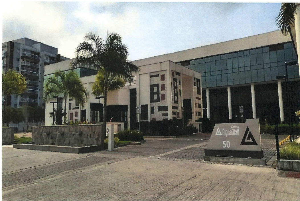
Fachada do prédio
