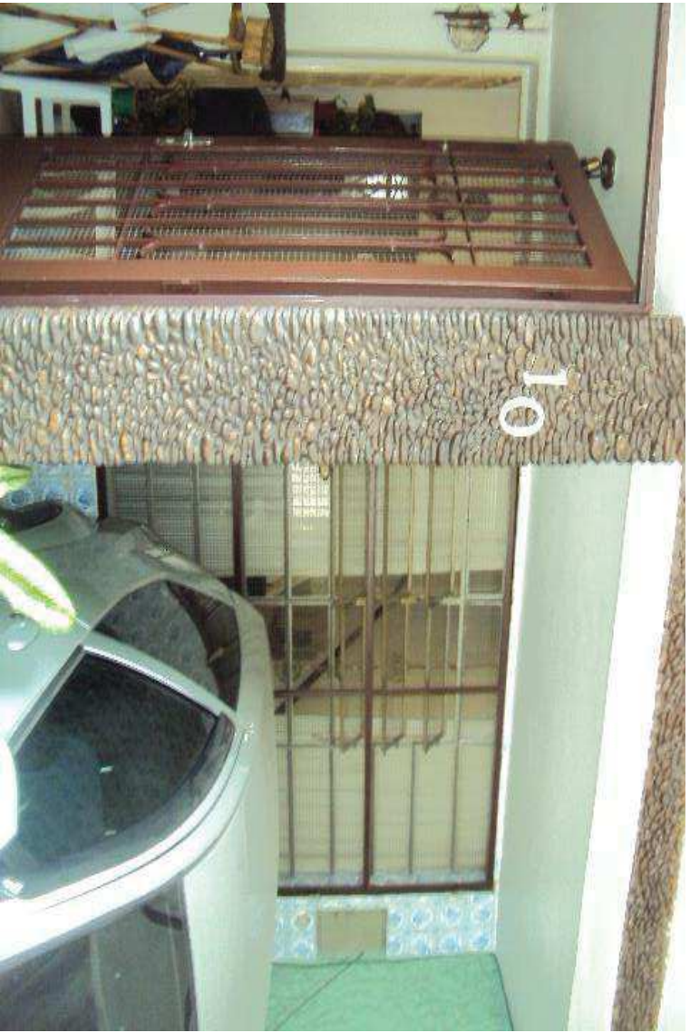
FOTO nº 05 Vista da garagem.
