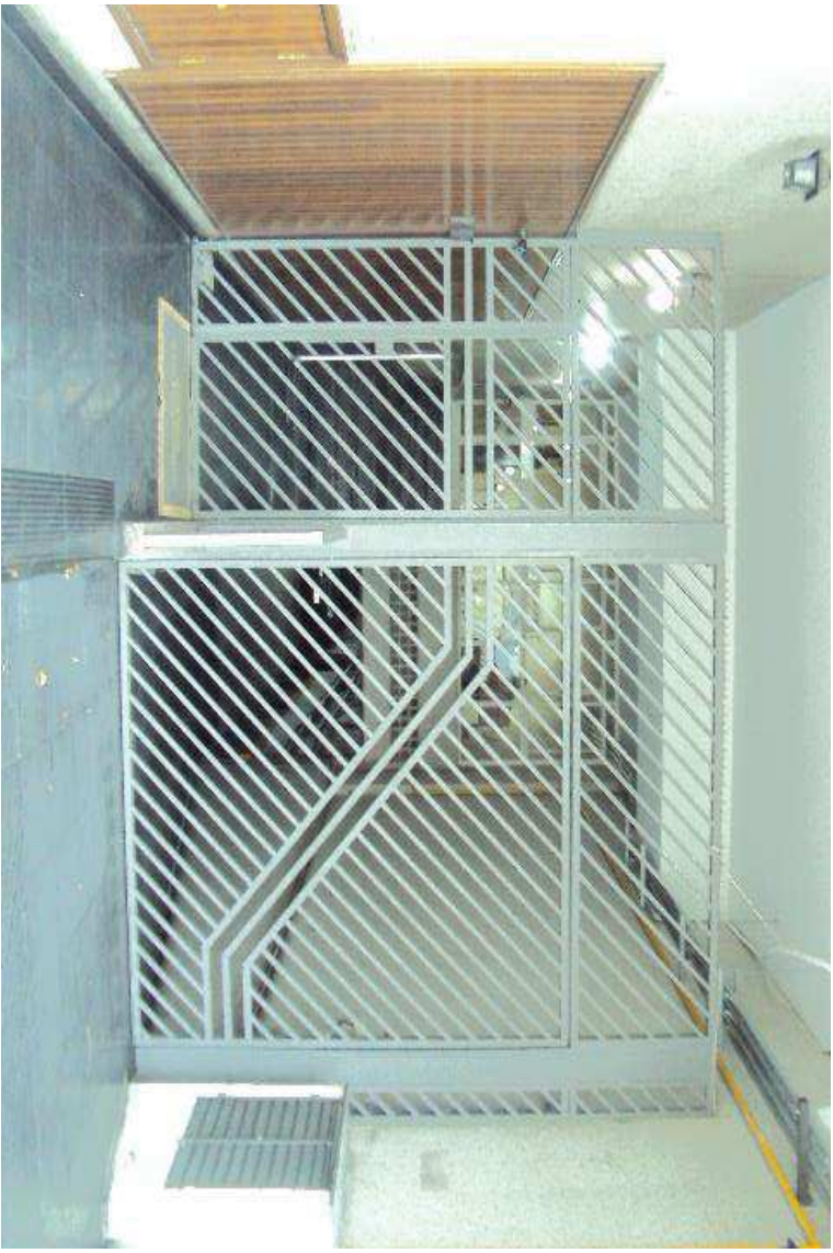
FOTO nº 16 Vista do acesso ao edifício.
