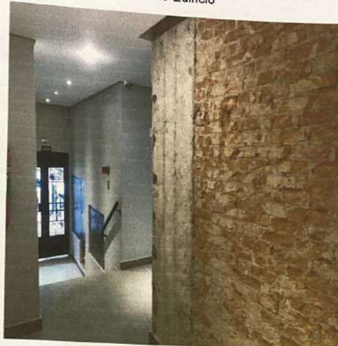
Vista interna da entrada do Edifício
