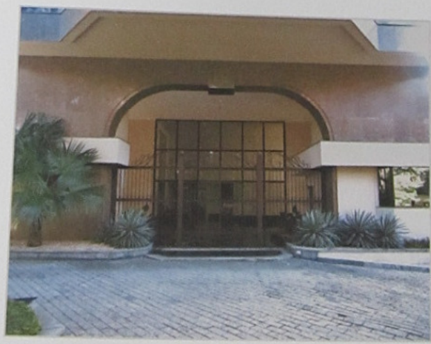
Entrada do Edifício
