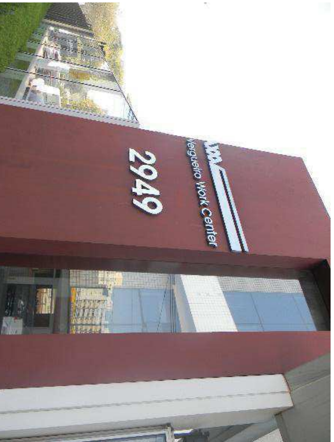
Foto nº 05- Entrada do edifício.
