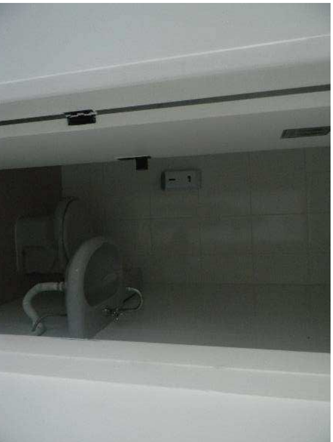
Foto nº 11 – Vista do WC do conjunto avaliando.
