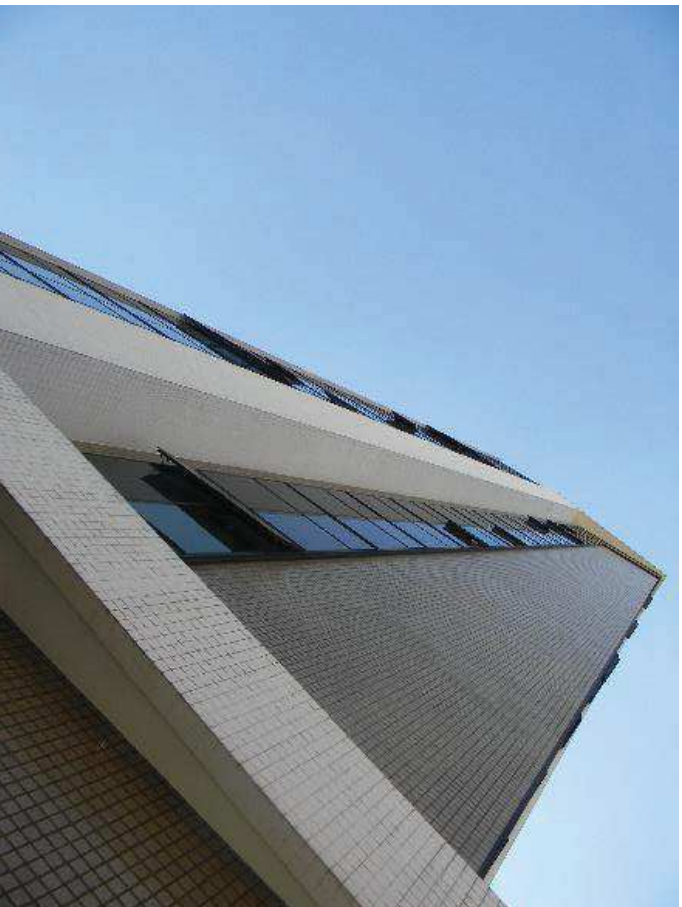
Foto nº 04 – Fachada do edifício com revestimento cerâmico.
