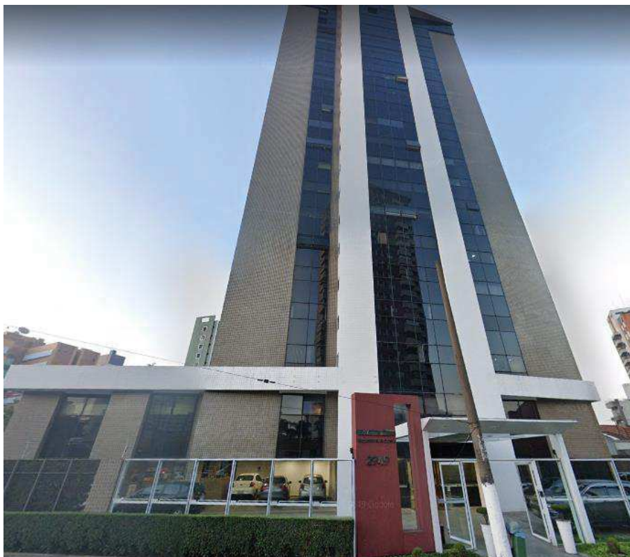
Foto nº 01 – Fachada Frontal do imóvel.
