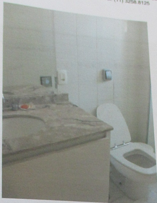
Foto 11 – Vista do banheiro
