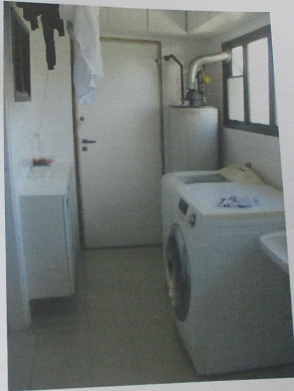
Foto 06 – Vista da área de serviços
