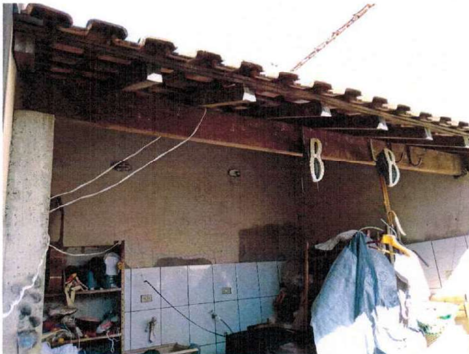
Área de Serviço (aos fundos).
