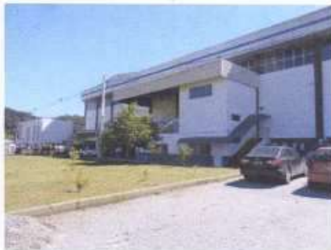
Vista geral do imóvel voltada para a Rua Valdemar Oliveira da Silva (antiga Rua "F").
