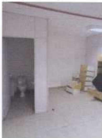
Bloco 2 – Industrial – Mezanino 1 – Setor de Armazenamento: sala e sanitário.
