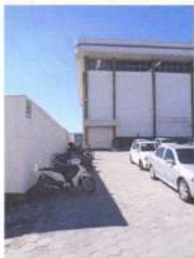
Aspectos gerais do imóvel do alinhamento de fundos.
