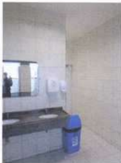
Bloco 1 – Administrativo – Térreo Ala 3 detalhe típico de conjunto de sanitário do setor operacional.
