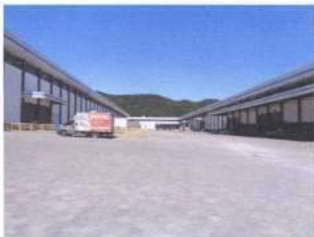
Pátio de manobras e estacionamento, notando-se o pátio interligado ao imóvel de propriedade do Solicitante (à esquerda) não contemplado na presente avaliação.
