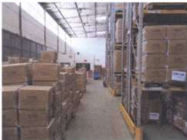
Bloco 2 – Industrial – Setor de Armazenamento – Térreo: pavilhão industrial.
