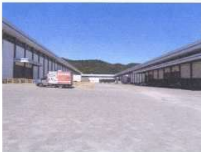
Pátio de manobras e estacionamento, notando-se o pátio interligado ao imóvel de propriedade do Solicitante (à direita) não contemplado na presente avaliação.
