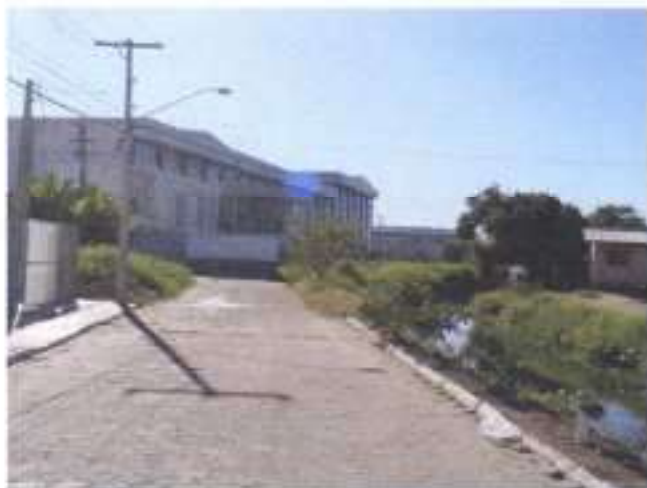
Rua Valdemar Oliveira da Silva (antiga Rua "F") e o leito do Rio Itajai-Acú (ou da Murta) no trecho já urbanizado.
