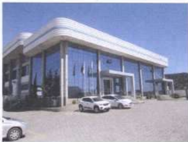
Bloco 1 – Administrativo: Aspectos gerais.
