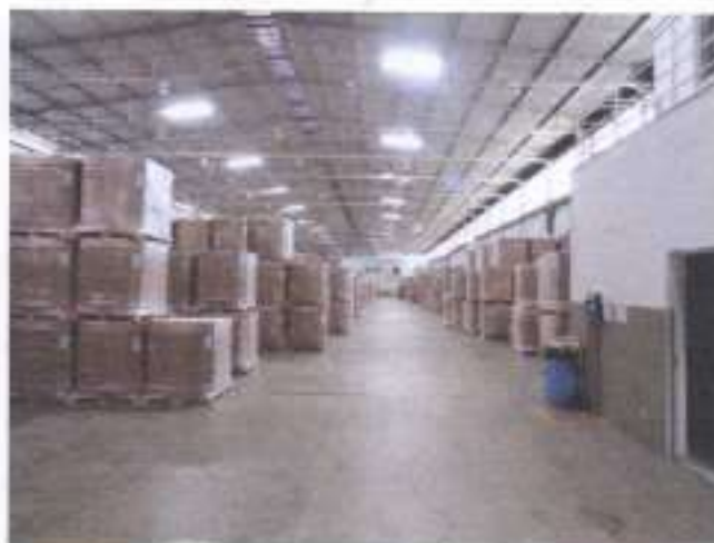
Bloco 2 – Industrial – Setor de Armazenamento – Térreo: pavilhão industrial.
