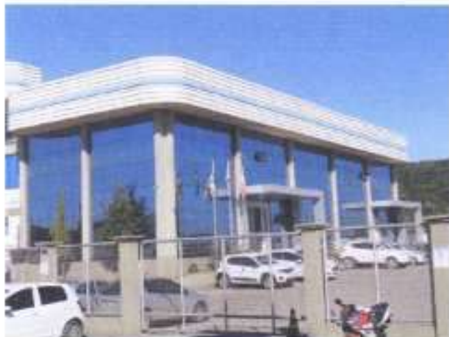
Bloco 1 – Administrativo: Aspectos gerais.
