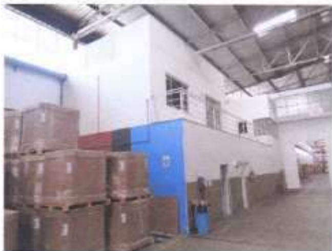
Bloco 2 – Industrial – Mezanino 1 – Setor de Armazenamento: aspectos gerais.
