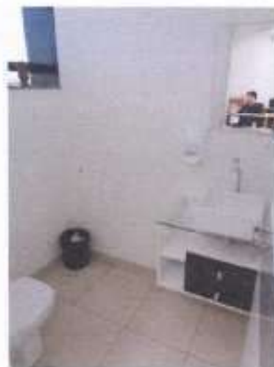
Bloco 1 – Administrativo – Mezanino Ala1; sanitário exclusivo da sala.
