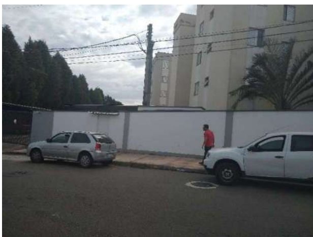
Figura 54 - Vista externa - Terceiro imóvel
