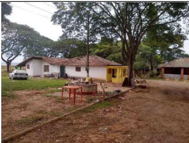
Figura 28 - Vista externa - Primeiro imóvel
