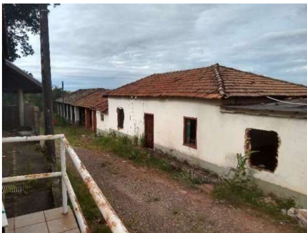
Figura 23 - Vista externa - Primeiro imóvel
