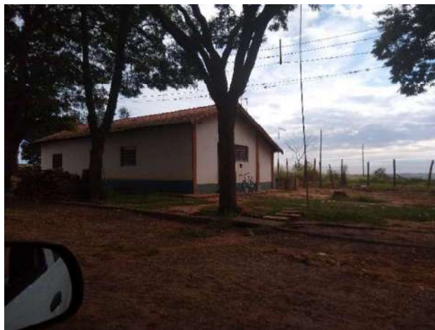
Figura 9 - Vista externa - Primeiro imóvel
