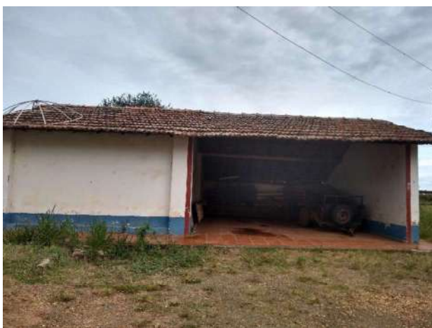
Figura 18 - Vista externa - Primeiro imóvel
