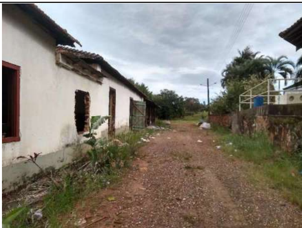
Figura 25 - Vista externa - Primeiro imóvel
