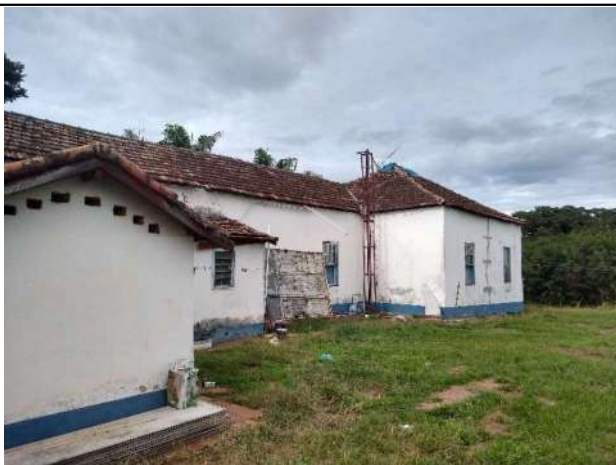
Figura 16 - Vista externa - Primeiro imóvel
