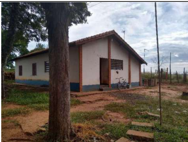
Figura 10 - Vista externa - Primeiro imóvel
