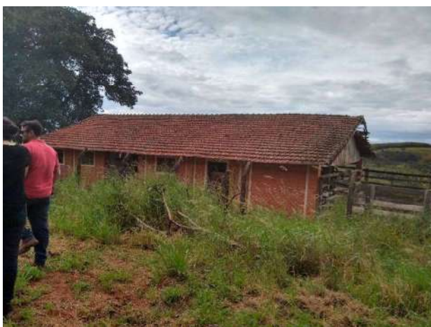
Figura 36 - Vista externa - Primeiro imóvel
