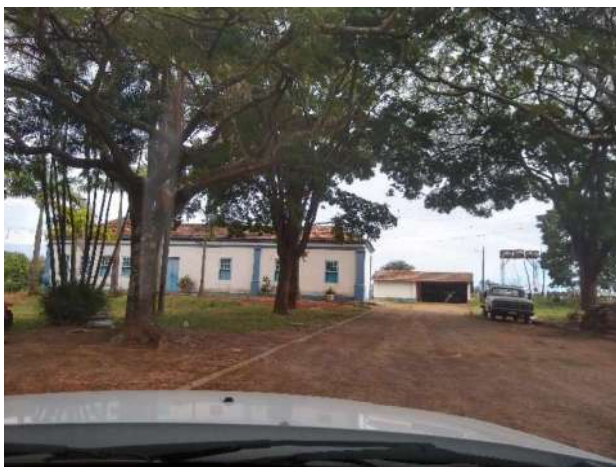
Figura 11 - Vista externa - Primeiro imóvel
