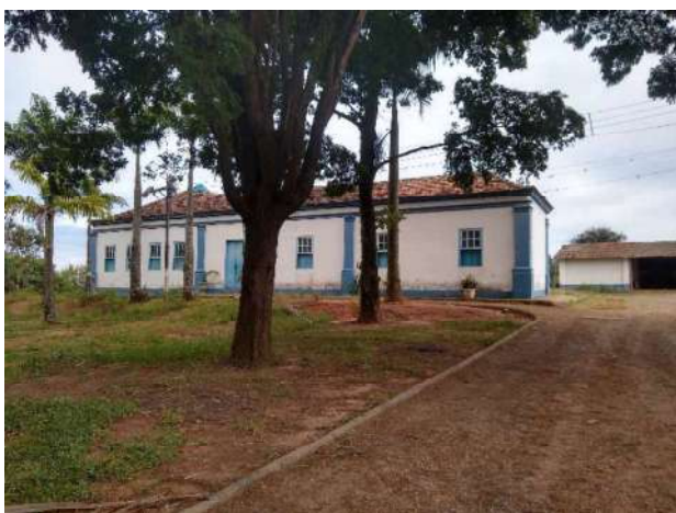
Figura 12 - Vista externa - Primeiro imóvel
