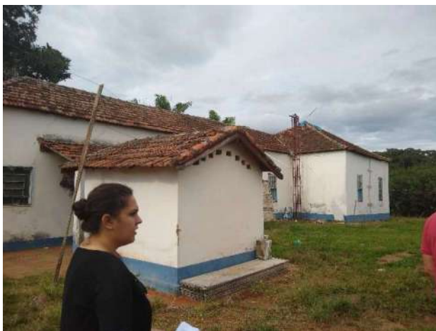
Figura 14 - Vista externa - Primeiro imóvel
