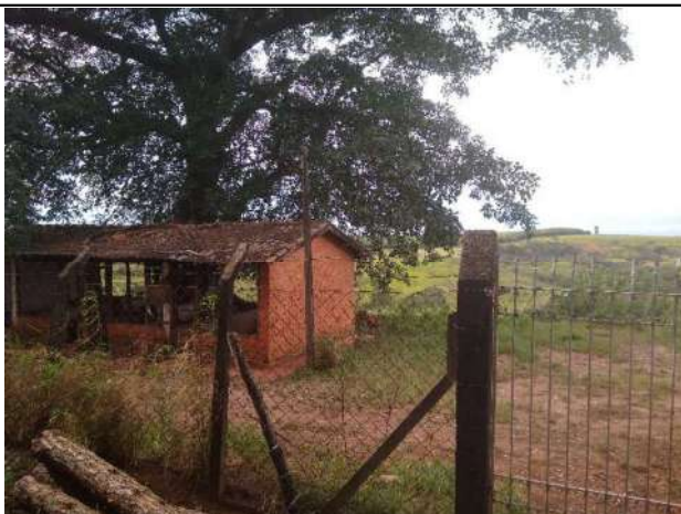
Figura 37 - Vista externa - Primeiro imóvel
