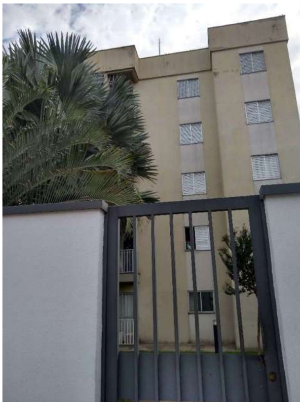
Figura 56 - Vista externa - Terceiro imóvel
