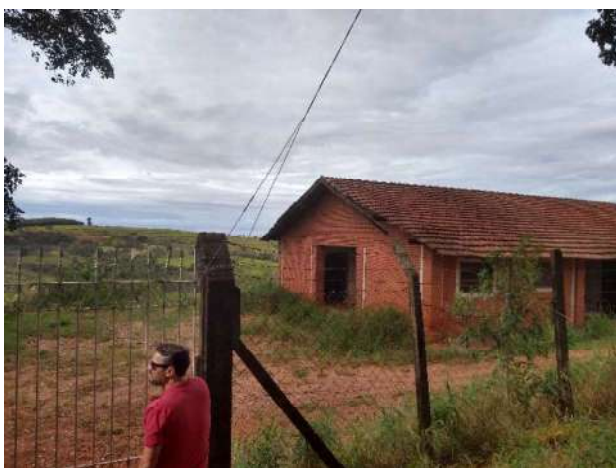
Figura 39 - Vista externa - Primeiro imóvel
