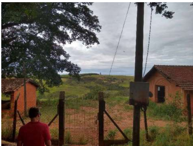
Figura 38 - Vista externa - Primeiro imóvel
