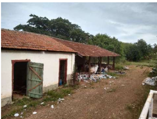
Figura 24 - Vista externa - Primeiro imóvel
