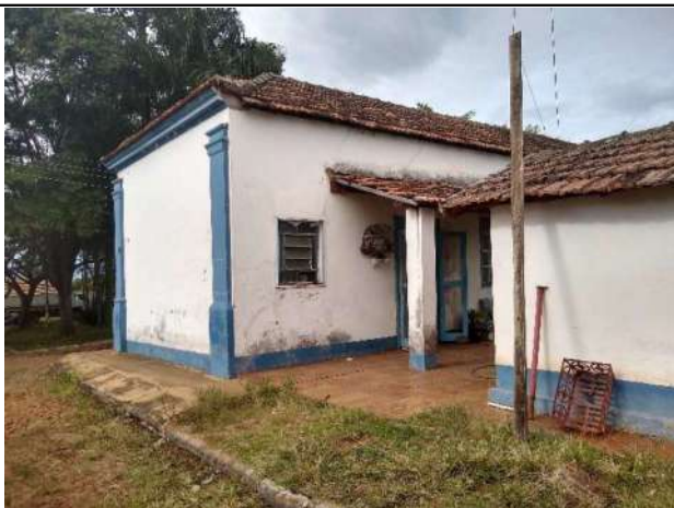
Figura 13 - Vista externa - Primeiro imóvel
