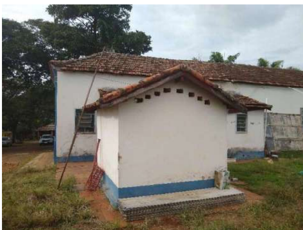
Figura 15 - Vista externa - Primeiro imóvel
