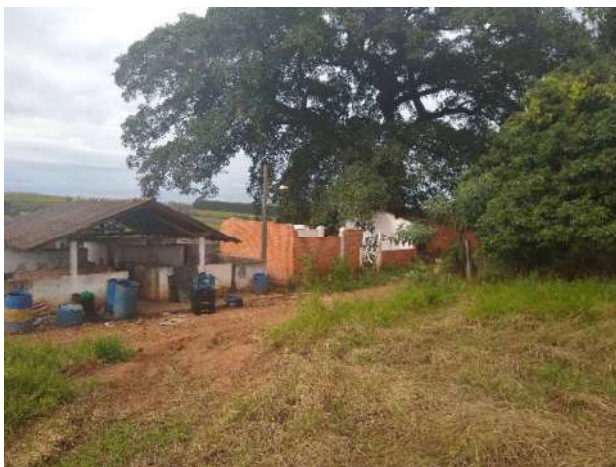
Figura 41 - Vista externa - Primeiro imóvel
