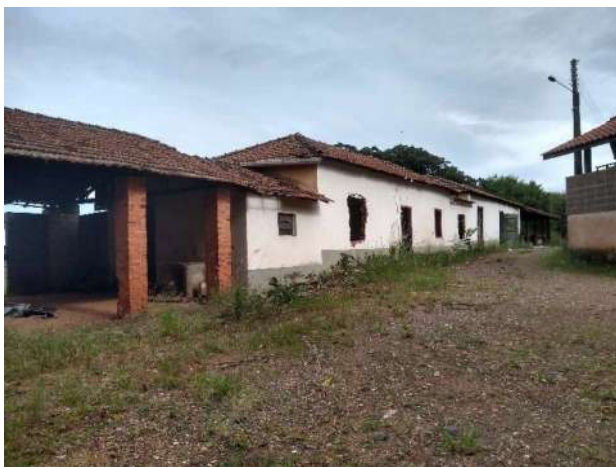
Figura 26 - Vista externa - Primeiro imóvel
