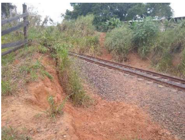
Figura 48 - Vista externa - Segundo imóvel
