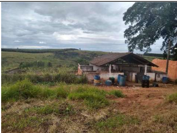
Figura 40 - Vista externa - Primeiro imóvel
