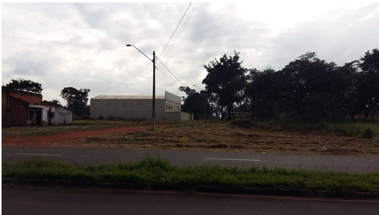
Foto 01 – Vista Frontal do Imóvel 1 (Lote 138 – Quadra H)
