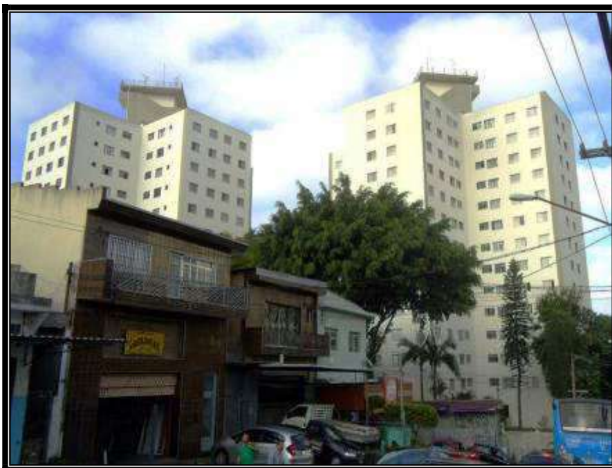
Vista geral do Conjunto Planalto Marajoara, estando, o Edifício Paranoá, onde se encontra o apartamento em questão, à esquerda.
