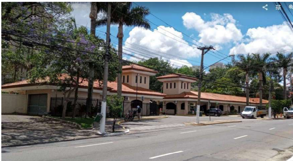
FOTO 01 – Fachada do condomínio.
