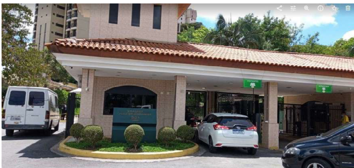
FOTO 02 – Entrada/Guarita do condomínio
