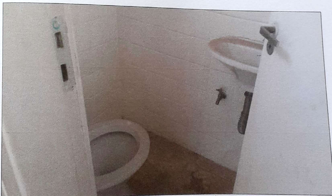
Figura 9 – Banheiro de serviço
