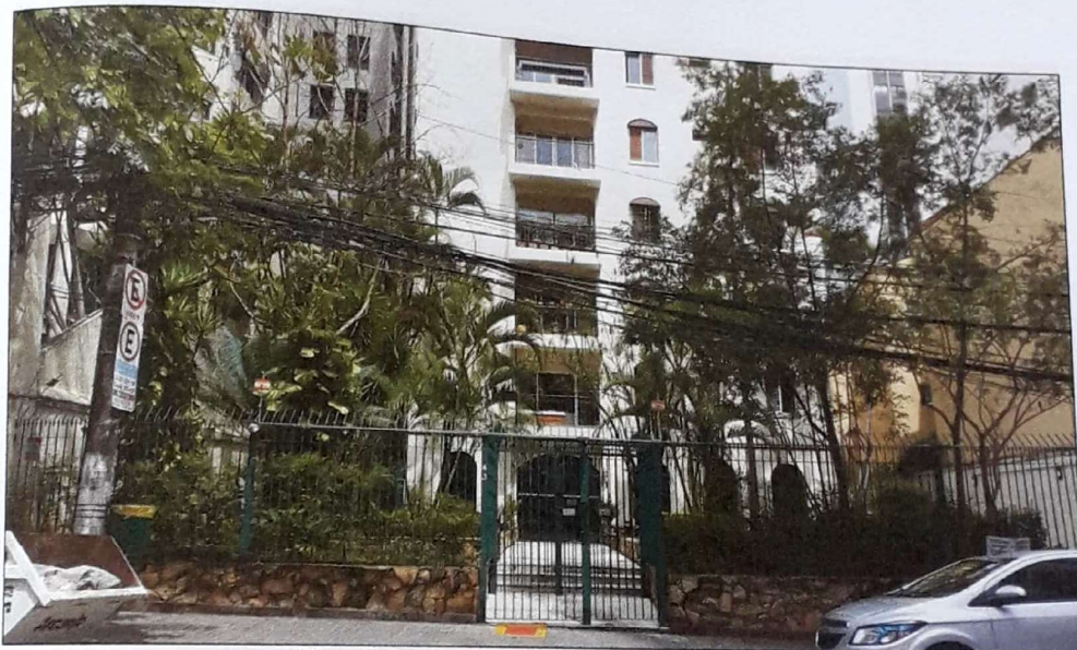
Figura 2 – Fachada do edifício Vera Cristina
