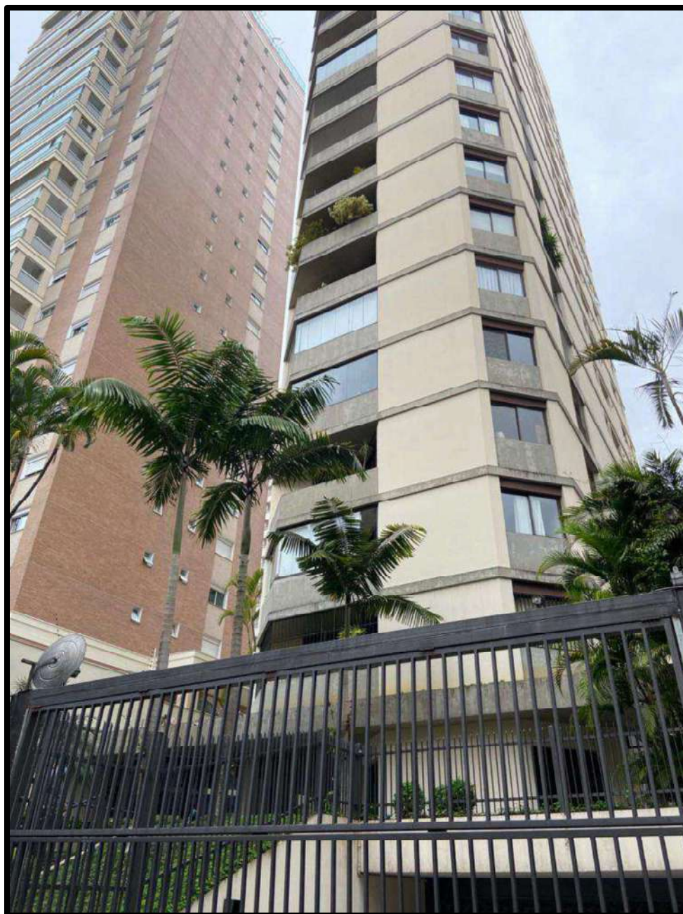
Foto nº 03 – Ilustra a fachada frontal do edifício.
