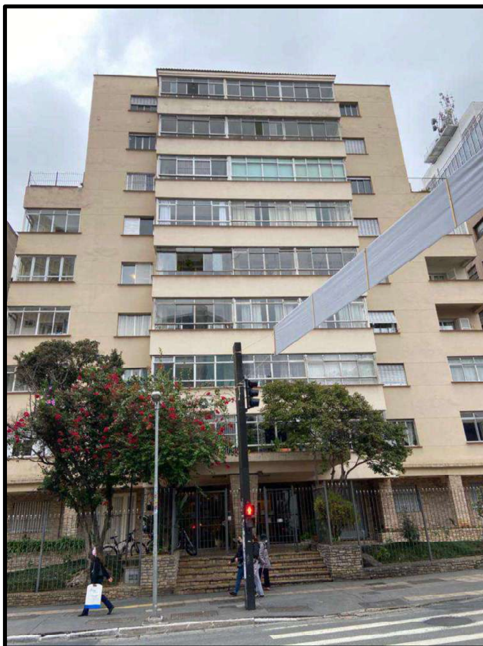
Foto nº 04 – Vista da fachada frontal do edifício.
