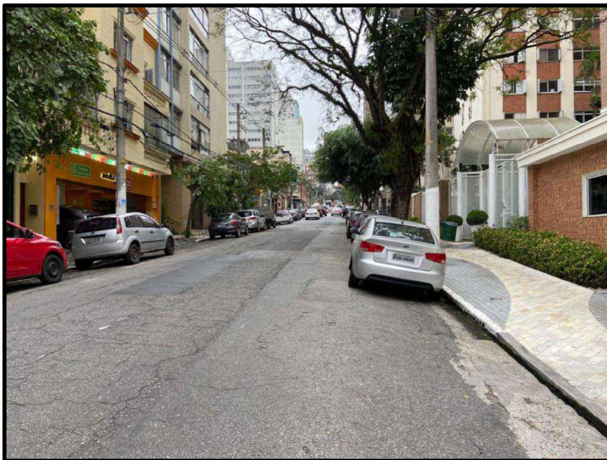
Foto nº 01 – Aspecto geral do local.
