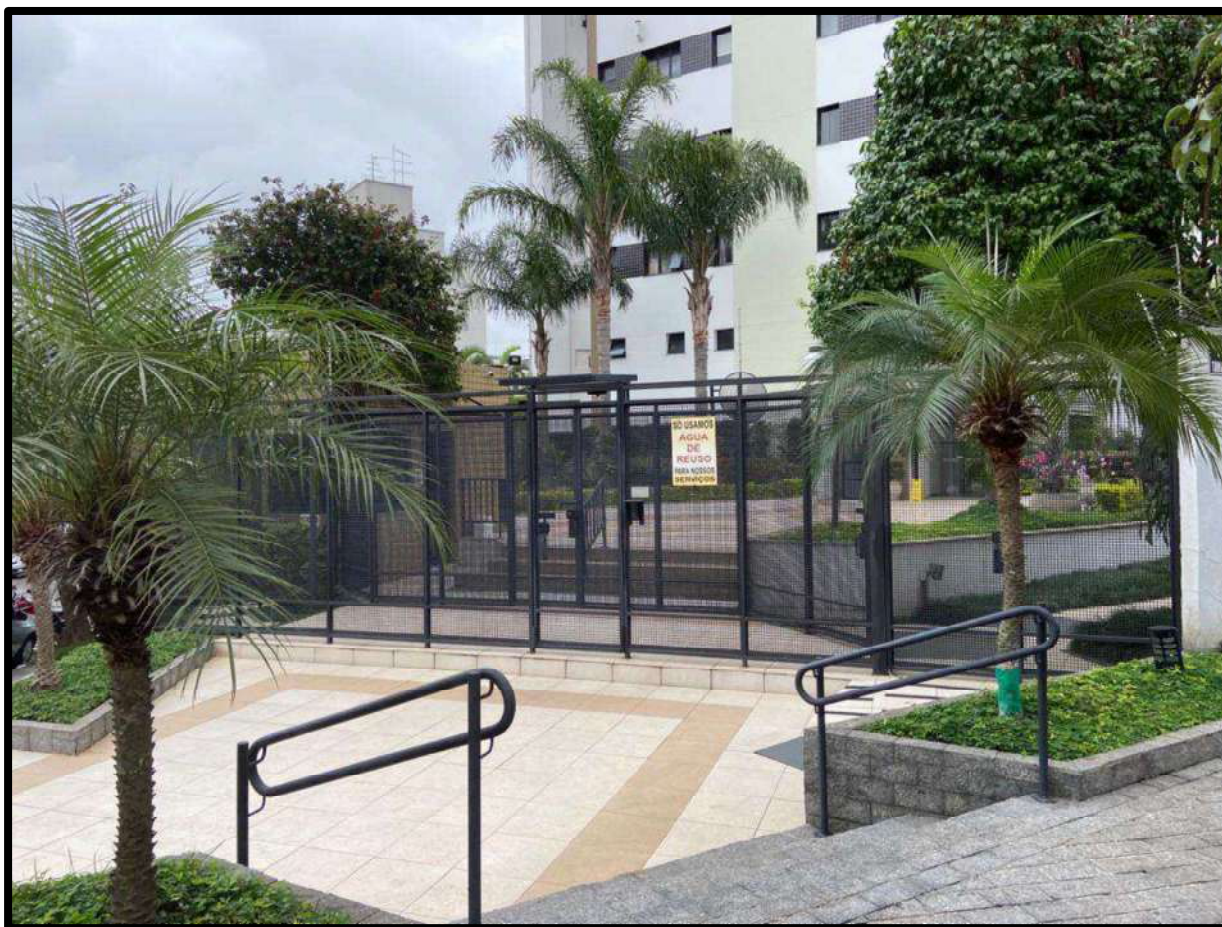
Foto nº 07 – Ilustra o portão de acesso ao edifício destinado aos pedestres.
