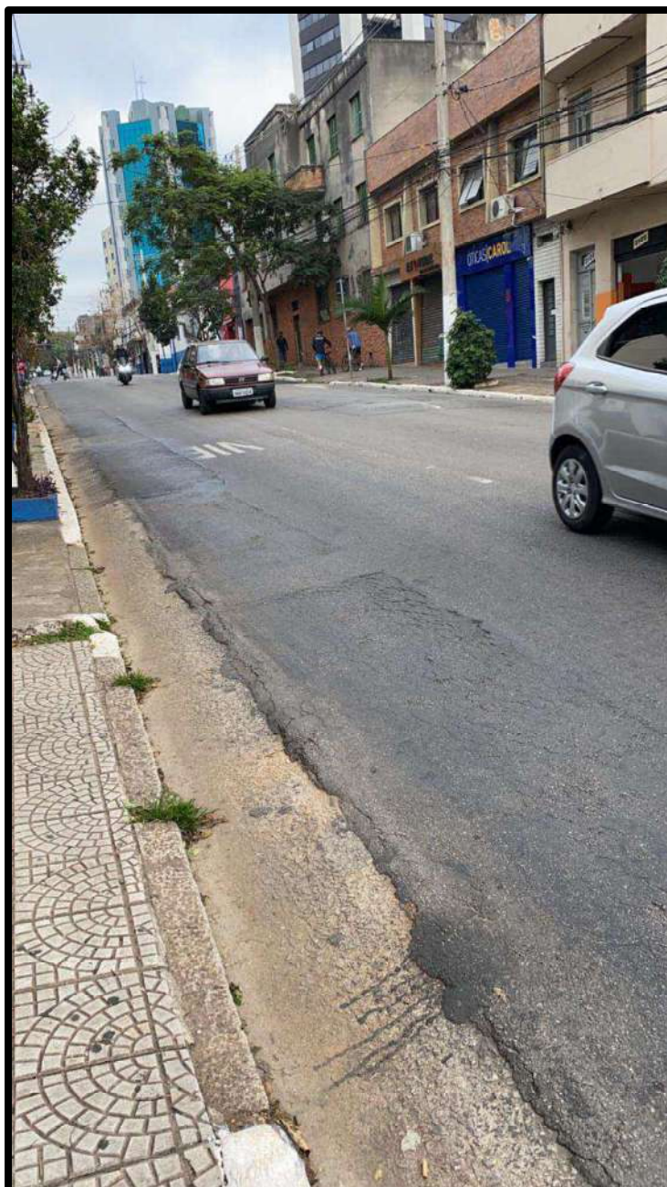
Foto nº 01 – Aspecto geral do local.
