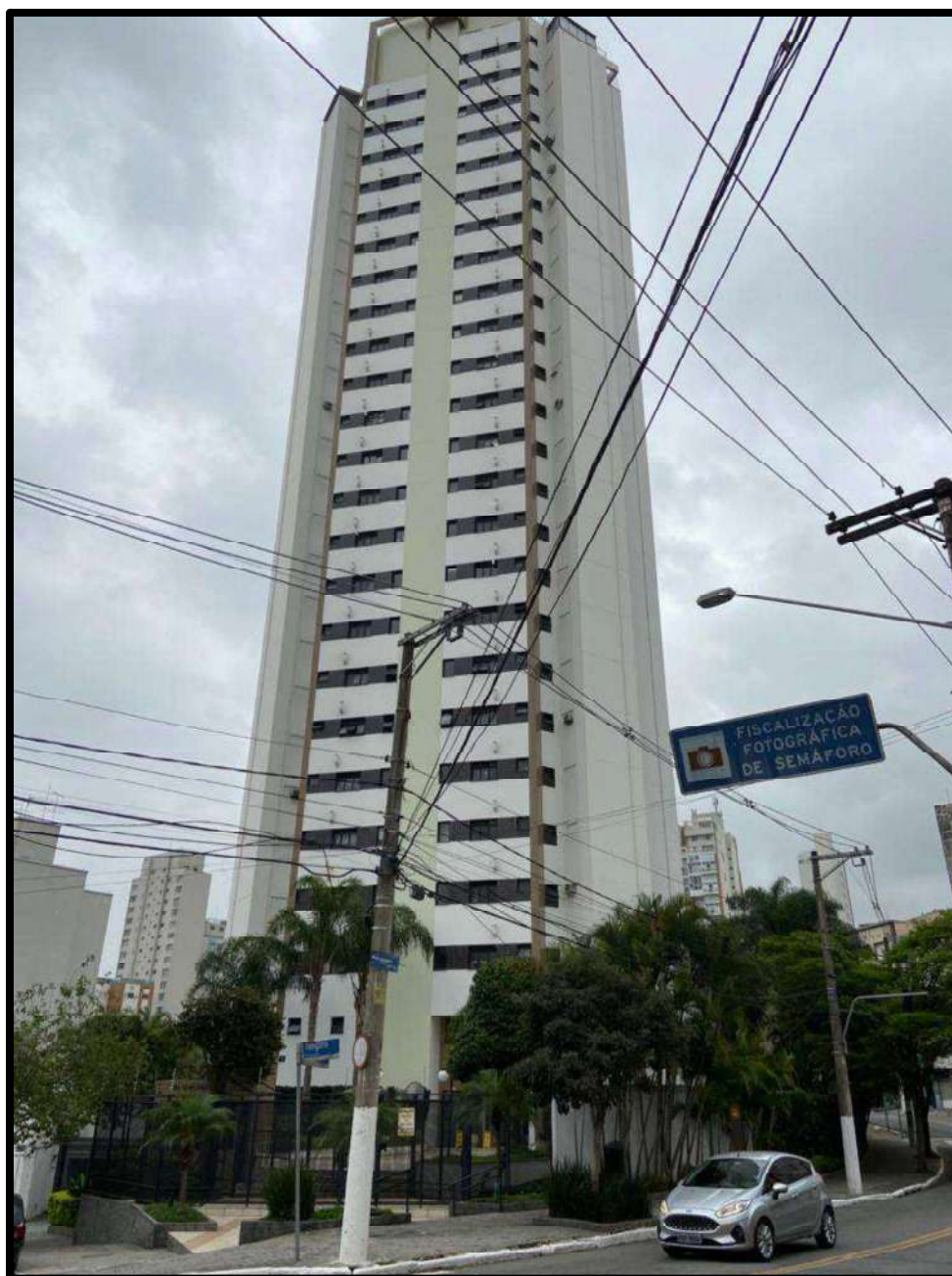
Foto nº 05 – Vista da entrada e da fachada do edifício.
