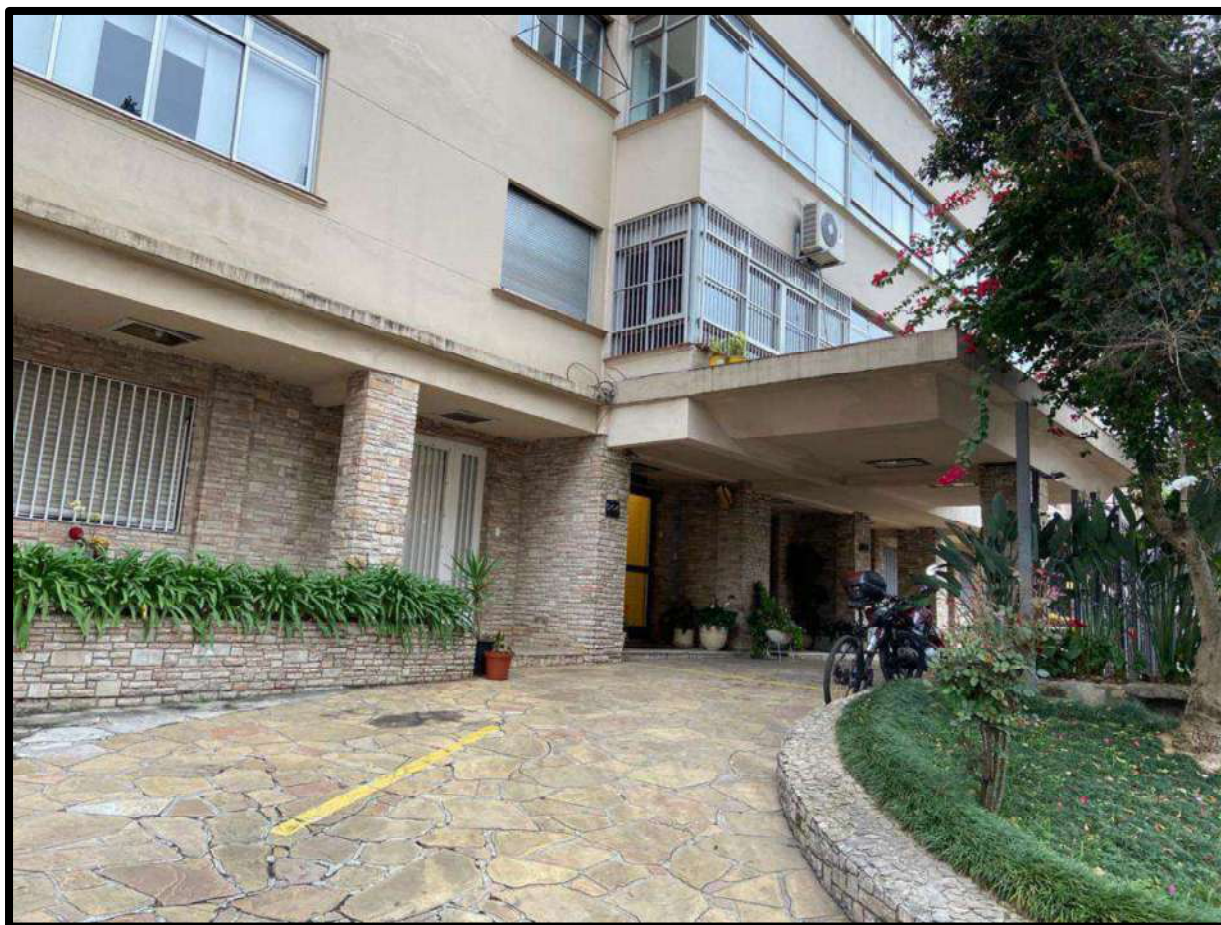
Foto nº 07 – Vista da entrada social do condomínio.
