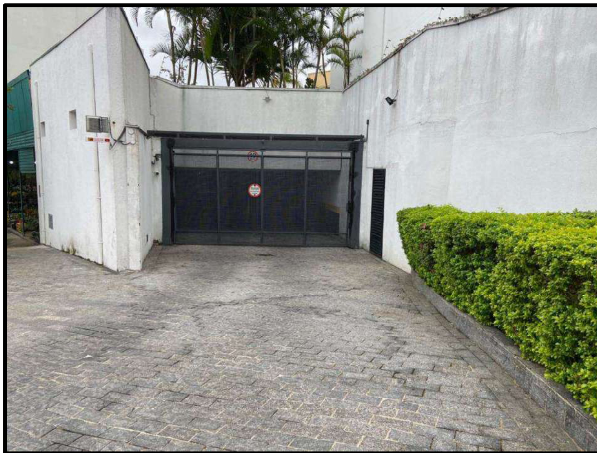
Foto nº 08 – Ilustra o portão de acesso ao edifício destinado aos veículos.
