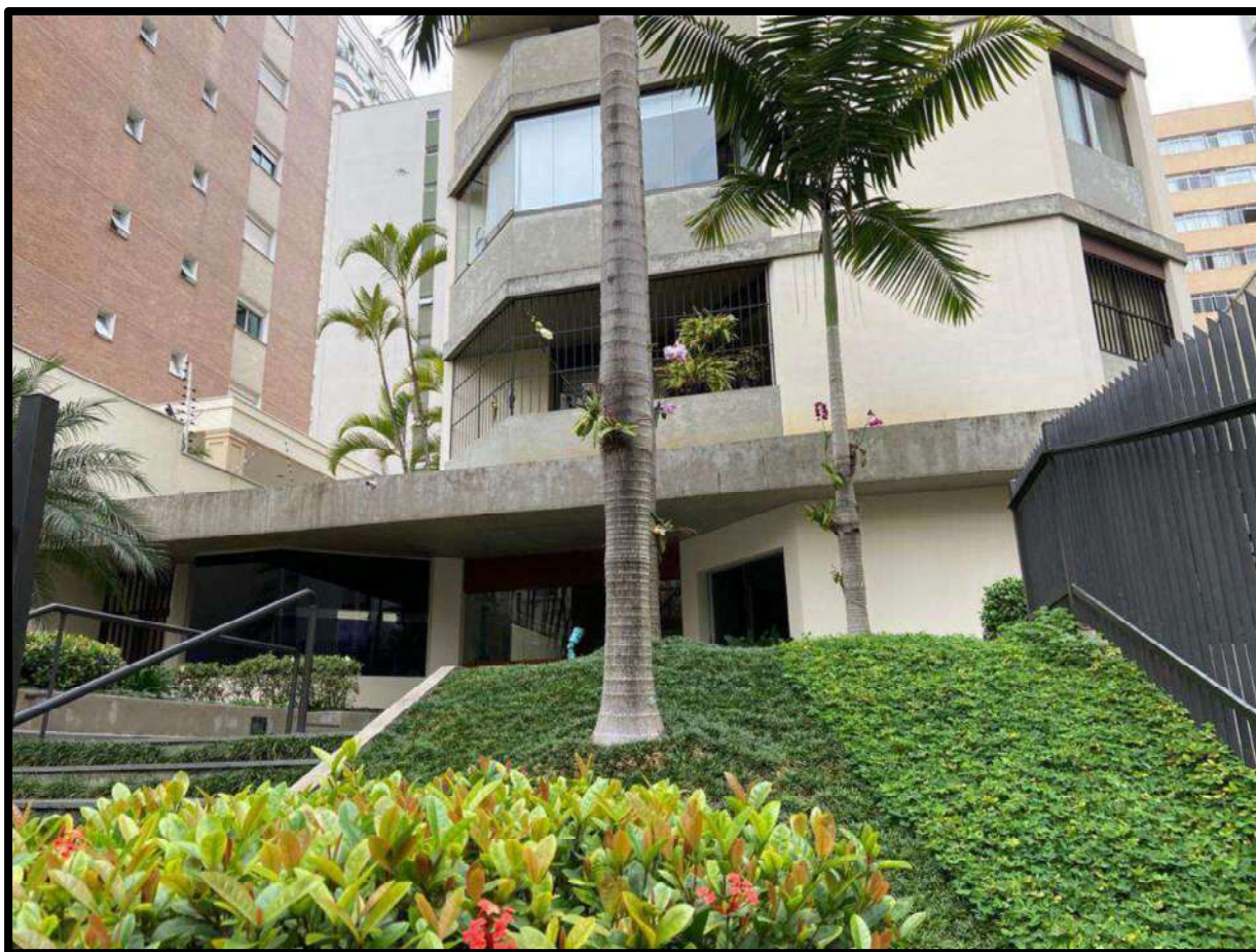
Foto nº 07 – Vista da entrada social do condomínio.
