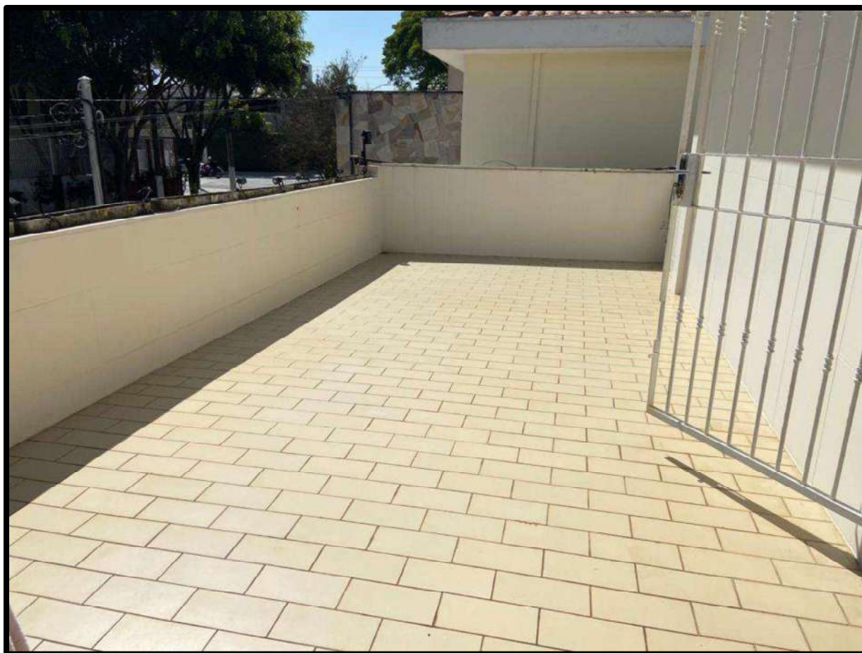
Foto nº 11 – Vista parcial da varanda.
