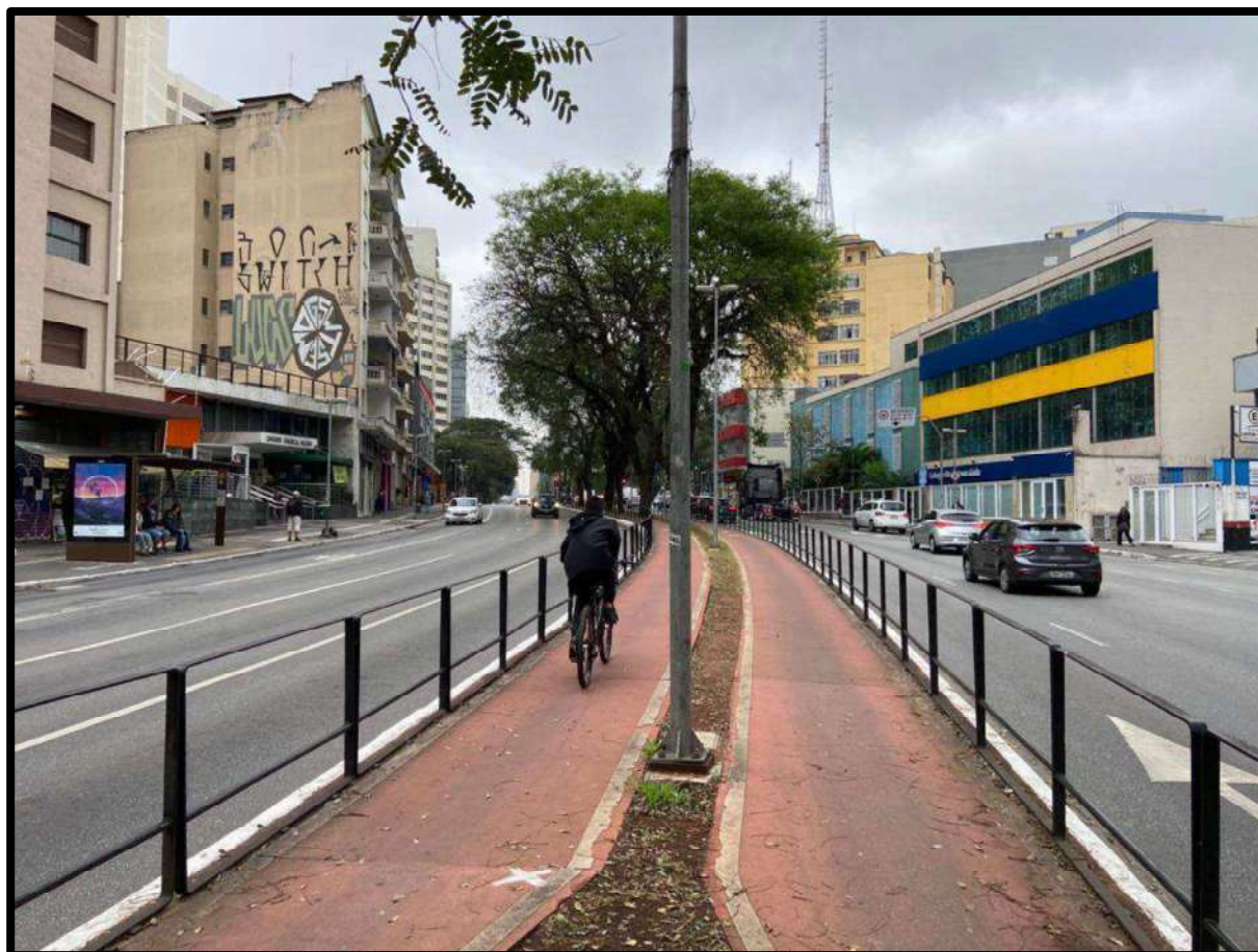
Foto nº 08 – Ilustra a existência de ciclovia localizada em frente ao edifício.
