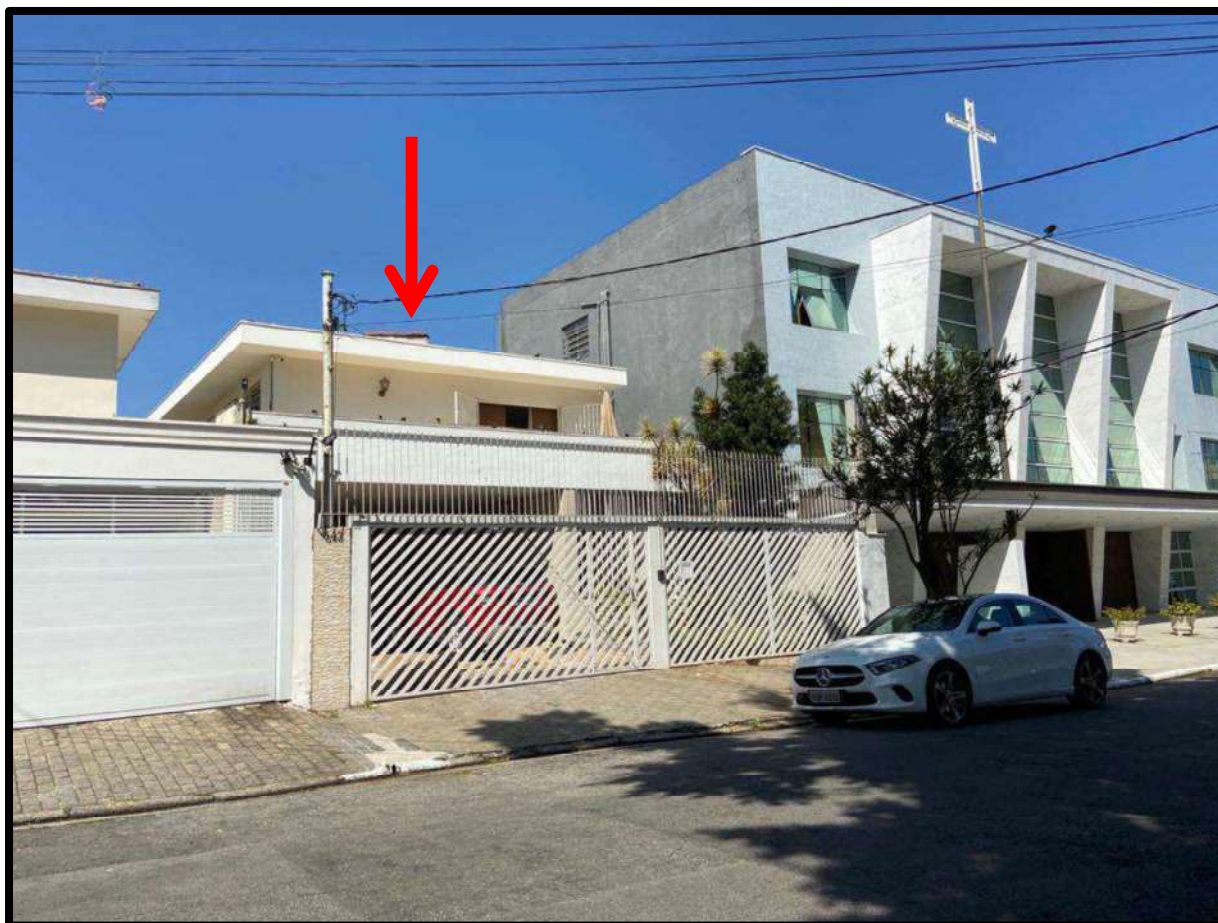
Foto nº 02 – Vista da fachada frontal do imóvel avaliando.
