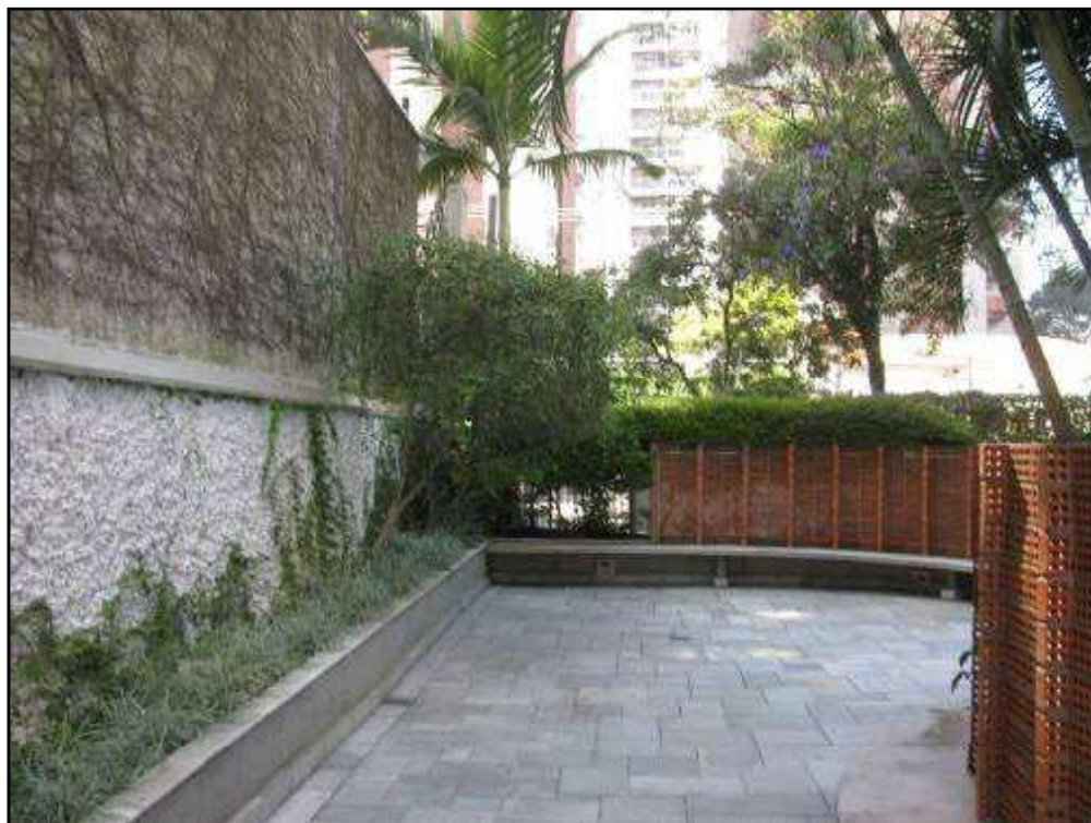
FOTO 07 VISTA DA ÁREA LIVRE NO TÉRREO.
