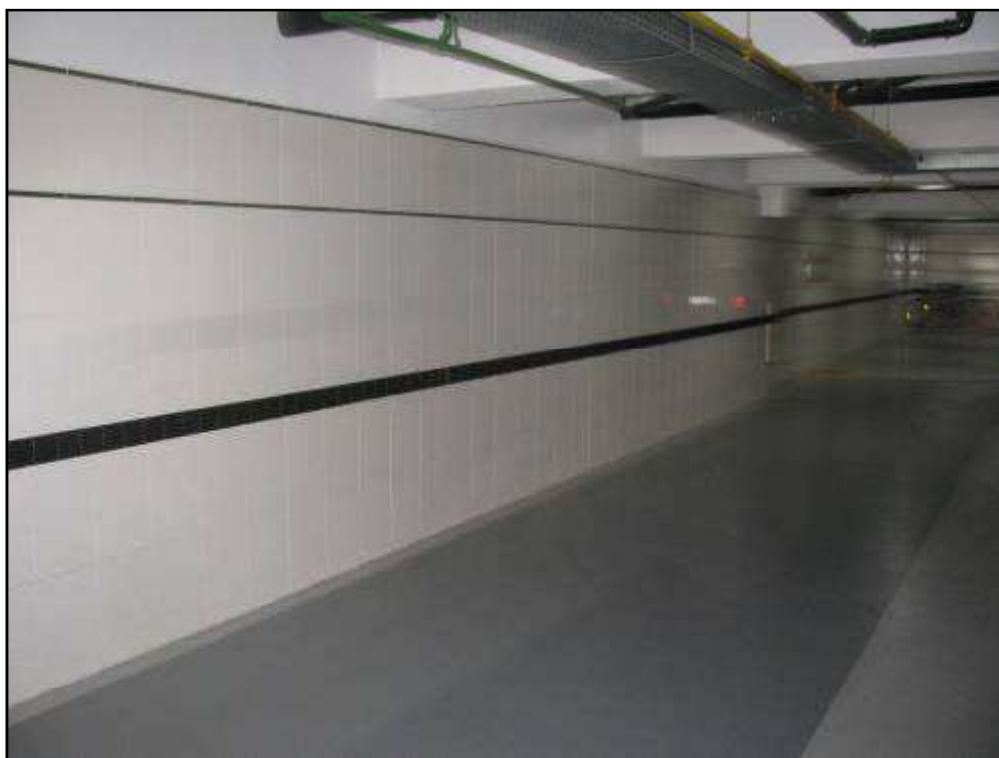
FOTO 39 VISTA DA GARAGEM.
