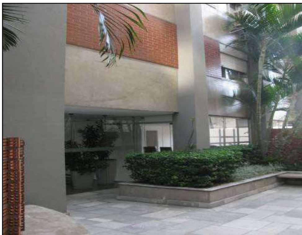
FOTO 06 VISTA DA ÁREA LIVRE NO TÉRREO.
