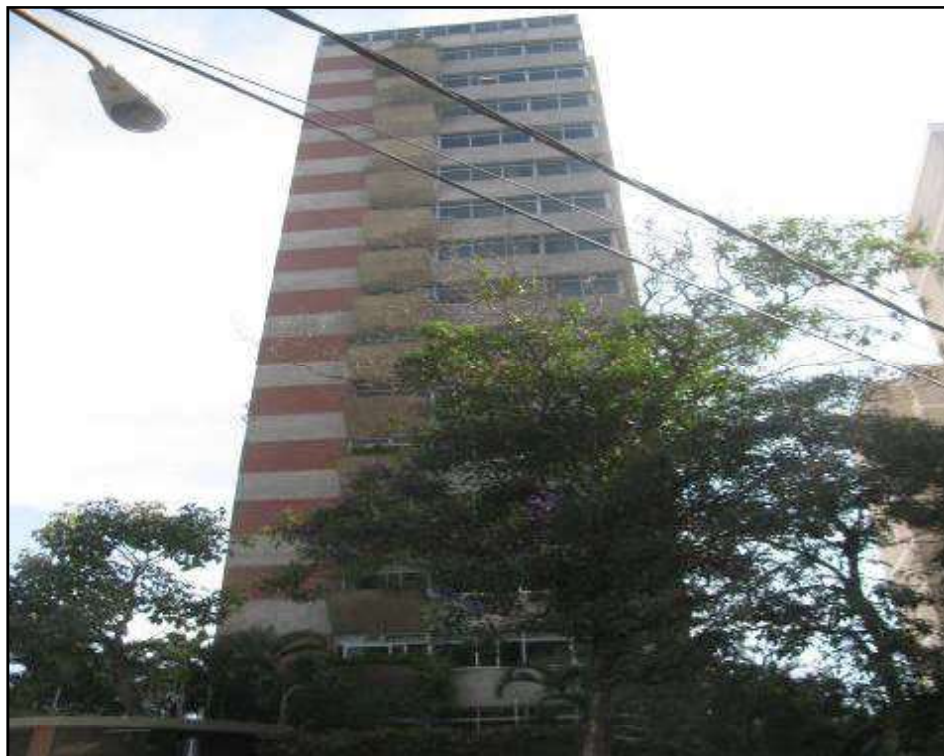
FOTO 03 VISTA DO EDIFÍCIO SOLARES DA COLINA..
