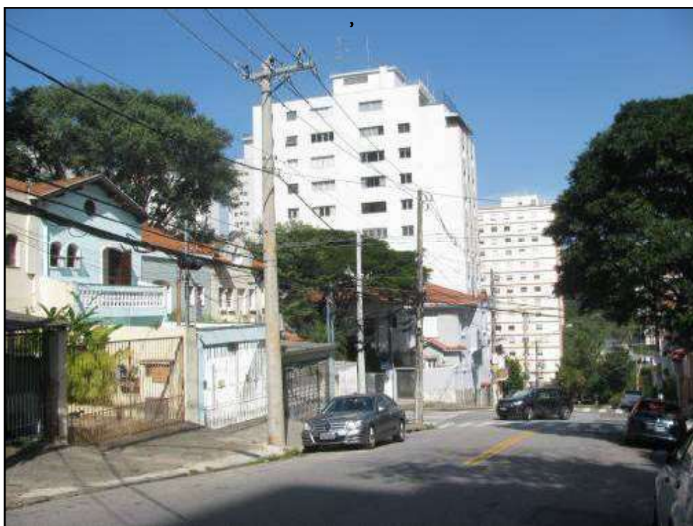
FOTO 02 VISTA DA RUA MONTE ALEGRE, NO SENTIDO OPOSTO.
