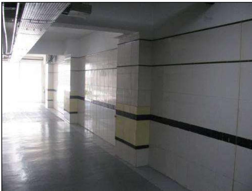
FOTO 40 VISTA DA GARAGEM.
