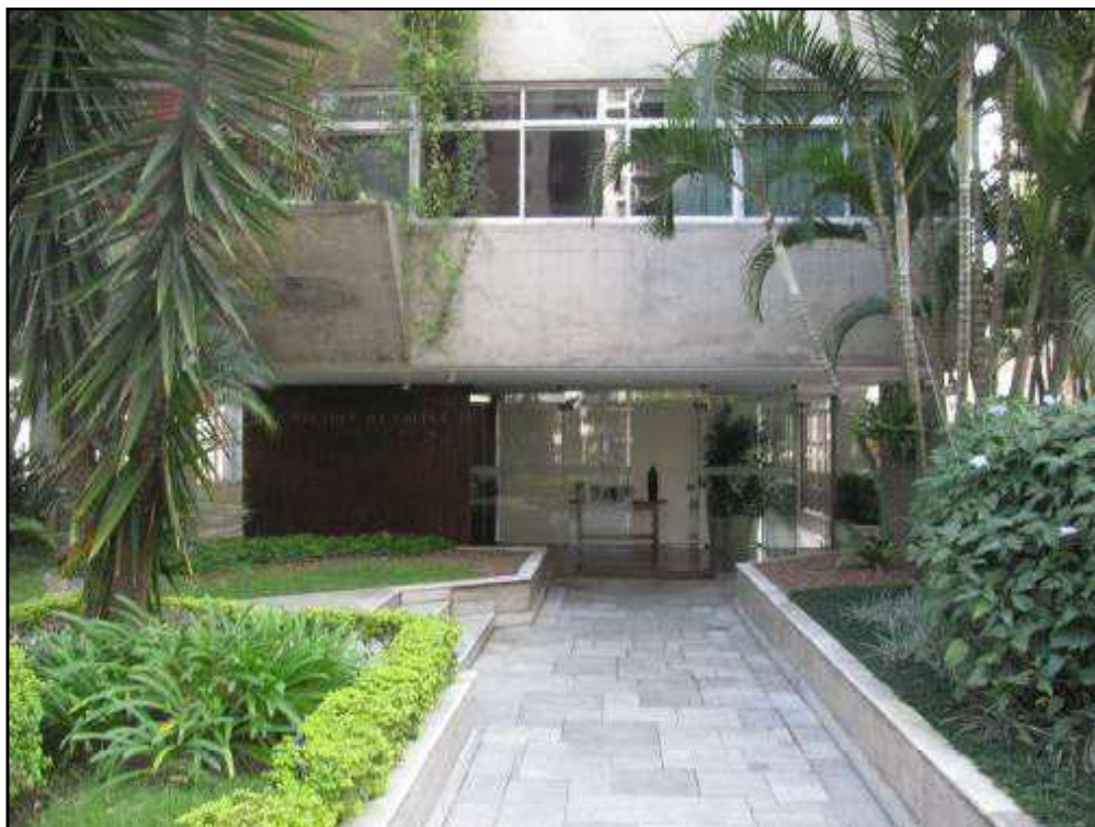
FOTO 05 VISTA DA ENTRADA SOCIAL.
