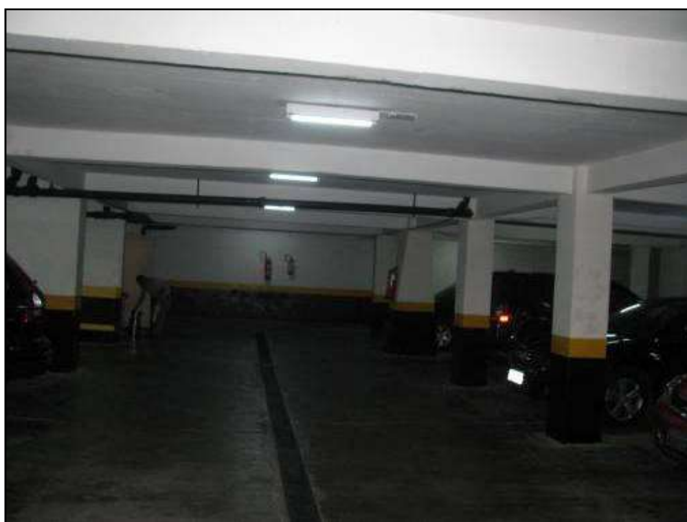
FOTO 28 VISTA DA GARAGEM NO SUBSOLO.
