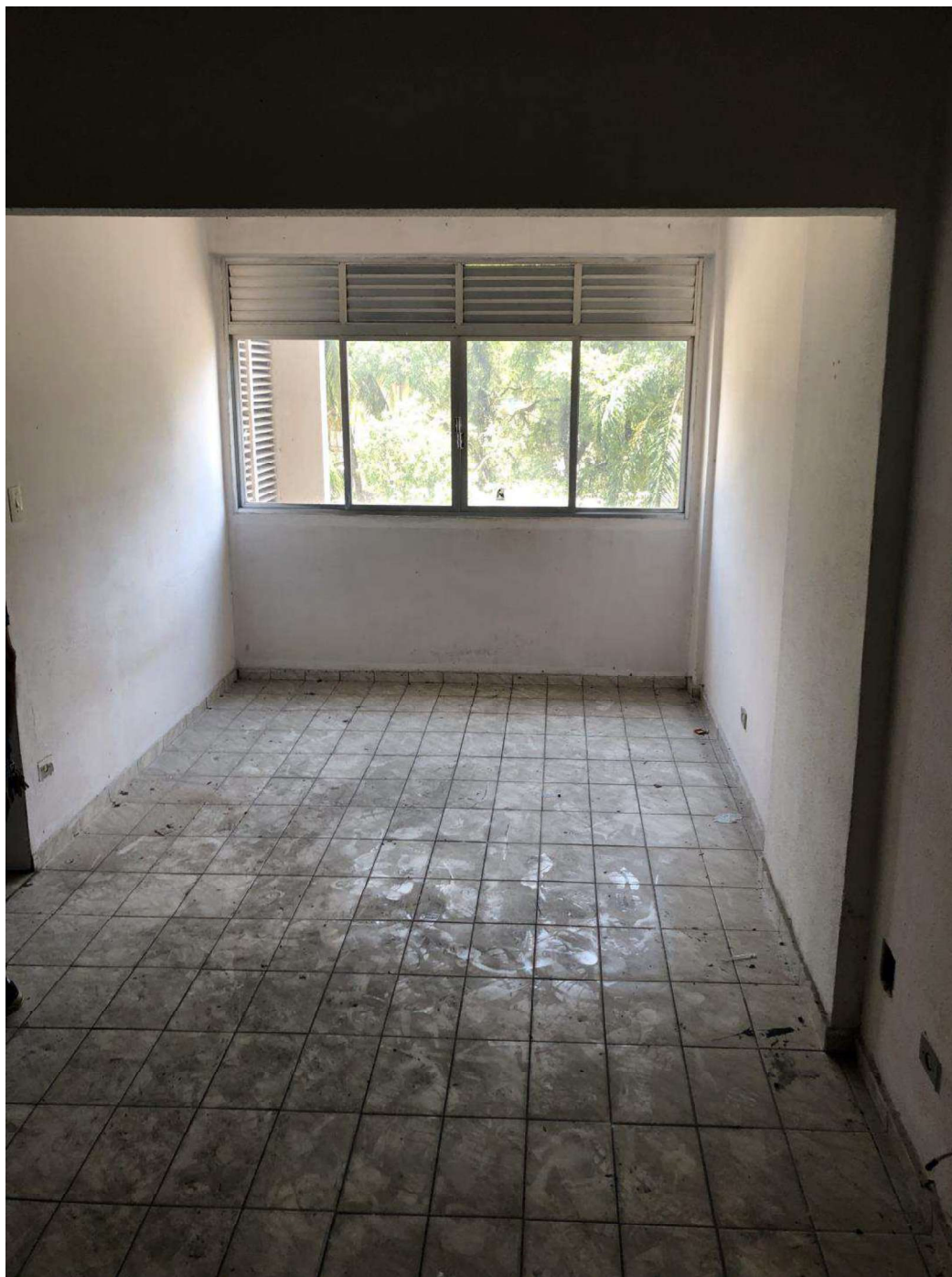
FOTO 3 – VISTA DA SALA
