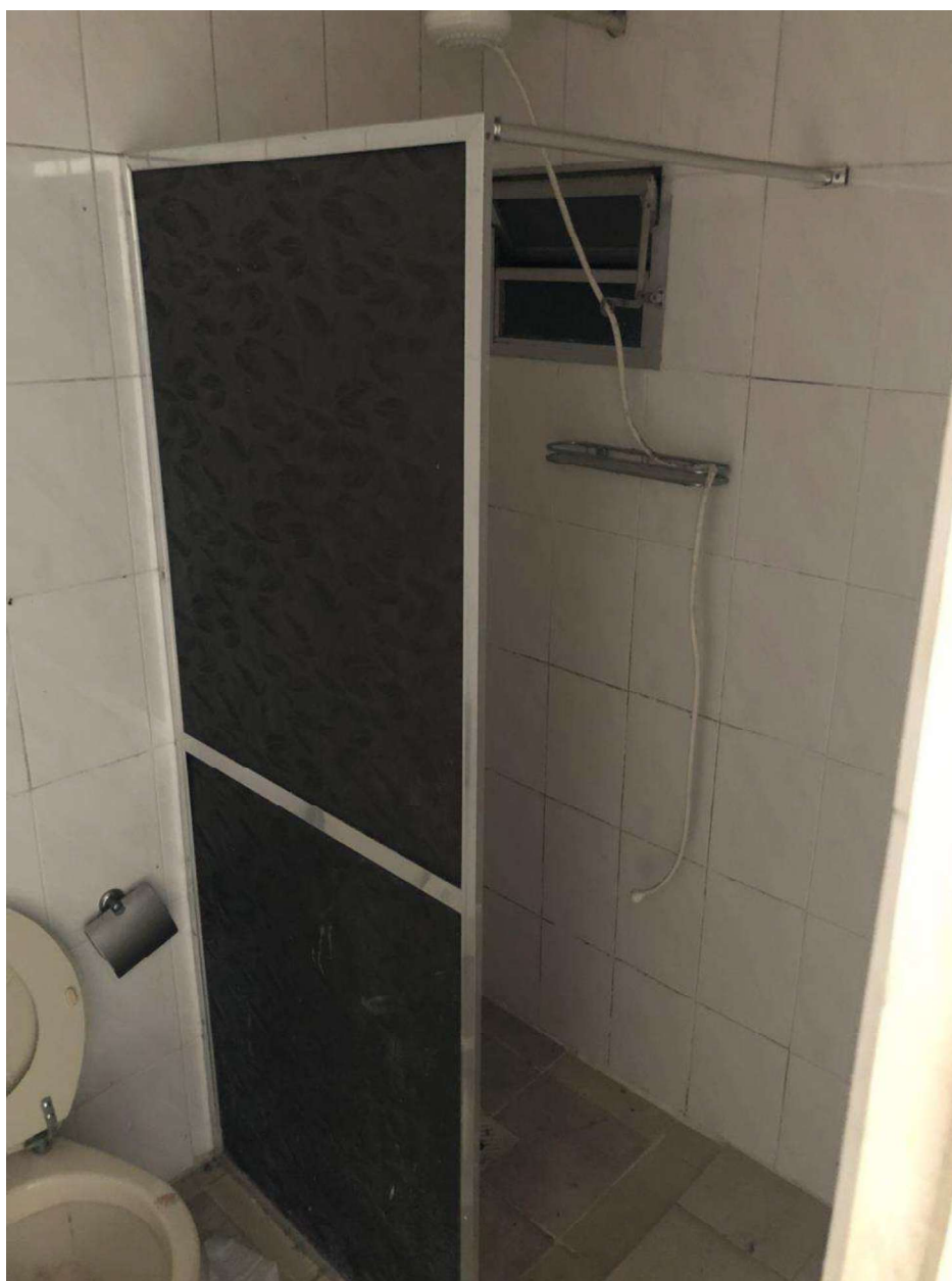
FOTO 5 – VISTA DO BANHEIRO
