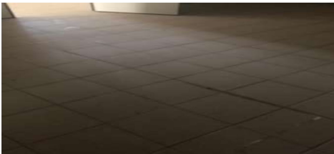
Piso interno antigo
