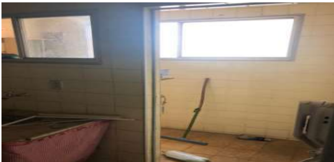
Acesso a área de serviço
