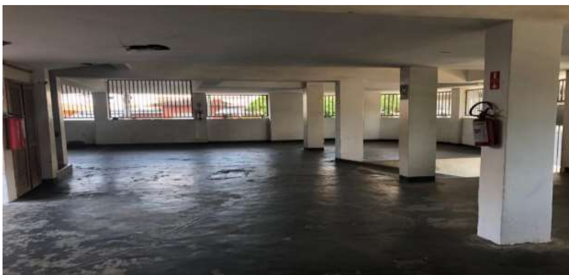
Vagas internas - Estacionamento coberto
