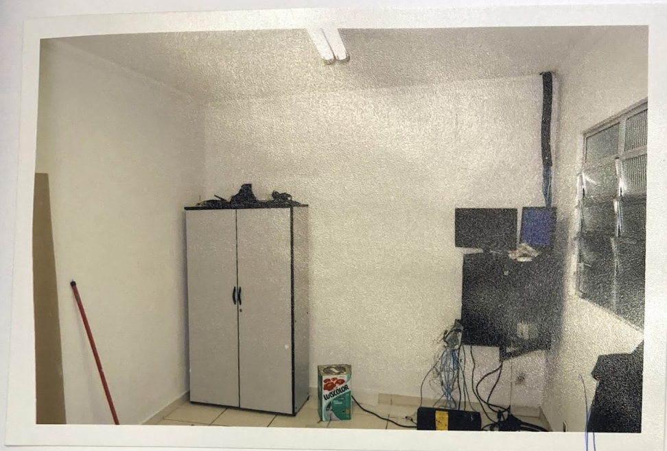
Foto de nº 16 - Vista da unidade avalianda.
