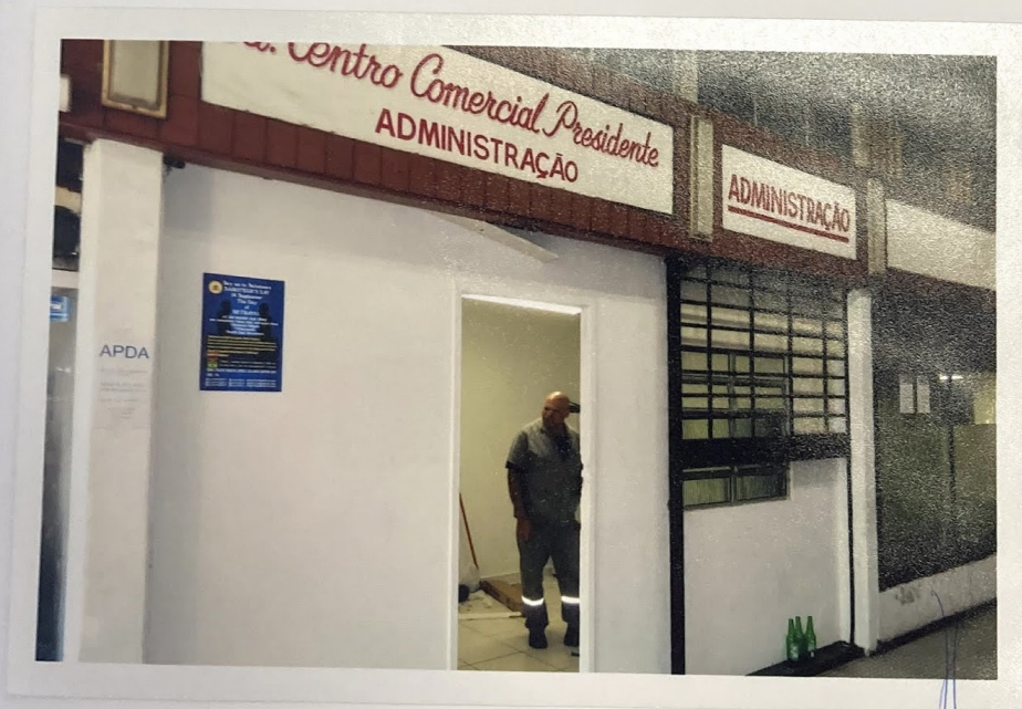
Foto de nº 13 - Vista da fachada da unidade avalianda.
