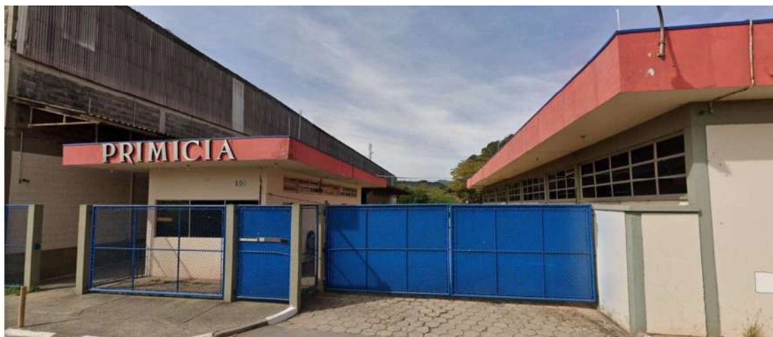
Foto 01 – Vista da entrada principal - Av. David Kasitzki, 135
