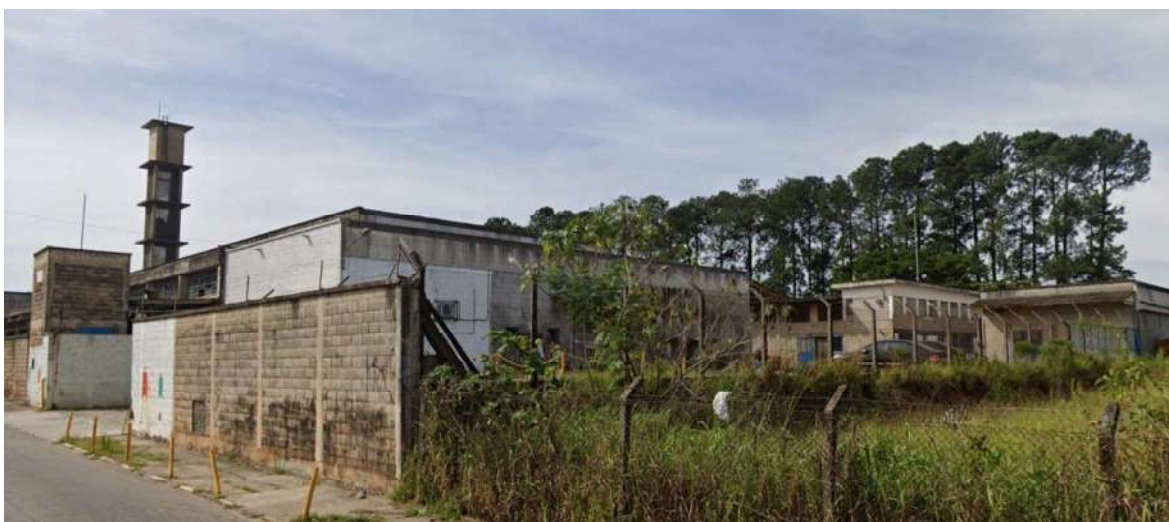
Foto 07 – Vista externa dos galpões
