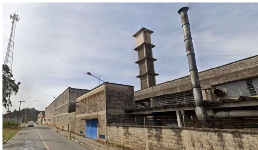
Foto 09 – Vista externa dos galpões
