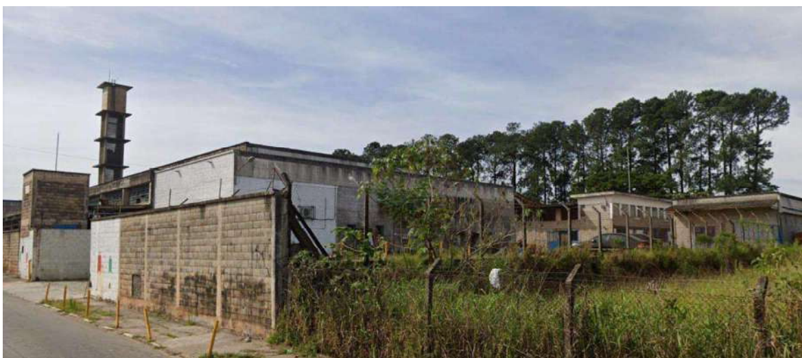
Foto 07 – Vista externa dos galpões
