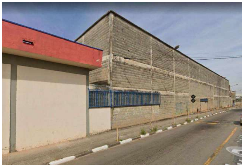
Foto 03 – Vista externa dos galpões
