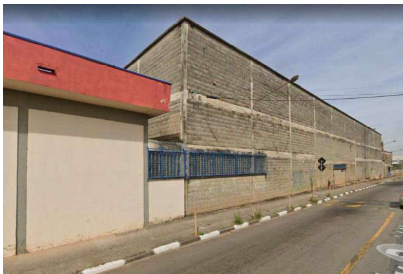
Foto 03 – Vista externa dos galpões
