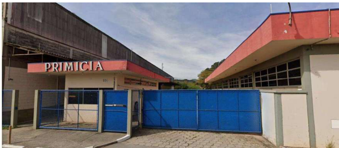
Foto 01 – Vista da entrada principal - Av. David Kasitzki, 135
