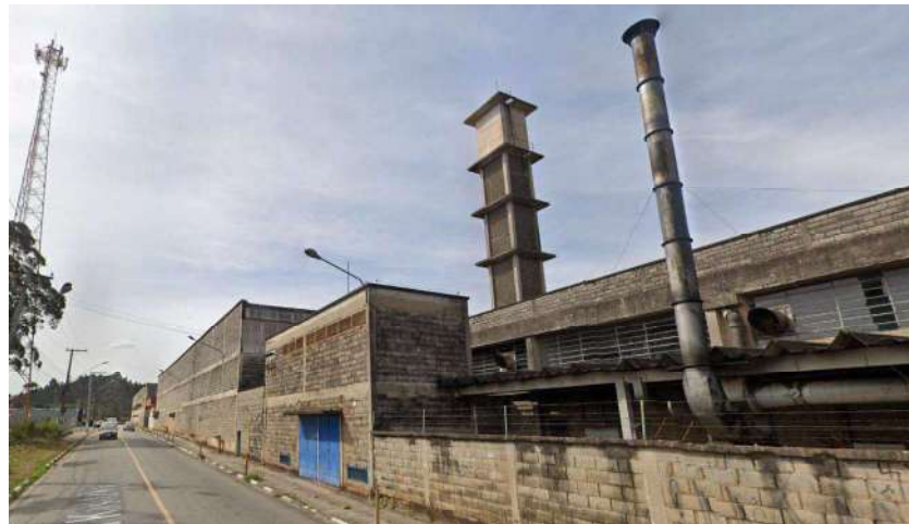
Foto 09 – Vista externa dos galpões
