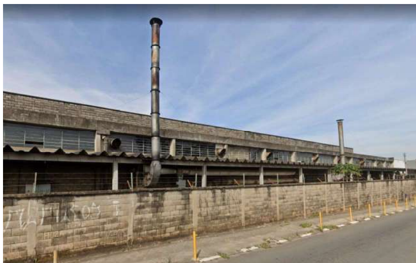
Foto 05 – Vista externa dos galpões
