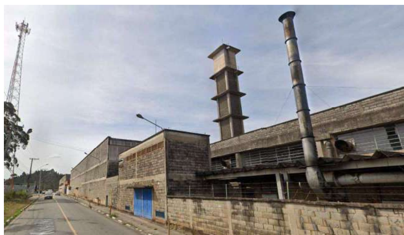
Foto 09 – Vista externa dos galpões
