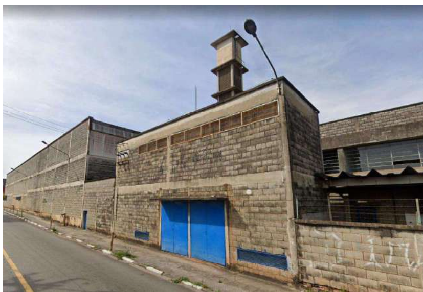
Foto 04 – Vista externa dos galpões
