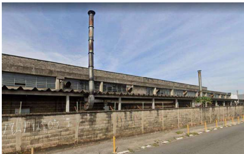
Foto 05 – Vista externa dos galpões
