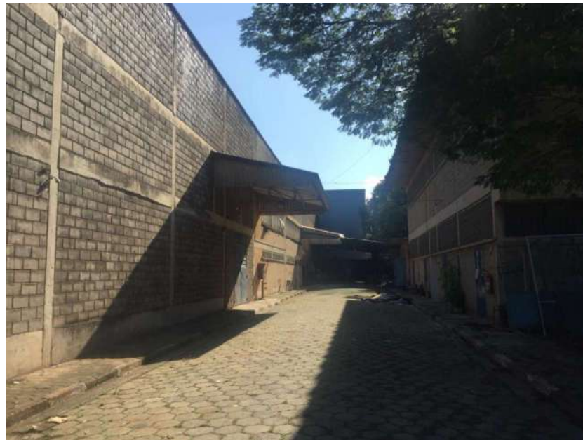
Foto 42 – Fundos do Galpão A1
