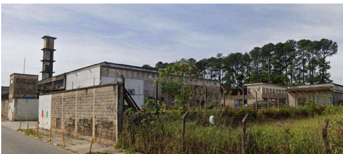
Foto 07 – Vista externa dos galpões
