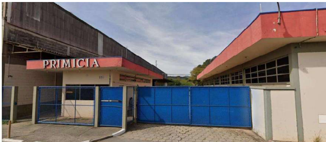
Foto 01 – Vista da entrada principal - Av. David Kasitzki, 135
