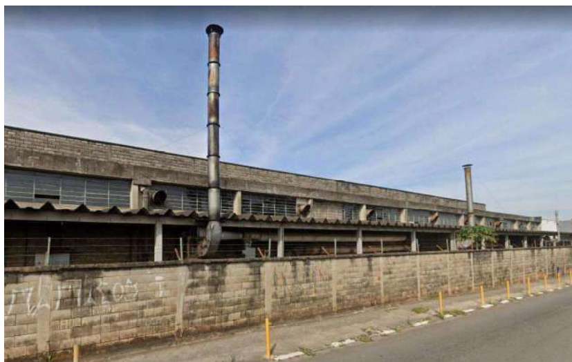
Foto 05 – Vista externa dos galpões
