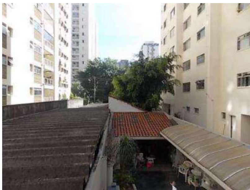
05 – Vista superior do imóvel.
