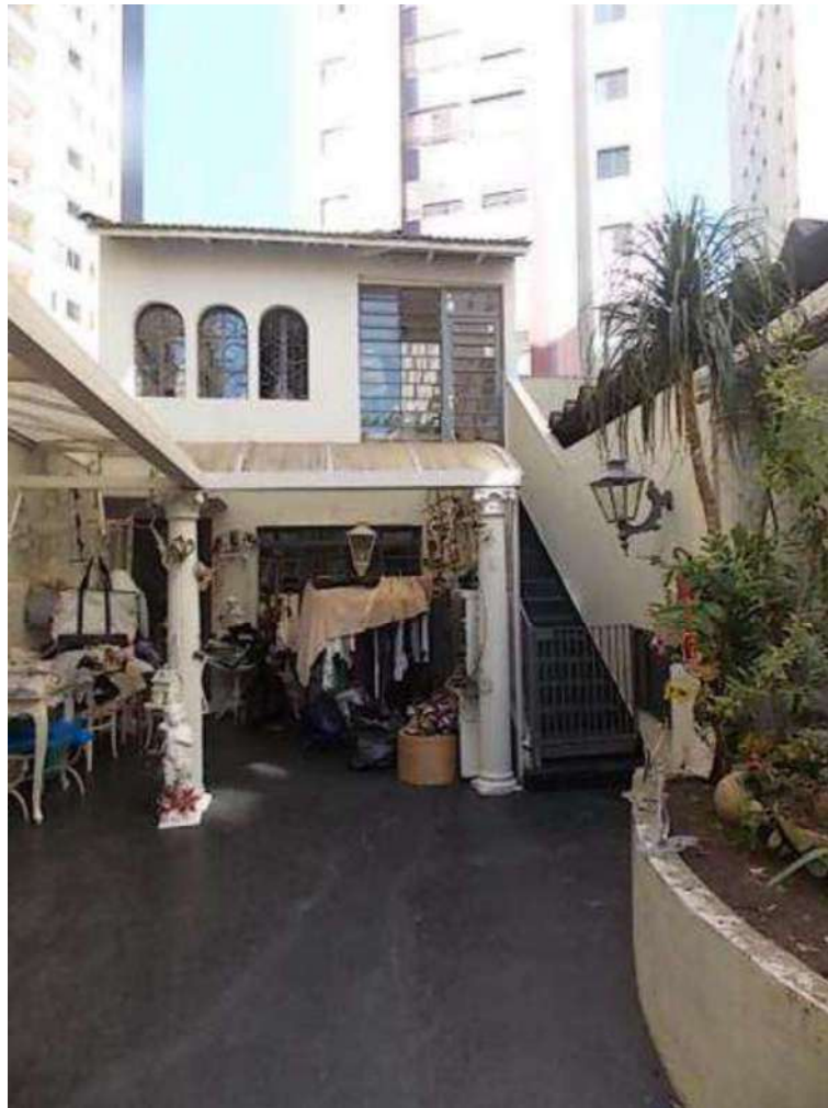
06 - Vista dos fundos do imóvel, vendo-se a edícula.
