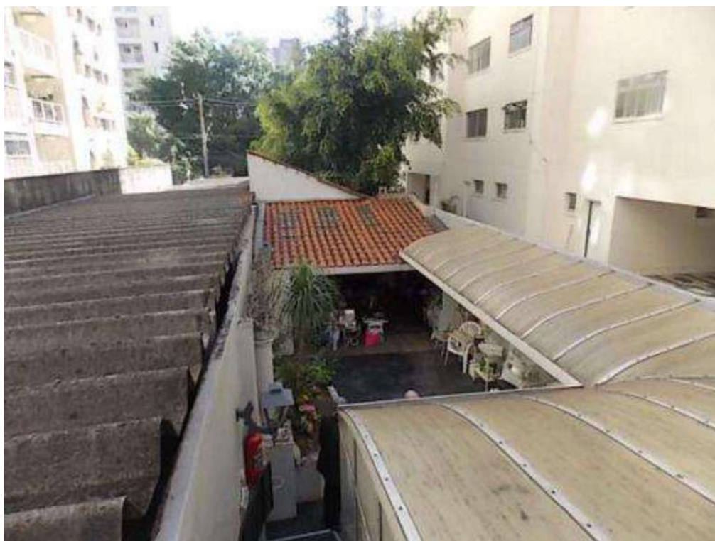
10 – Vista da edícula em direção à edificação principal.
