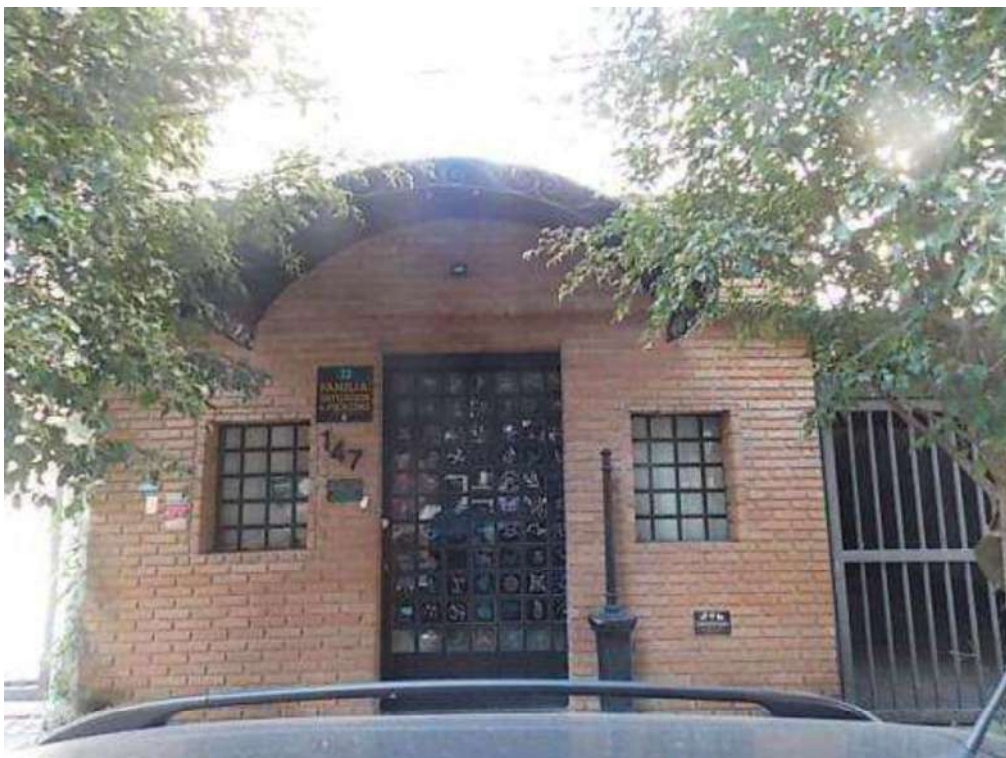
03 – Fachada frontal do imóvel avaliando.
