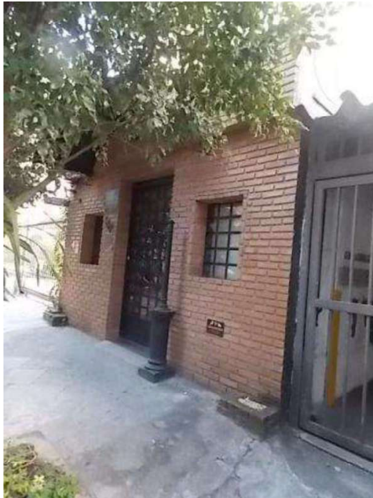
04 – Fachada frontal do imóvel avaliando.
