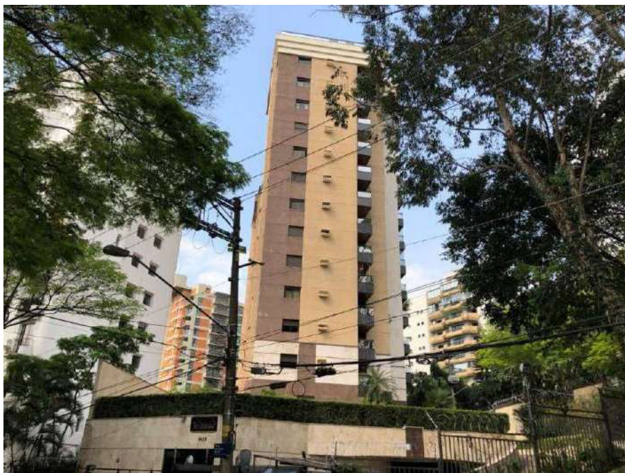
Foto 1. Vista parcial da fachada do edifício.
