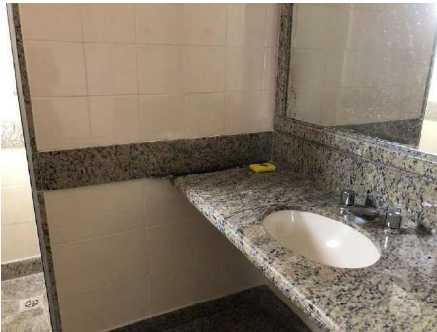
Foto 34. Vista parcial do banheiro da suíte 2.
