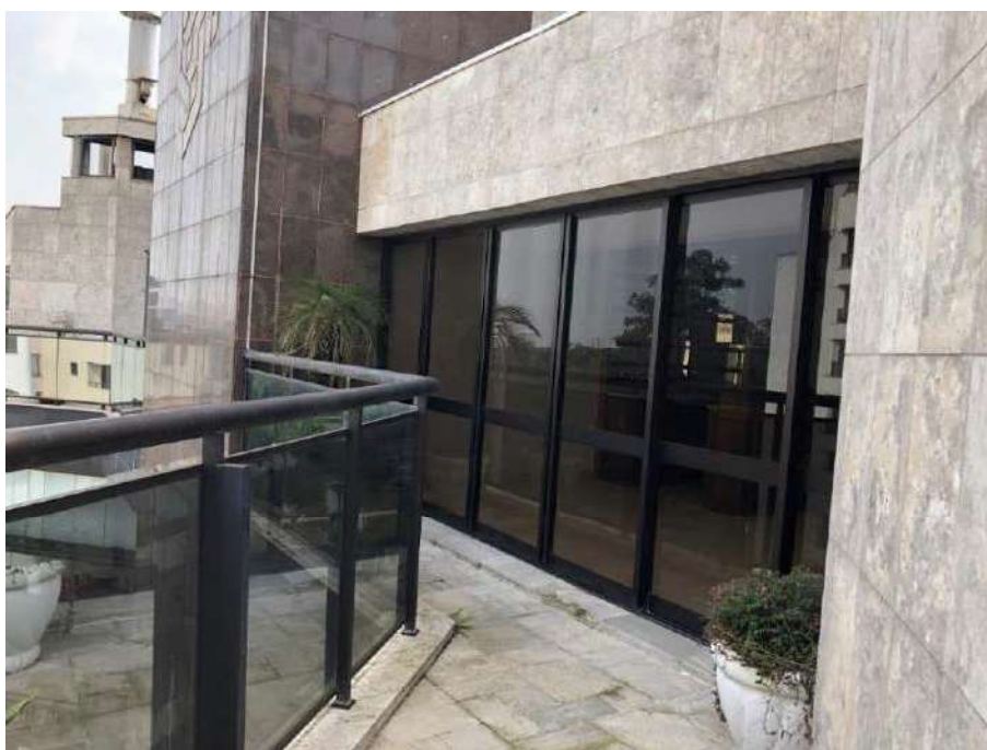
Foto 47. Vista parcial de outro ângulo do terraço do apartamento.
