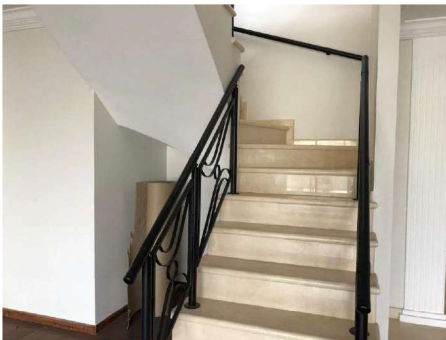
Foto 39. Vista parcial da escada de acesso para o pavimento superior.
