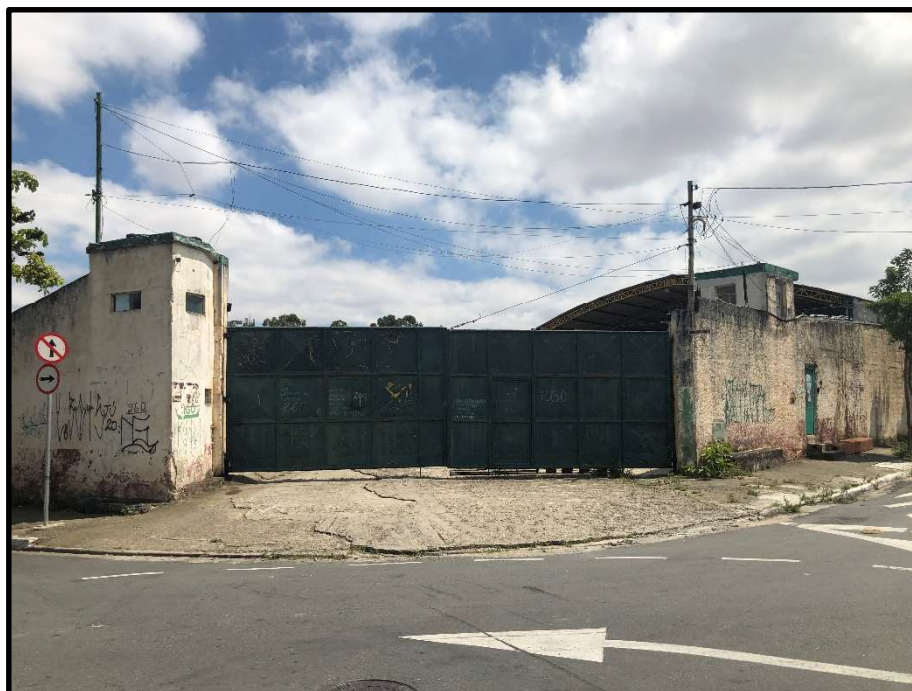
Foto 3 – Rua Guilherme de Almeida nº 260 – Entrada do Imóvel
