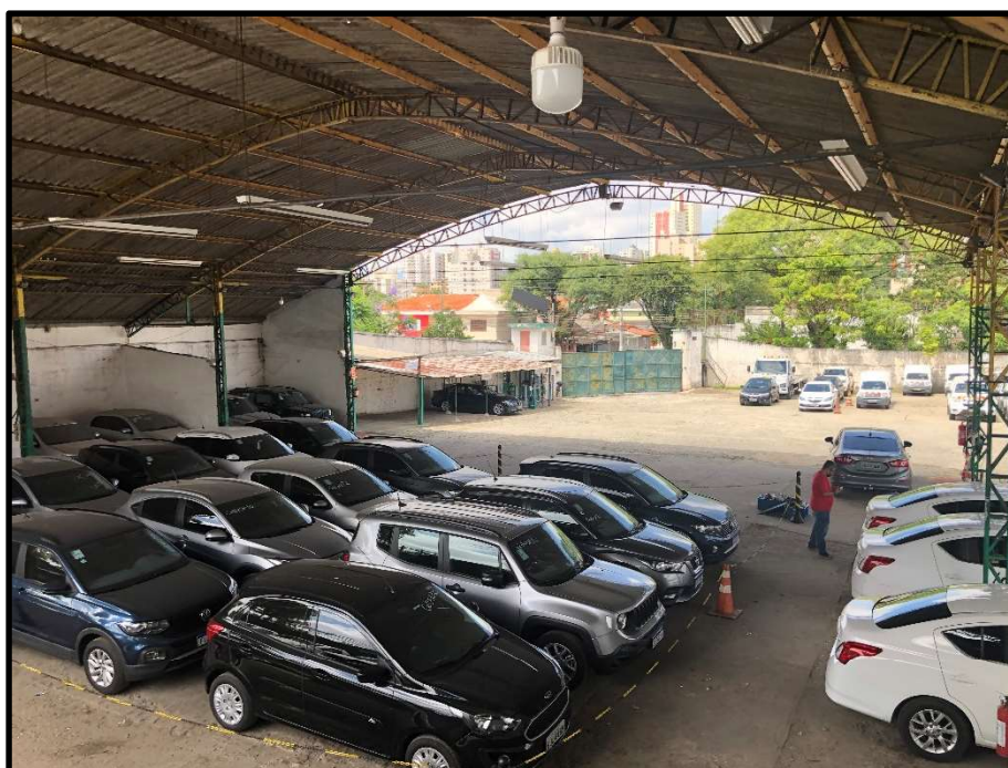
Foto 8 – Vista Geral do Imóvel – Vista 5 – Cobertura 1
