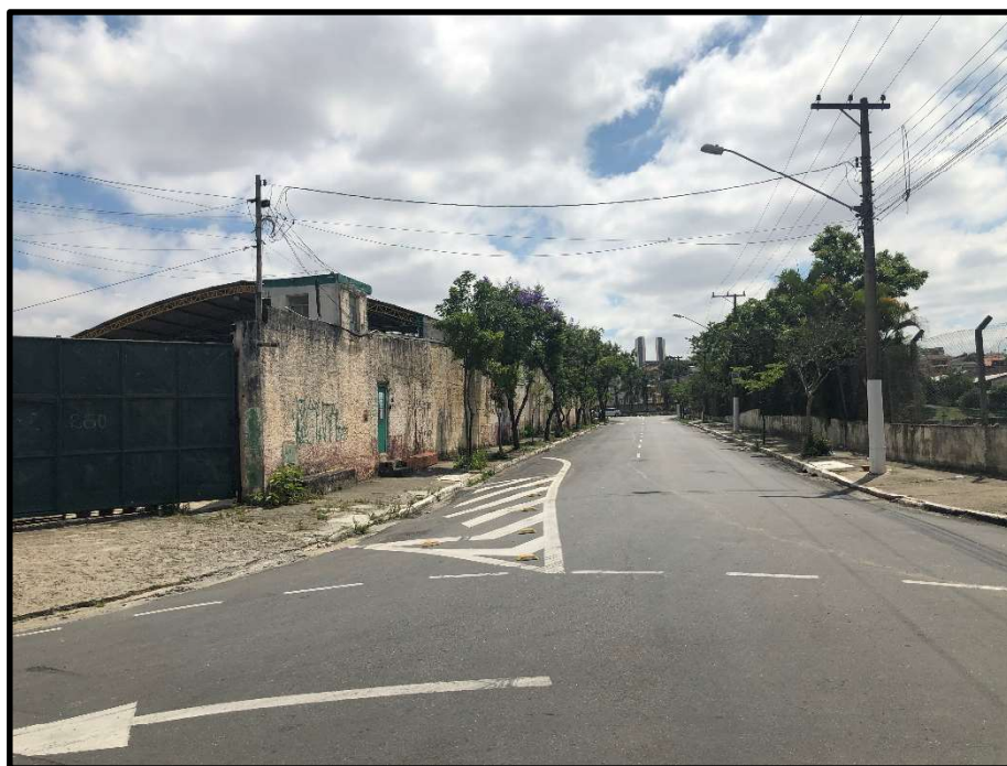
Foto 2 – Rua Abraão Saloti – Vista Geral do Acesso
