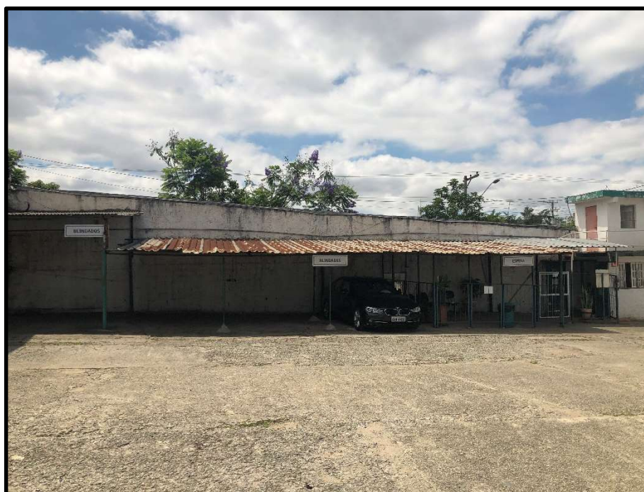
Foto 5 – Vista Geral do Imóvel – Vista 2
