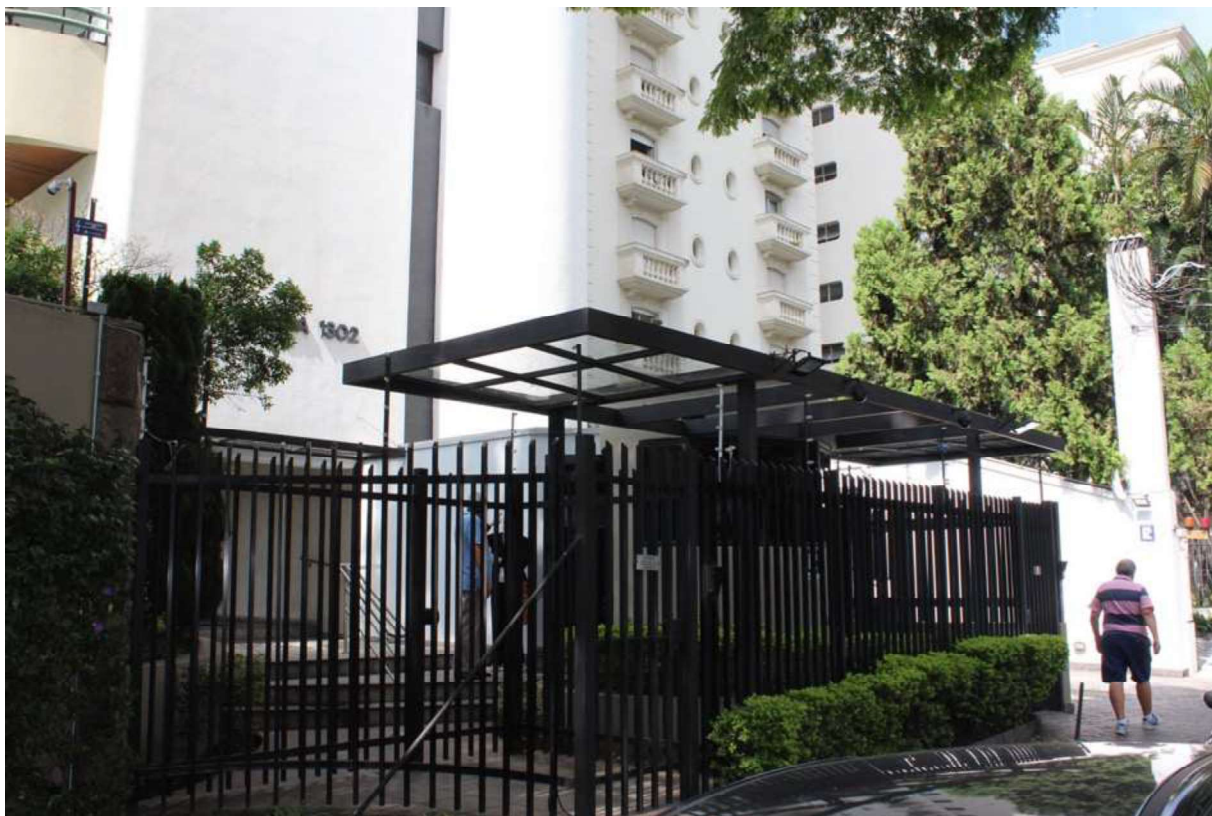
Rua Barão do Triunfo, 1.302 (Condomínio Mansão Caviuna) – Portaria
