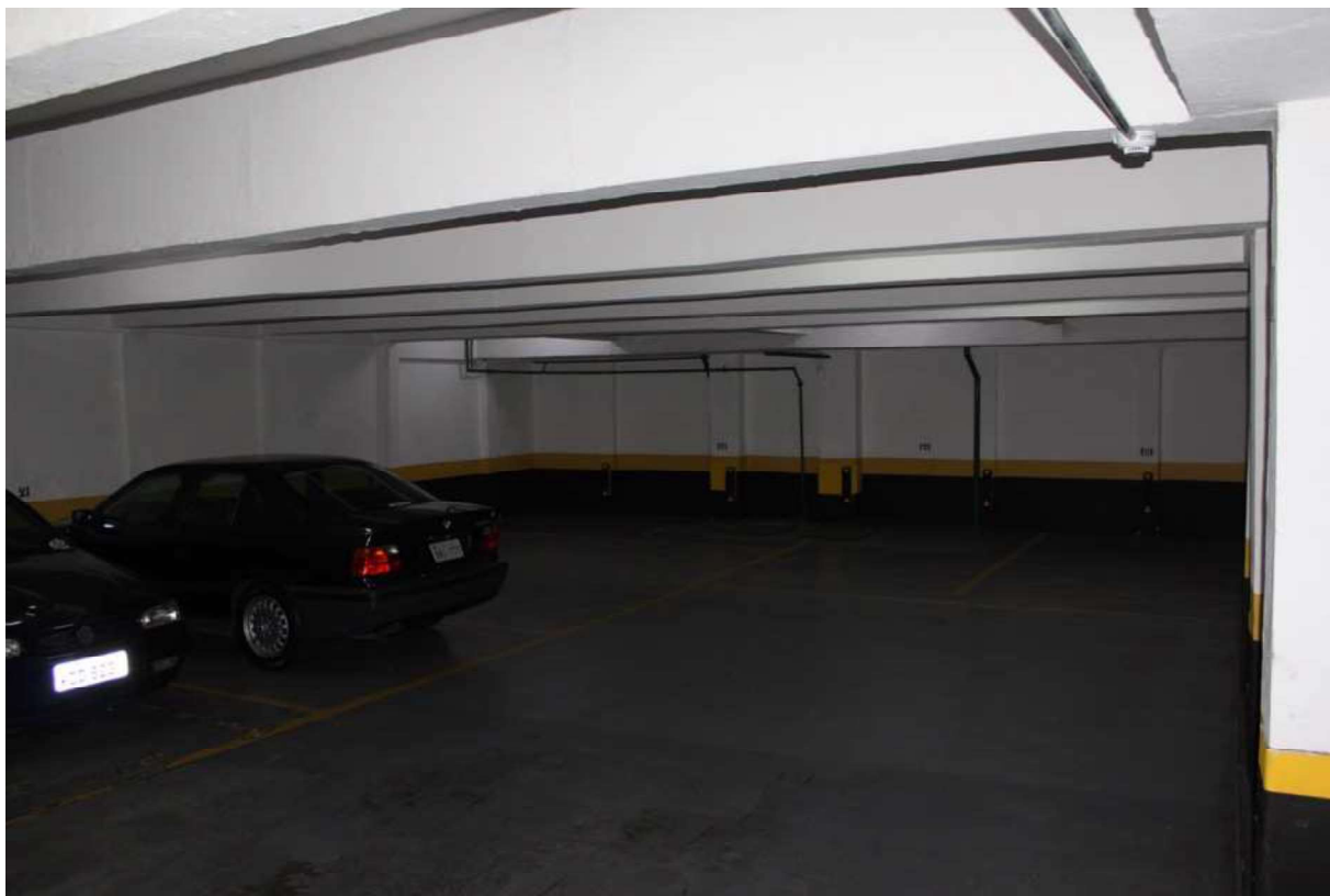
Rua Barão do Triunfo, 1.302 (Condomínio Mansão Caviuna) – Garagem 2º Subsolo
