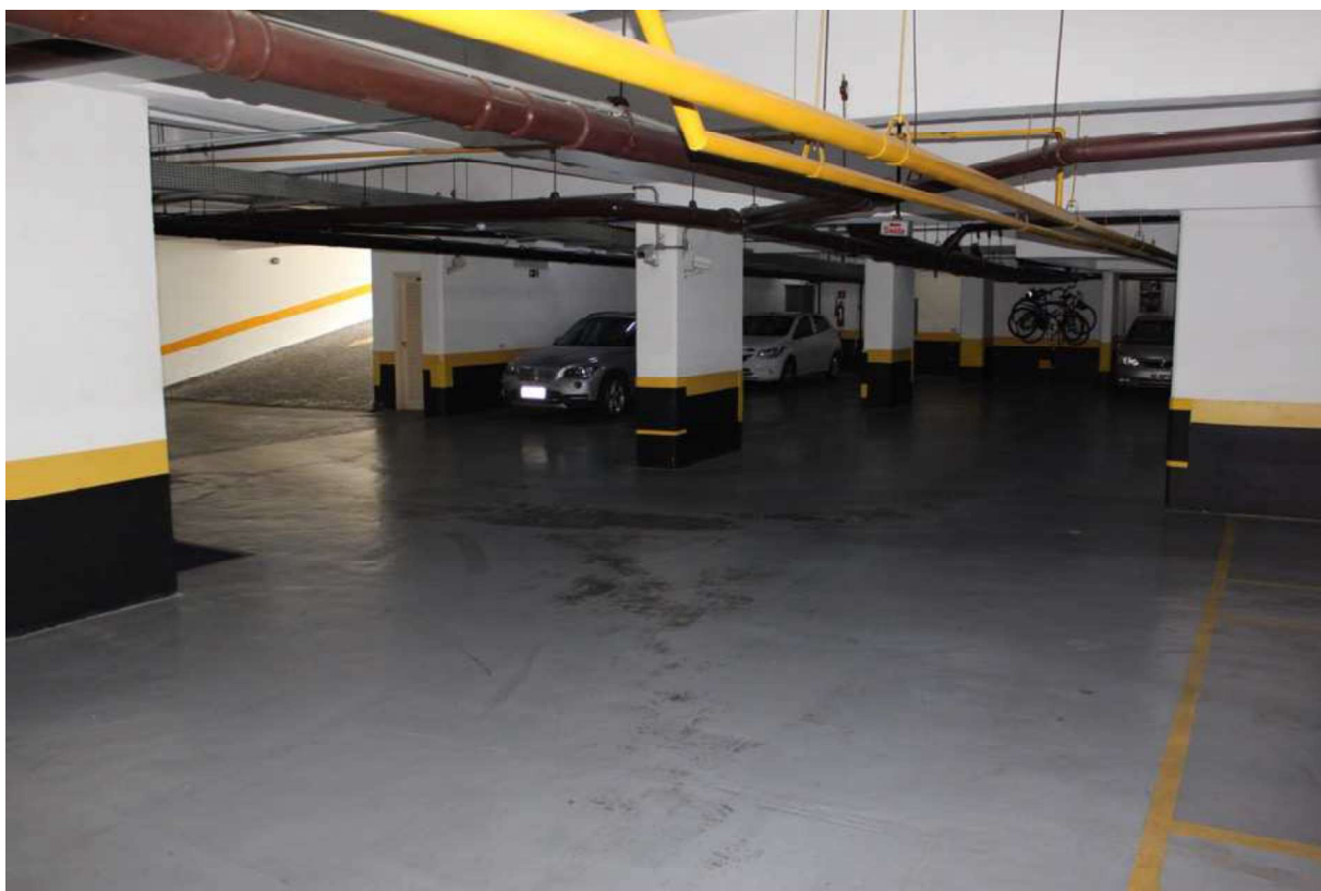
Rua Barão do Triunfo, 1.302 (Condomínio Mansão Caviuna) – Garagem 1º Subsolo
