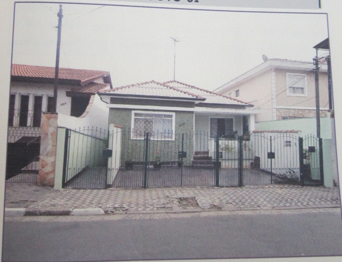
FACHADA DO IMÓVEL AVALIANDO.
