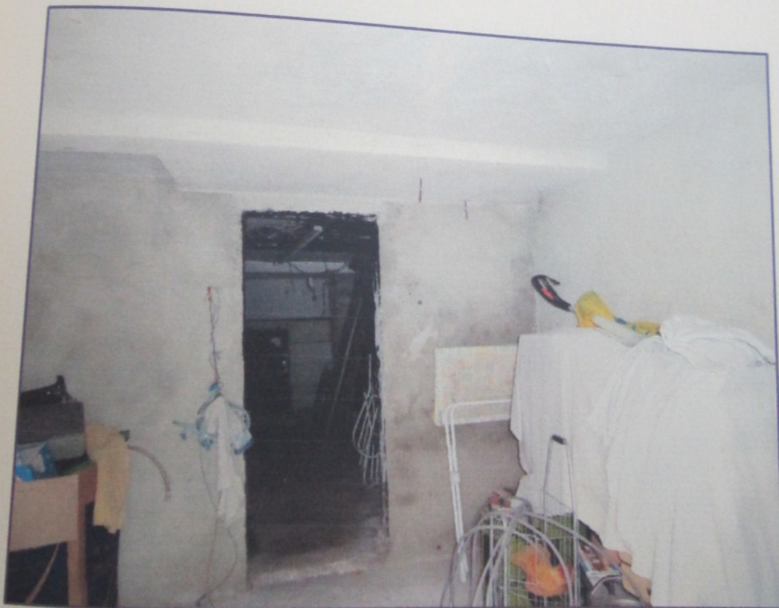
PAVIMENTO INFERIOR - DEPÓSITO
