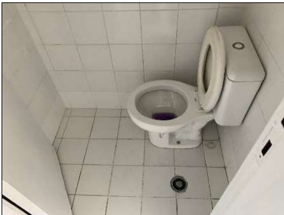
Foto 08. Vista do piso do banheiro do imóvel avaliando.
