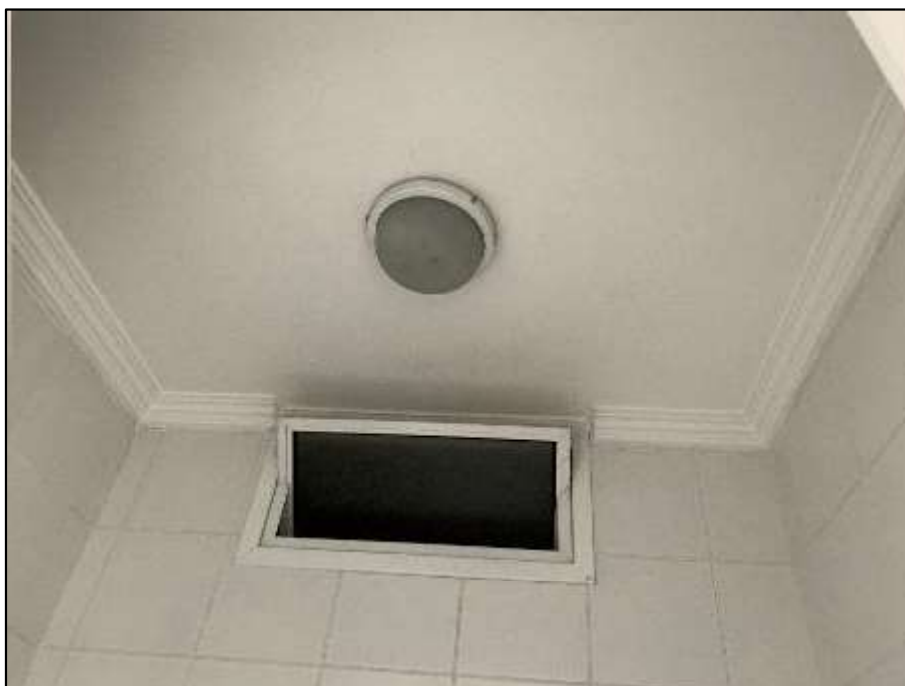
Foto 07. Vista do teto do banheiro do imóvel avaliando.
