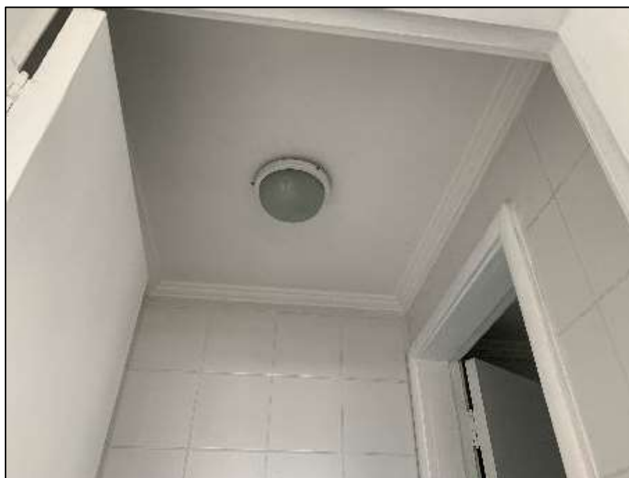
Foto 05. Vista do teto do banheiro do imóvel avaliando.
